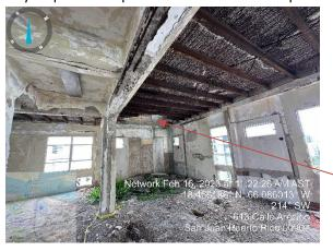
En general la mayor parte de las vigas secundarias de acero presentan altos grados de corrosión y no son reparables por lo que deben ser sustituidas.
