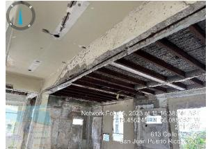
3. Hay esquinas colapsadas de las losas en los pisos superiores.
