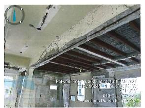
3. Hay esquinas colapsadas de las losas en los pisos superiores.
