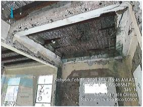
2. Varias vigas secundarias del pórtico central de hormigón están en estado avanzado de corrosión y muestran amplio desprendimiento de la cubierta y perdida de área en refuerzo.
