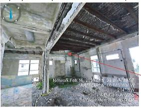
En general la mayor parte de las vigas secundarias de acero presentan altos grados de corrosión y no son reparables por lo que deben ser sustituidas.
