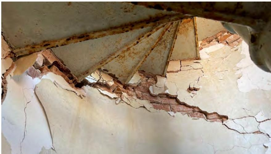
Figura 7. Detalle de la separación de la escalera espiral de la torre cilíndrica.
