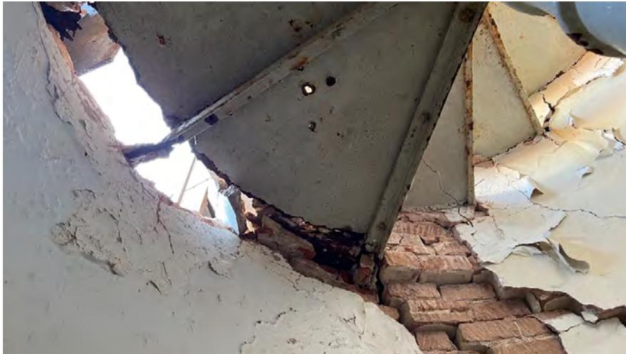
Figura 6. Detalle de la separación de la escalera espiral de la torre cilíndrica.
