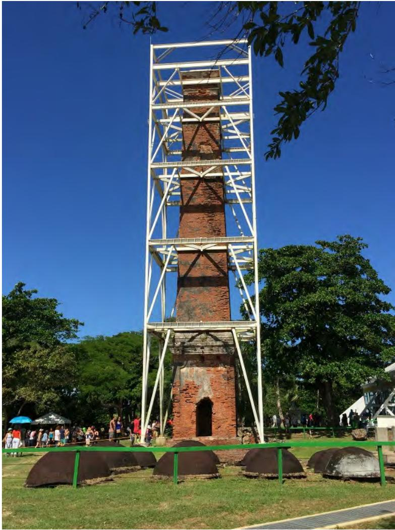
Figura 14. Torre de acero utilizada en la chimenea de la Hacienda La Esperanza par sostener temporeramente la estructura. (Tomado de Pintrest).
