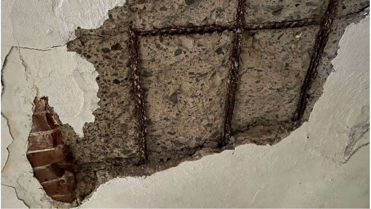
Figura 11. Detalle de las varillas de acero de refuerzo expuestas por desprendimiento de ladrillos y empañetado.
