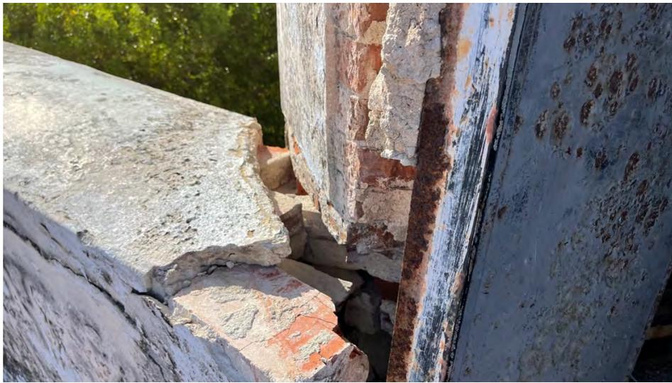
Figura 4. Detalle de la separación de la torre de la estructura principal.
