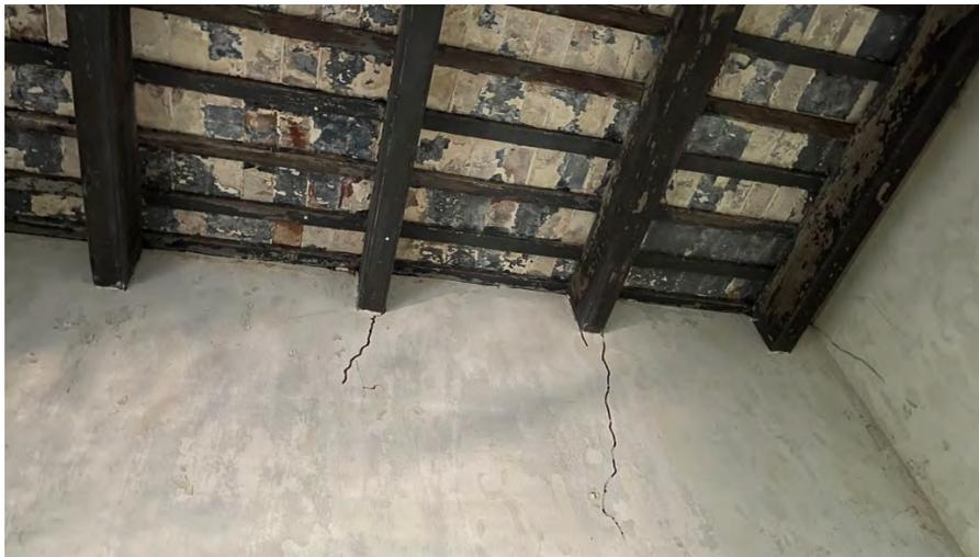
Figura 10. Evidencia de grietas debajo las vigas principales del techo de uno de los salones.
