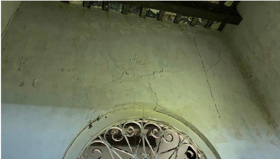
Figura 9. Condición de la parte superior al arco después de los sismos del 2020.
