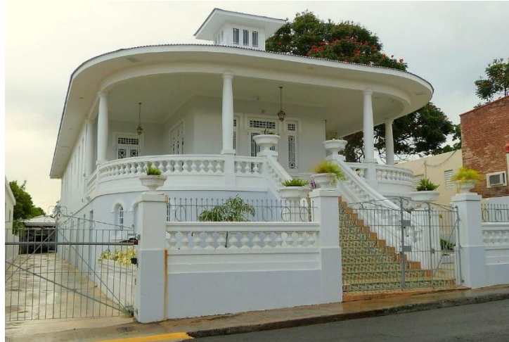
Imagen 4. Fachada Frontal Residencia Berta Sepúlveda
