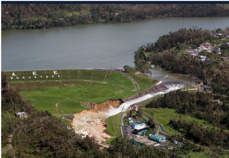
Figura 26: Ruptura de la represa de Guajataca 23/09/2017 1
