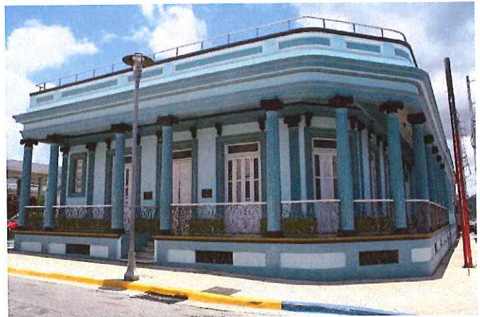
Foto: Vista Fachada Casa Fleming
