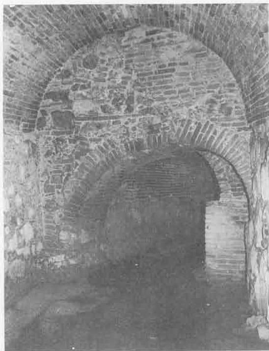
Alcantarilla Pluvial sobre la Quebrada Manzanres, San Germán
