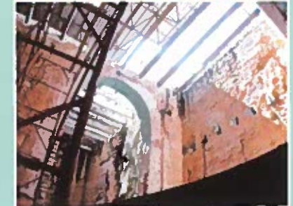
v Rehabilitación edificio de la Real Audiencia
