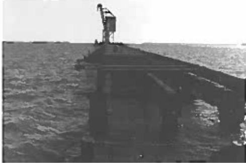
∨ Muelle y grúa de la Central
