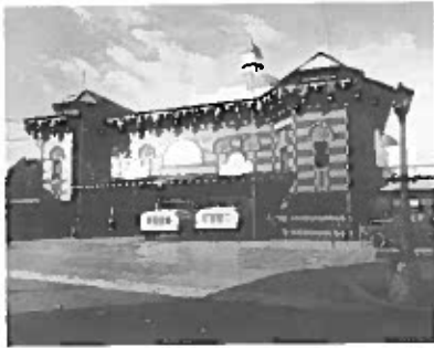
<Parque de Bombas
