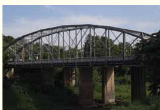
Puente de Trujillo Alto, Trujillo Alto
