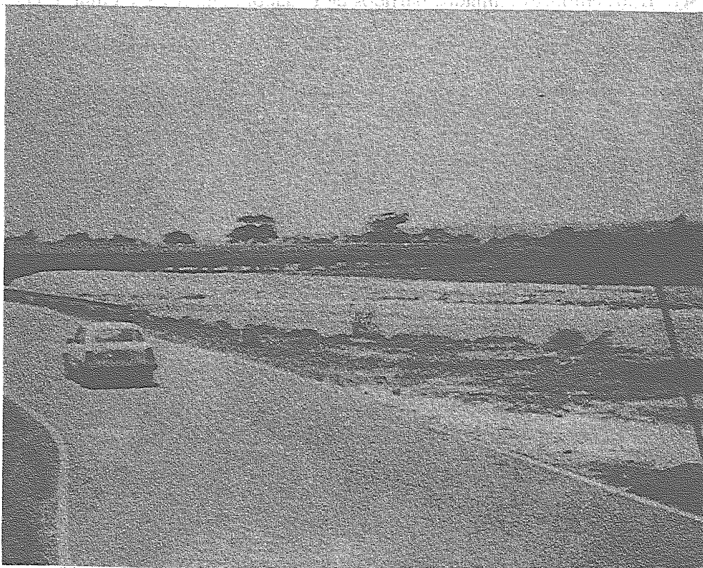
El puente que conecta la marginal con el islote.
