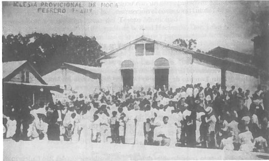
Vista de la Capilla Provisional que tuvo que construirse a consecuencia de los daños ocurridos a la iglesia por los temblores de 1918.
