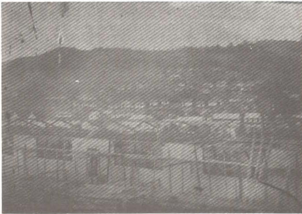
Construcción de la escuela elemental Pedro Arroyo de Orocovis. Al fondo el Cerro la Guaira en el 1915.
