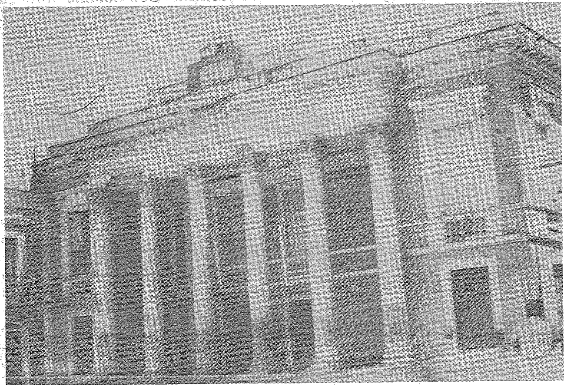
El Teatro La Perla parcialmente destruido.
