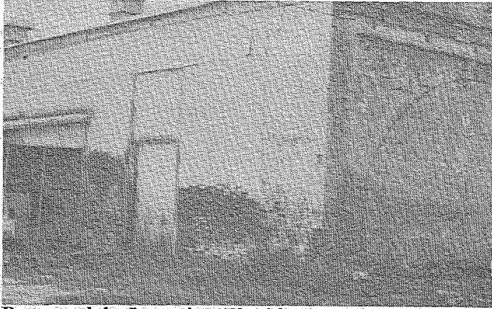
Partes del Ingenio Florida. Notarán arriba, moderno sistema de ventilación. Se trata de un almacén de frutas y viandas.
