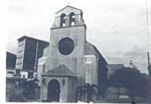
Iglesia de la Santísima Trinidad, Ponce, Puerto Rico
