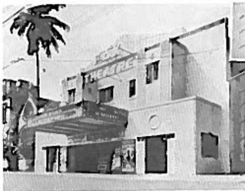
Cine en la Avenida Ponce de León en Miramar.
