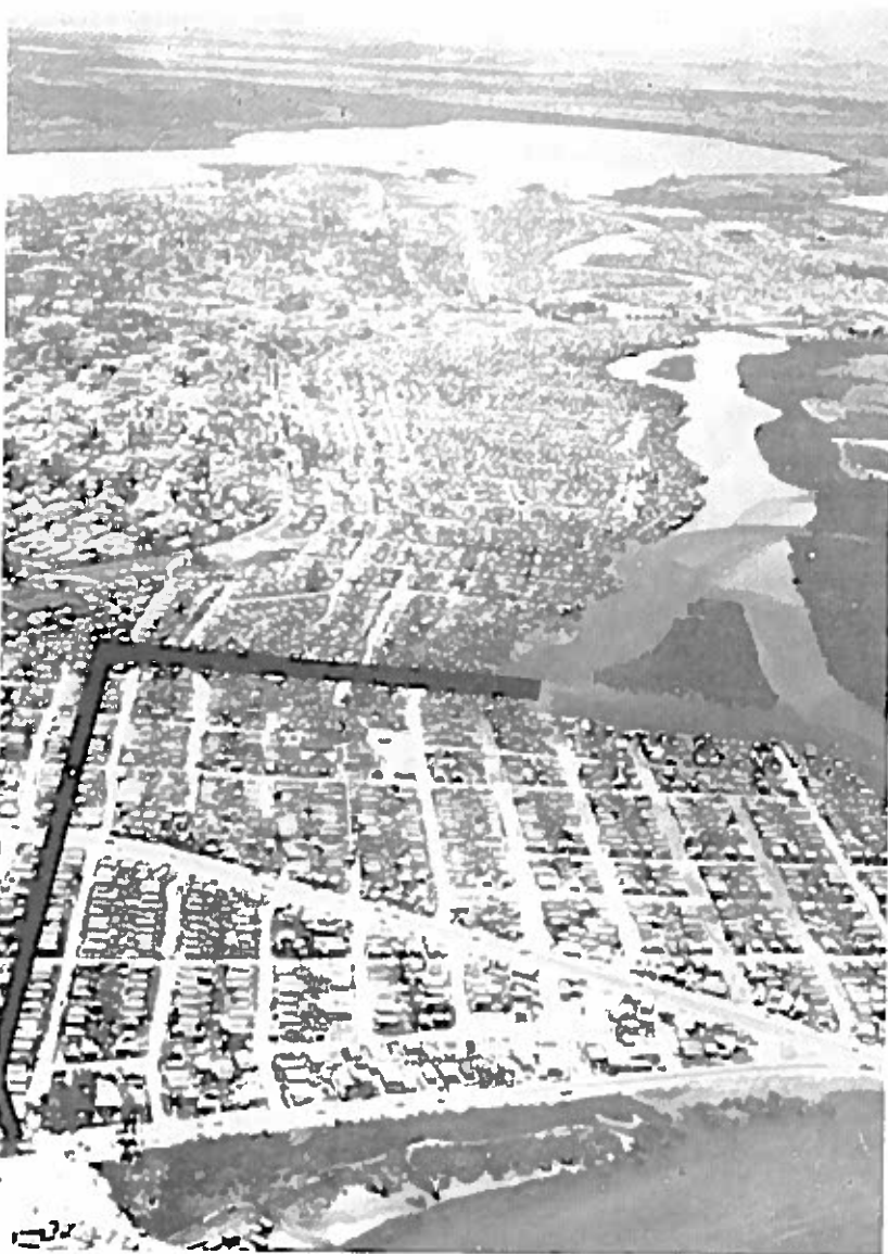
Vista aérea de la zona sur u orilla del Caño de Martín Peña 1952, Picó (1952:50). En primer plano aparece El Fanguito. Con la construcción del Puente de la Constitución esta comunidad fue la primera en ser removida. Desaparecieron posteriormente La Zona, Marruecos y Buenos Aires. De 1950 al presente Santurce perdió la mitad de su población.
