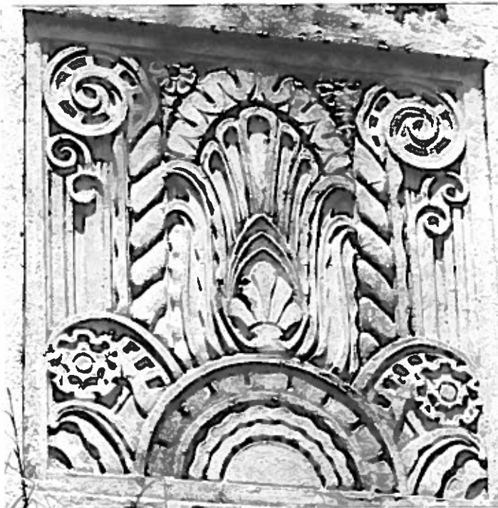
Detalle de pilastra del Puente de Martín Peña 1986.
