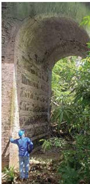
Figura 47. Esta impresionante alcantarilla, localizada en el Km. 11.5, a unos doscientos metros después de la tajea mostrada en la Fig. 46, sigue la técnica tradicional estandarizada para fábricas de arte en la cartilla de 1857. La estructura es parte también del Trozo 1, diseñado por Larrinaga.
