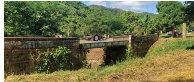
Figura 29. Puente Juana Matos, ubicado en el Km. 14.9, en el tramo Ponce-Adjuntas. Terminado para 1892, el puente combina ladrillo, piedra y mampostería para los estribos, vigas de hierro y planchas metálicas bombeadas para el soporte de la calzada y parapetos de mampostería con barandas metálicas de seguridad. El puente se encuentra hoy en predio privado, dato curioso por demás en términos de titularidad, ya que la PR-123 fue desviada y ampliada a sólo cincuenta metros al noreste del puente.
