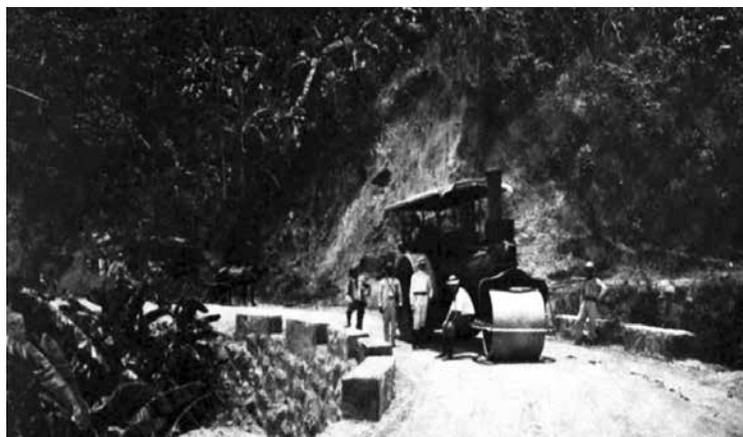
Figura 20. En el momento de la foto, el rodillo de vapor mostrado arriba estaba siendo empleado en Tallones, Adjuntas, el último tramo de la Carretera Núm. 6, terminado para 1904. (Fuente: Informe del Comisionado del Interior, 1901).<sup>44</sup>
