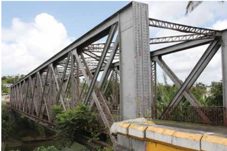
Figura 16. Arriba, dibujo de Mariano Schar de 1889 propuesto para el Puente Arenas. Abajo, foto del 2018. Con celosías de acero y un peso de 23,623 libras, las partes metálicas del Puente Arenas fueron construidas por la destacada firma belga Nicrissé y Decluve por la suma de 56,221 pesos. El ingeniero puertorriqueño Tulio Larrinaga supervisó el montaje de la impresionante estructura en 1894 en su localización actual, PR-735, Km 1.3.<sup>61</sup>
