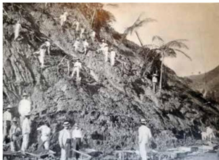
Figura 26. Trabajadores empleados en las fases de desmonte, relleno, nivelación y preparación de la caja para el afirmado en diversos sectores del tramo Adjuntas-Utuado en la Carretera Núm. 6.<sup>52</sup>
