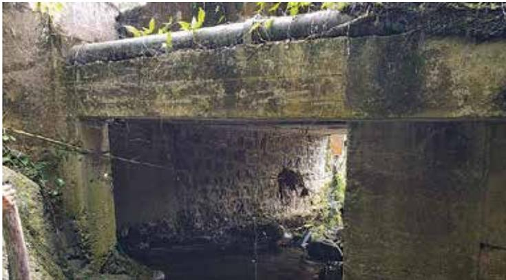
Figura 36. Situado en el Km. 34,7, este pontón de principios del siglo XX utiliza la técnica de juntas de mortero extruido en las paredes internas de los estribos, semejante al método de albañilería ciclópea utilizado por los ingenieros españoles.
