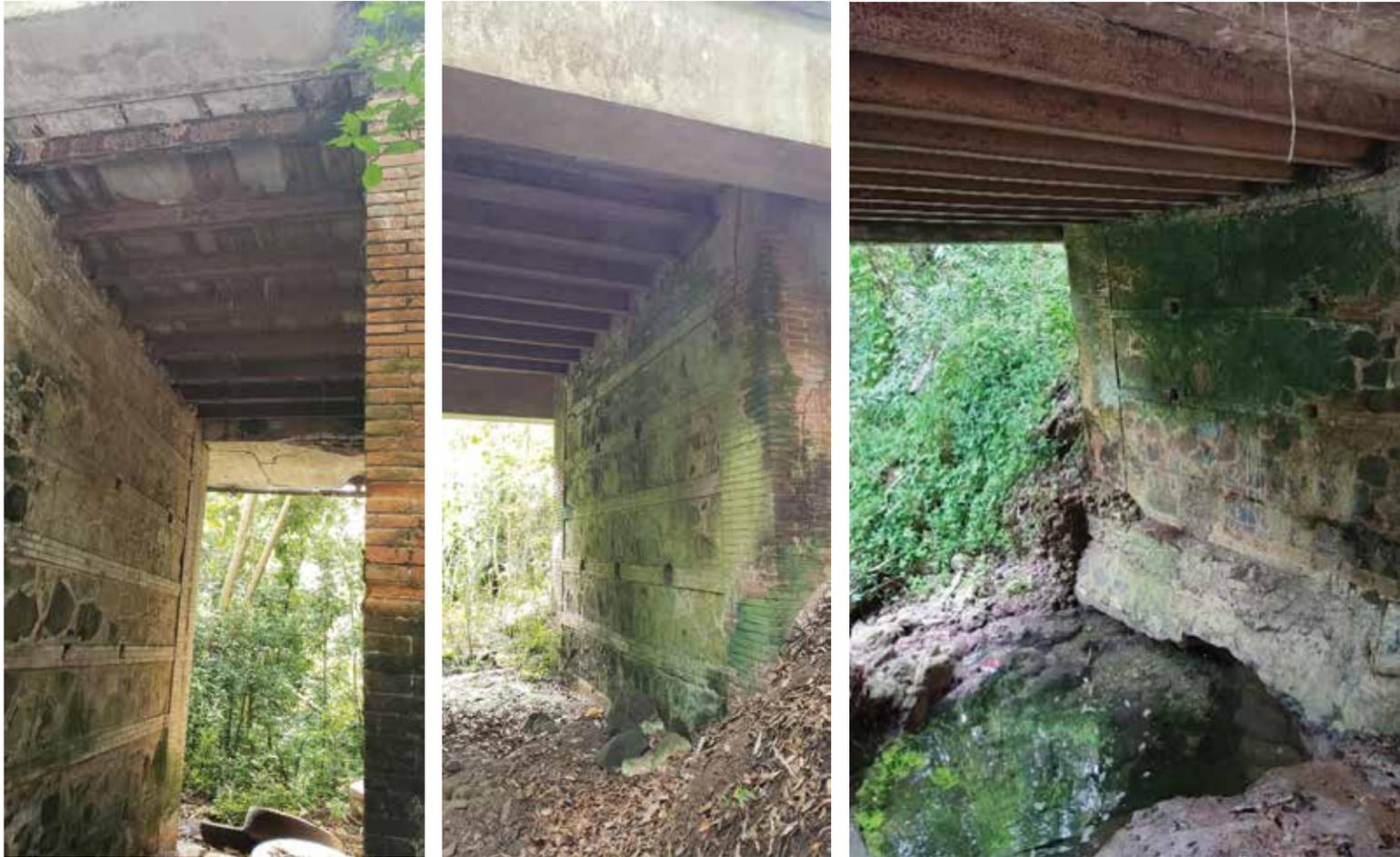
Figura 5. De izquierda a derecha: una alcantarilla de poco más de un metro (localizada en el Km. 13.6) y dos pontones de cinco metros de luz (localizados en los kilómetros 14.3 y 17.7, respectivamente) muestran algunos de los componentes estructurales introducidos por Tulio Larrinaga en la Carretera 6: tramos rectos sostenidos por vigas longitudinales.<sup>14</sup>
