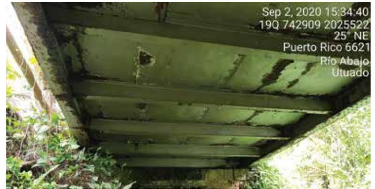
Figura 11. Este pontón de seis metros de ancho, ubicado en el Km. 59,6 en el tramo Utuado-Arecibo, conserva prácticamente todos los componentes estructurales mencionados por Larrinaga para una estructura de este tamaño: estribos de ladrillo y mampostería, vigas transversales de hierro, dos vigas longitudinales principales de hierro e, incluso, las planchas metálicas bombeadas.
