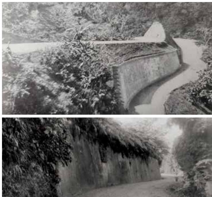
Figura 59. Imagen superior, foto de 1900 de un muro de contención recién construido en un lugar no identificado en la Carretera 6. Le sigue una imagen del mismo recurso tomada por A. Moscioni durante los primeros años del siglo 20. En la página siguiente, foto del mismo muro localizado en el km. 30.9, PR-123. Las fotos proveen una vista parcial de la carretera, sustentando la integridad del desplazamiento horizontal de la calzada.<sup>57</sup>
