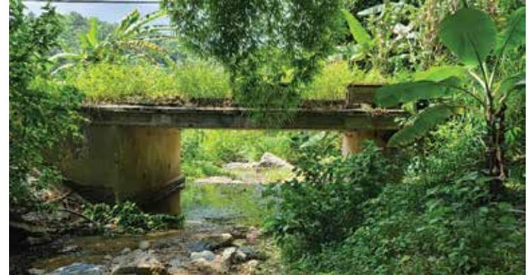
Figura 38. Puente de losa de hormigón de 1920, situado en el Km. 46.7, con su agregado expuesto como elemento distintivo de su periodo constructivo. Este tipo de estructura fue una solución rápida para cruzar obstáculos de agua y muy utilizada por el Departamento del Interior.
