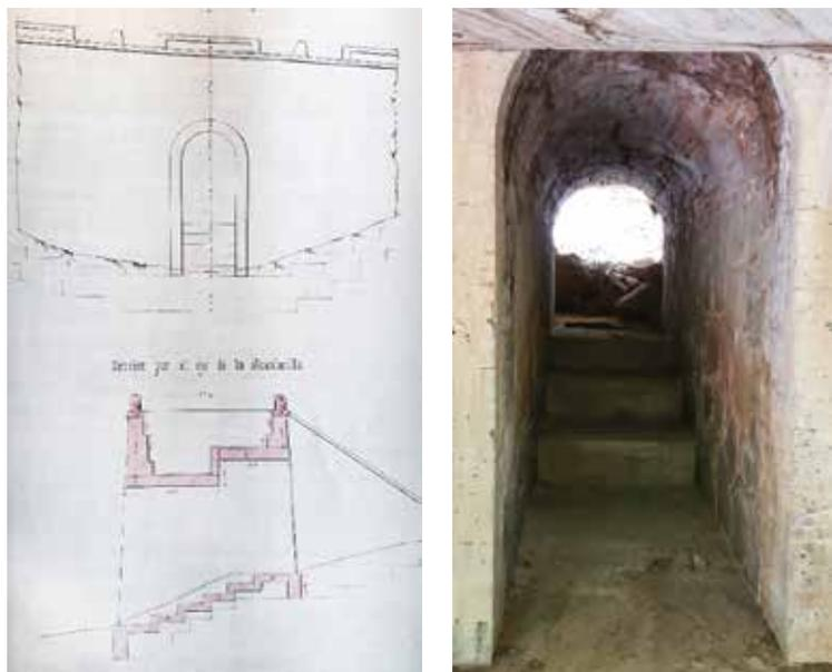
Figura 5. A la izquierda, vista parcial de dibujo de 1890 de Feliz Giráldez para una alcantarilla en la Carretera Núm. 4. A la derecha, alcantarilla en la Carretera Núm. 4, km.3, muestra la aplicación técnica de lo sugerido por Manuel Maese.
