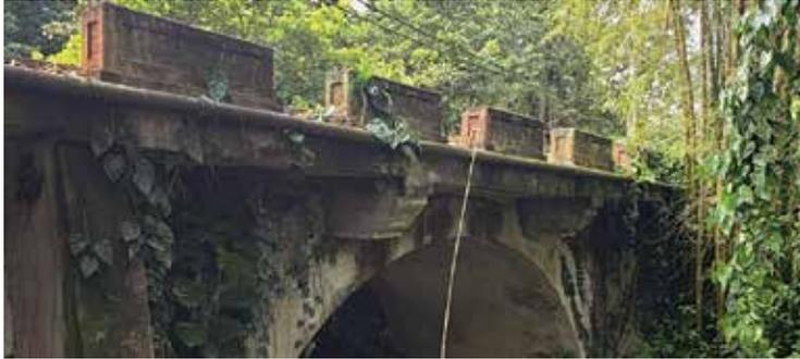
Figura 35. Localizado en el Km. 32, este pontón de hormigón fue uno de los tipos utilizados para reemplazar los de mampostería y ladrillos. Sin embargo, los contrafuertes y la moldura utilizada para acentuar el arco elíptico se asemejan a los del periodo español.
