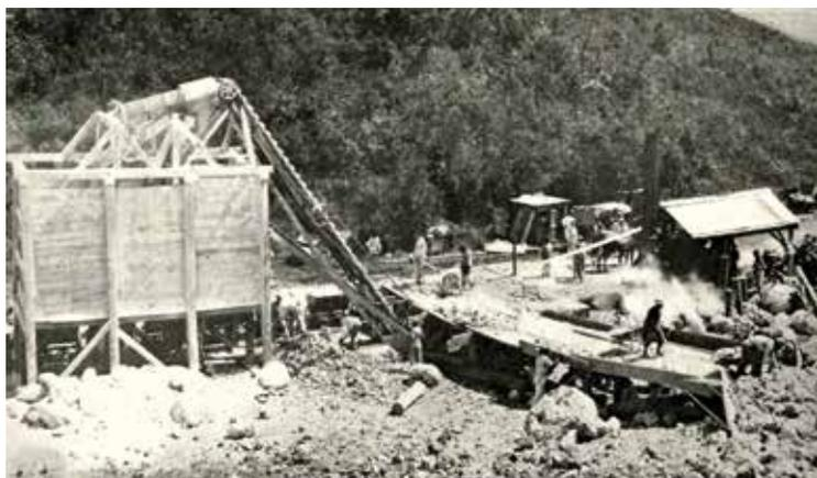
Figura 19. Máquina trituradora de piedra puesta en uso en la Carretera Núm. 6
