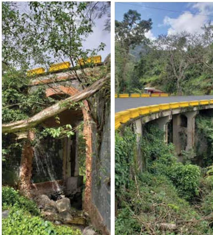
Figura 34. Este impresionante pontón, conocido como el puente Gómez, está localizado en la PR-14, km. 61.9, en Aibonito. La imagen de la derecha muestra las columnas de hormigón de principios de los 1940s, que soportan la ampliación de la carretera, permitiendo una curva cómoda, cónsona con las nuevas regulaciones que exigieron mayor seguridad a medida que el uso de vehículos de motor exigió una Carretera Central más ancha.
