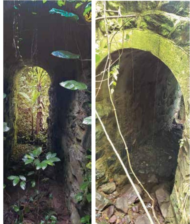
Figura 22. Dos alcantarillas de principios del siglo XX con piedras toscas de revestimiento en los testeros y paredes laterales, y con techos abovedados de concreto hidráulico. Ambas alcantarillas están localizadas en el tramo Ponce-Adjuntas construido por los nuevos ingenieros estadounidenses.
