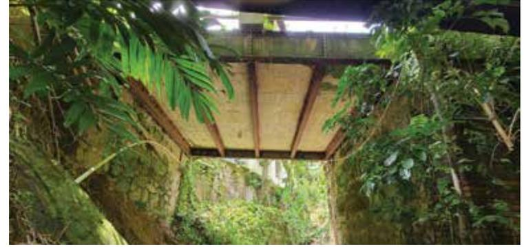
Figura 10. Arriba: la estructura de seis metros contiene los componentes especificados por Larrinaga en la década de 1880 para un pontón de este tamaño: estribos de ladrillo y mampostería, las vigas transversales de hierro laminado necesarias (5 en este caso) y dos vigas longitudinales de hierro de alma llena empotradas en los estribos.
