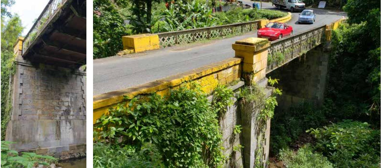
Figura 20. Vista parcial del Puente Quebrada Honda con sus tramos metálicos y estribos en sillería .
