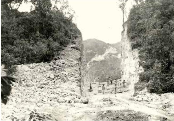
Figura 21. Los cortes de pasos a través de montañas, en particular en la zona cársica de Arecibo (foto superior), requirieron el uso de explosivos. La pólvora y la dinamita fueron los de mayor uso.<sup>45</sup>
