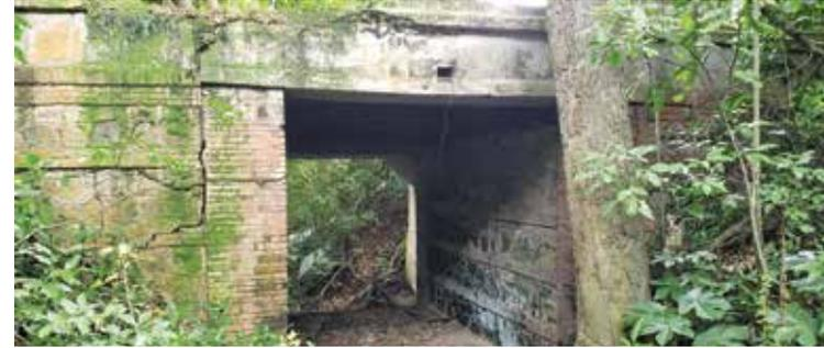
Figura 28. Pontón del siglo XIX con estribos de ladrillo y mampostería. El techo recto y sus vigas longitudinales de hierro originales reflejan la influencia de los conceptos constructivos de Tulio Larrinaga. Los parapetos son un añadido de principios del siglo XX. La estructura se encuentra en el Km. 14.0.
