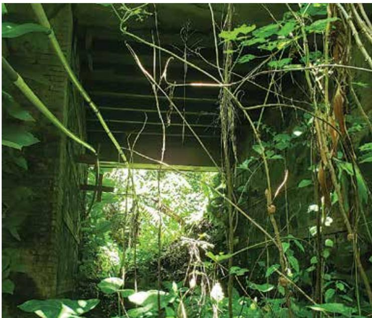
Figura 30. Pontón en el Km. 15.5 con sus estribos de piedra, ladrillo y mampostería del siglo XIX, y sus vigas longitudinales de hierro, también del siglo XIX, que soportan la moderna calzada de asfalto.
