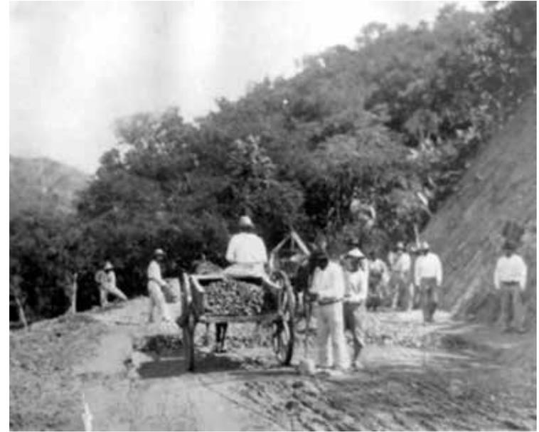
Figura 9. Obreros colocando macadán sobre una caja ya formada.<sup>18</sup>
