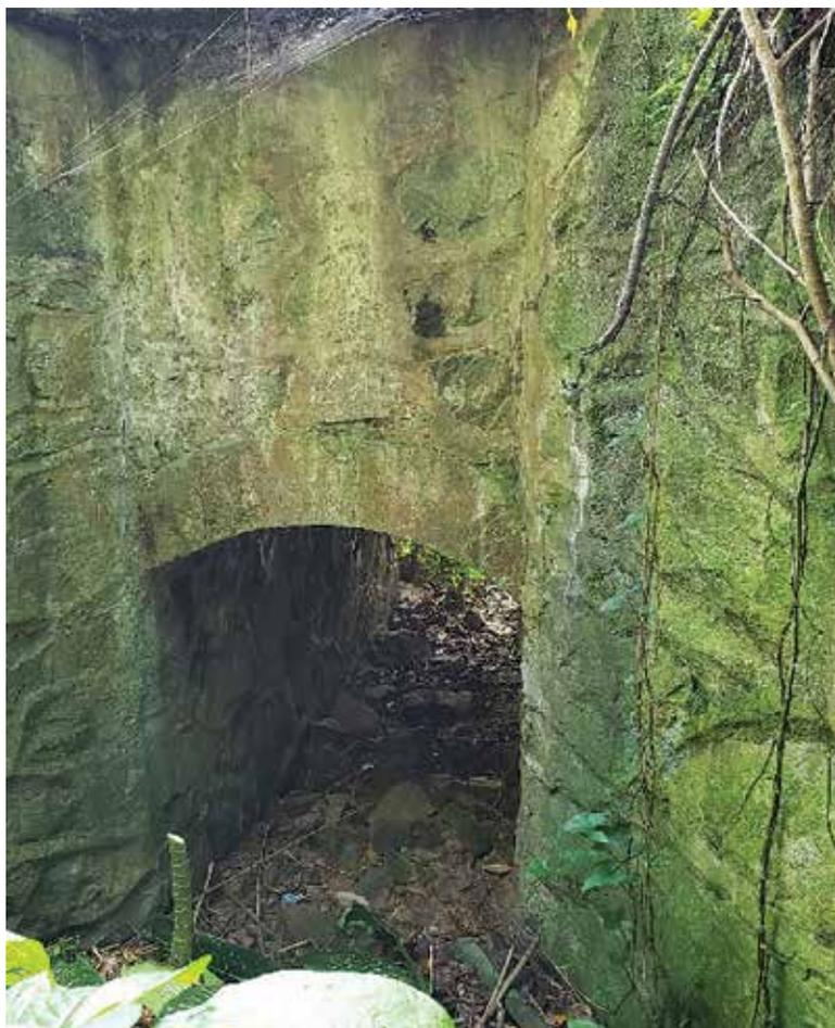
Figura 51. Vista exterior e interior de una alcantarilla de principios del siglo XX localizada en el km. 29.5 en el tramo Ponce-Adjuntas.
