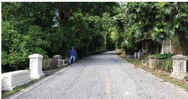
Figura 32. Barandillas metálicas del siglo XIX —acompañadas por pedestales de estilo clásico junto con los parapetos tradicionales— asentadas sobre una alcantarilla localizada en el Km. 16.9.
