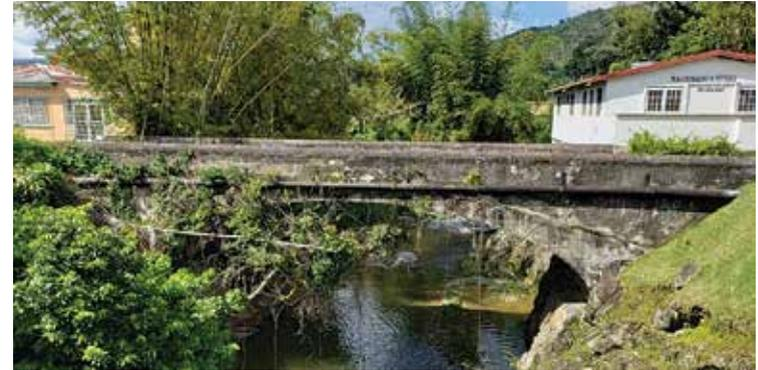
Figura 37. Justo cuando la Carretera Núm. 6 deja el núcleo urbano de Adjuntas en su camino hacia Utuado, este puente de hormigón armado, de arco elíptico de 16,8 metros, fue construido en 1901 sobre el Río Cidra. Utilizado como puente peatonal en la actualidad, se encuentra en el km. 35.8.
