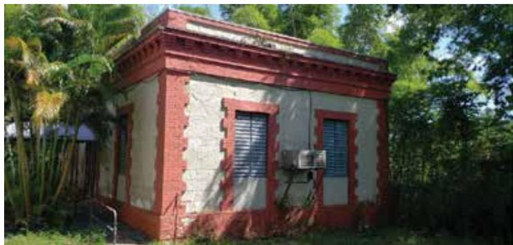
Figura 12. Arriba, foto tomada en la década del cincuenta de la casilla de peón caminero en la antigua Carretera Núm. 6, hoy PR-123. Localizada en el antiguo Km. 9, (hoy Km. 15), la casilla muestra sus paredes de bloques rectangulares de piedra caliza, con aristones, cornisas y molduras de los vanos en ladrillos.
