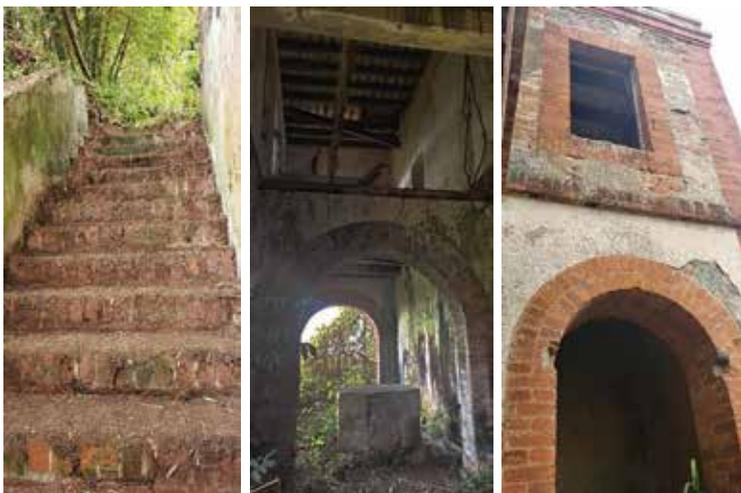
Figura 8. Casilla Km. 23.3, PR-15. Las fotos actuales del recurso muestran su alineación con la carretera y la parte posterior. Esta es la única casilla en la Carretera Núm. 4 y en todo Puerto Rico elevada con basamentos, según propuesto por Enrique Gadea.
