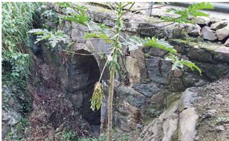
Figura 49. Km. 26.0. La foto muestra la expansión realizada en la carretera entre 1930 y 1940 y que impactó la alcantarilla de principios del siglo XX. La alcantarilla muestra la ampliación en su fachada este (arriba), mientras que presenta su técnica constructiva de principios del siglo XX (1899-1904) en su fachada oeste (abajo).
