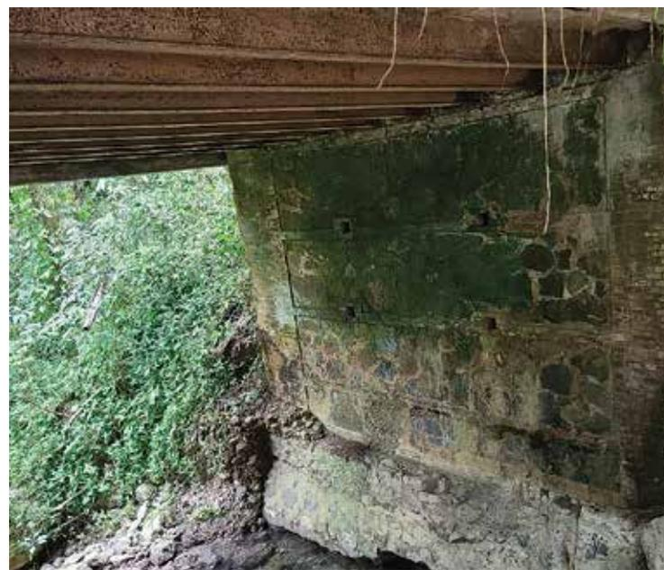
Figura 31. Vista parcial de un puente del siglo XIX con sus estribos de piedra, ladrillo y mampostería, construido sobre la base de roca natural. Se pueden observar sus vigas longitudinales de hierro originales que soportan la moderna calzada asfaltada. La estructura está ubicada en el Km. 17.7.
