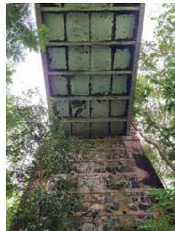
Figura 6. Actualmente abandonado y circunvalado por una moderna desviación de la PR-123 (Carretera Núm. 6), el Puente Quebrada Juana Matos de 1892 —todavía impresionante y contribuyente— se asienta en un solar privado. La estructura conserva todos los componentes descritos por Larrinaga en su plano de 1884. Los ladrillos utilizados tienen la frase “La Merced” repujada a bajo relieve y que indica que fueron producidos por la compañía ponceña.
