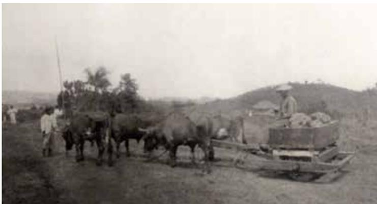
Figura 11. Tipo de cilindro de rodadura utilizado en la Carretera Central.
