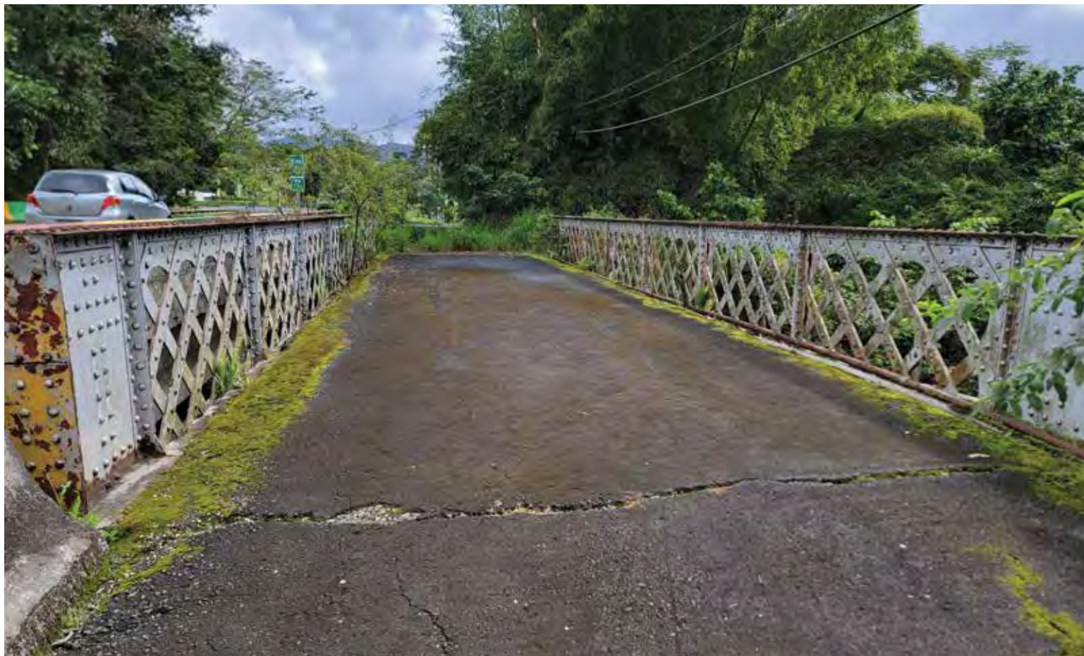
Puente La Liendre, PR-735, km 0.7, Cayey (RNLH-19 de julio 1995)
