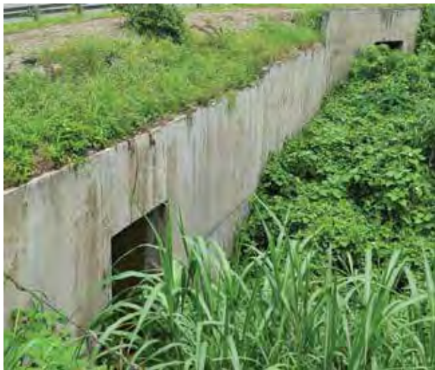
PR-123, km 39.9, Adjuntas (alcantarillas gemelas)
