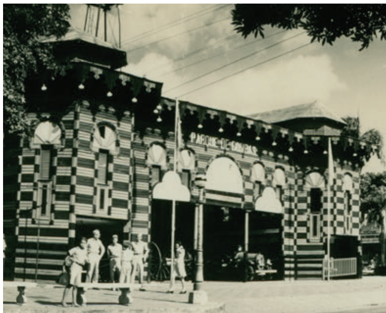
PARQUE DE BOMBAS, PONCE. (OECHPR/AGPR)
