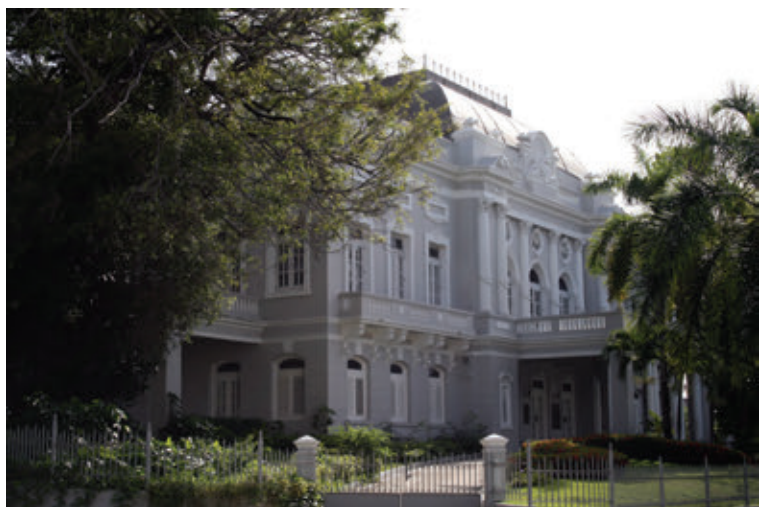
CASINO DE PUERTO RICO, VIEJO SAN JUAN [HOY CENTRO DE RECEPCIONES DEL DEPARTAMENTO DE ESTADO]. (APC)
