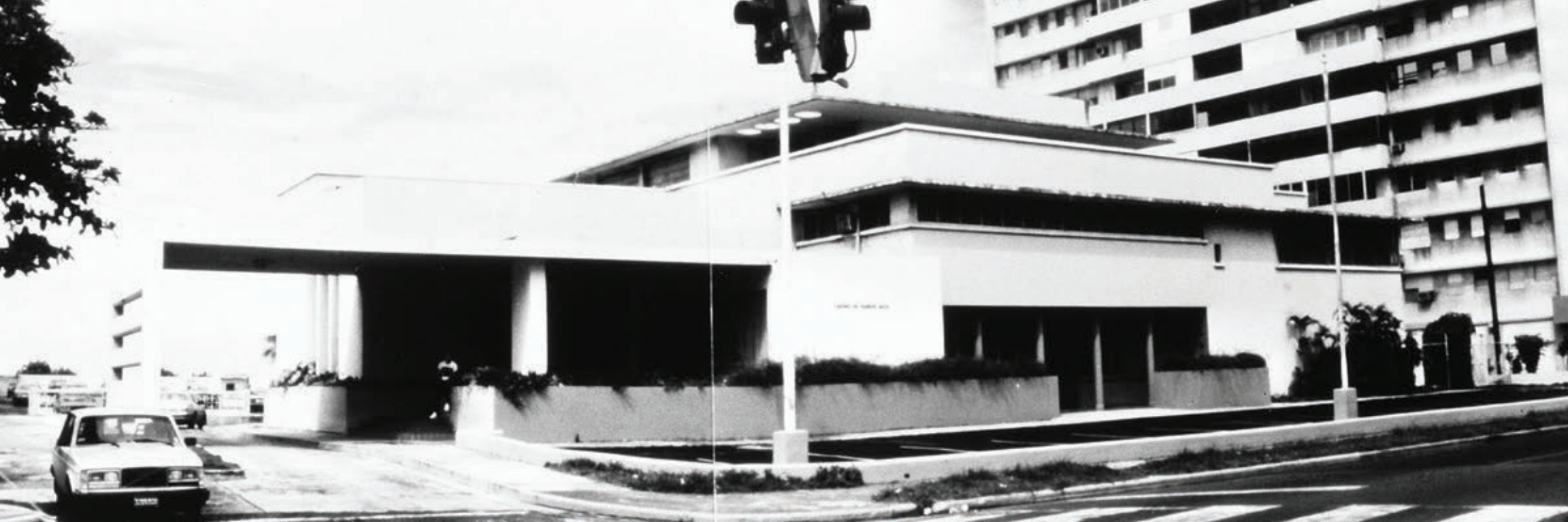
CASINO DE PUERTO RICO, CONDADO. (APC)
