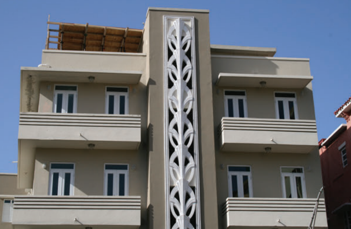
CONDOMINIO, MIRAMAR. (APC)
