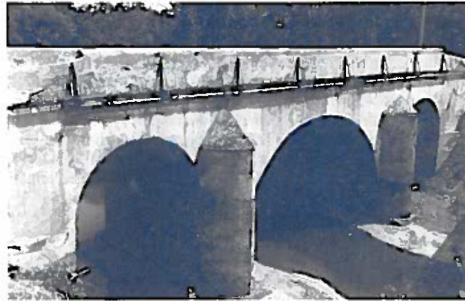
Foto No. 2. Lugar (Site) No. 30. Puente de Río Piedras. Río Piedras Bridge. 1853.
