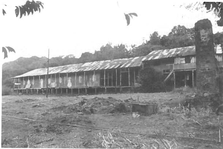
FOTO 23 Casa Grande y de Máquinas. El extremo izquierdo corresponde a la Casa Grande; el espacio sin paredes en el centro era el establo de caballos. La parte de dos plantas es Casa de Máquinas: arriba, están la máquina tahona y el cuarto de medir; abajo estaban la rueda hidráulica, despulpadora y tanques. La chimenea perteneció a un trapiche que suplía azúcar o melao a la tienda de raya. Hacienda Santa Clara, Yauco, 1988.
