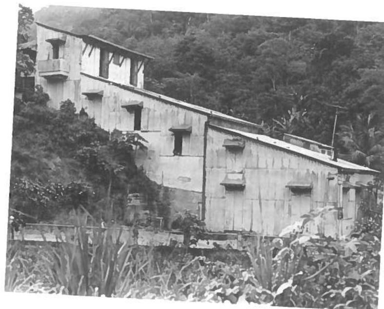
FOTO 11 Hacienda fundada c.1912. Su Casa de Máquinas escalonada aprovecha bien la topografía, y elimina la necesidad de dragas mecánicas al tener la maquinaria en plataformas escalonadas de manera que el café caiga por gravedad de una máquina a la otra. Hacienda Burenés, Ponce. U.P.R., 1978.
