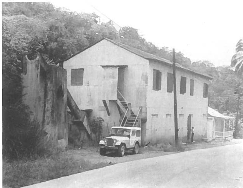
FOTO 22 Casa de Máquinas con tubería para turbina. El tubo en carga, el cual era alimentado por un acueducto ya desaparecido, baja hasta una turbina ubicada en el fondo de un foso bajo el piso del cuarto de máquinas. La escalera exterior da acceso directo al cuarto de medir. Hacienda Mayol (Luz de Luna), Adjuntas. U.P.R., 1978.
