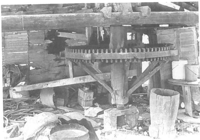
FOTO 30 Malacate de fuerza de sangre en madera. La viga giratoria, de la cual tiraba una mula, está a la izquierda. La máquina despulpadora que se movía por medio de este malacate quedaba detrás del tabique de madera ubicado al fondo. Hacienda León, Coamo. U.P.R., 1978.
