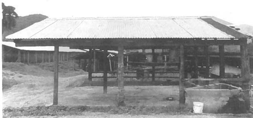
FOTO 16 *Cuadra de Mulas*. En la esquina derecha queda el bebedero. Colocadas a lo largo de la viga periferal del techo hay una serie de placas con los nombres de las mulas. Falta la canal de madera del comedero. En esta cuadra se llegó a atender hasta 20 mulas. Hacienda Balear, Adjuntas, 1988.
