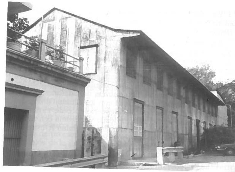
FOTO 46 Casa de Máquinas de *G. Llinás & C<sup>o</sup>*., Yauco. La segunda planta, dedicada principalmente al escogido de café a mano, se le añadió c.1913. La parte trasera, más alta, albergó originalmente la maquinaria de vapor. 1988.
