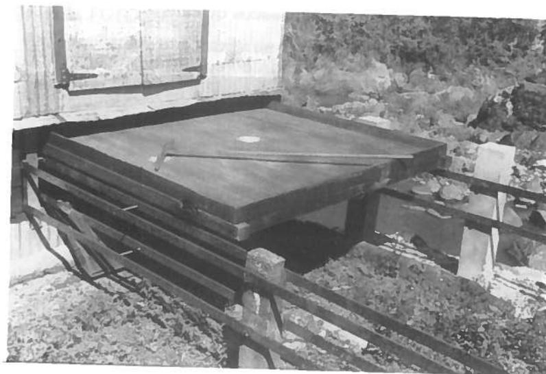
FOTO 28 Gaveta, correderas y rastrillo de madera. Bajo este almacén se protegen dos niveles de cajones o gavetas. Los rieles son metálicos con soportes de hormigón. Hacienda Jardines (Enseñat), Las Marías, 1988.
