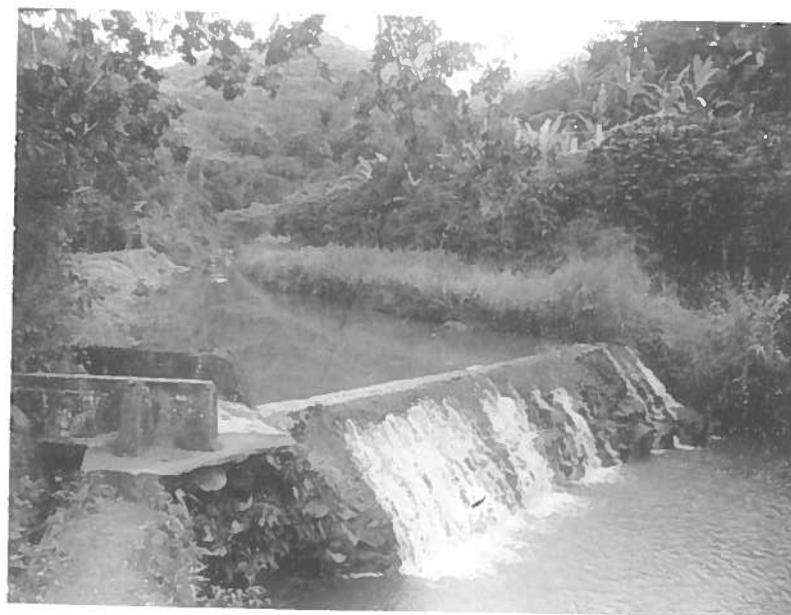
FOTO 31 Represa para fuerza hidráulica. A la izquierda comienza el canal que conduce el agua hasta la Casa de Máquinas de la hacienda. Una compuerta colocada en ese punto controla el flujo. Hacienda Jardines (Enseñat), Las Marías, 1988.
