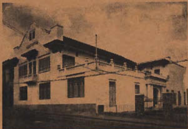
Edificio recién construido en 1923 según diseño de Luis Perocier
