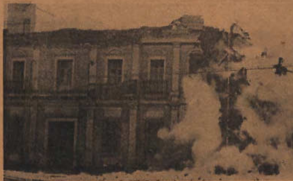
Demolicion después del terremoto
