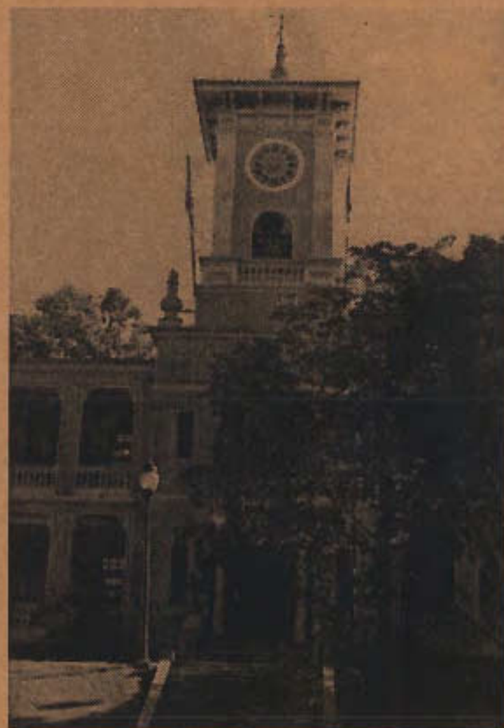
Edificio de Administración, hoy de Diego actualmente después de ser remodelado
