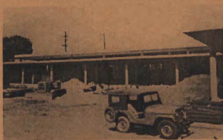
Construcción nueva Plaza del Mercado en la década de 1960
