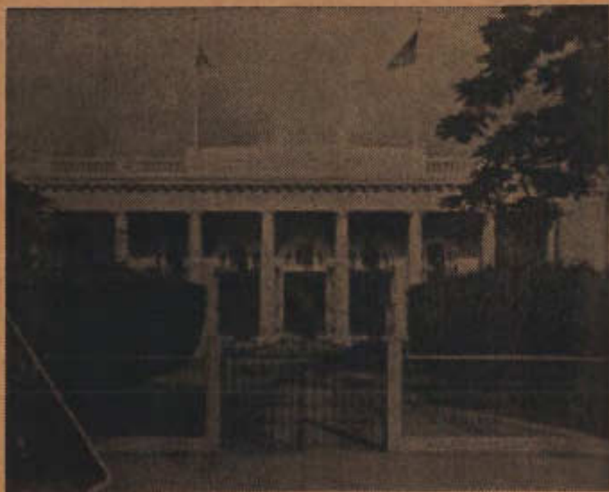
Aduana recién construida
