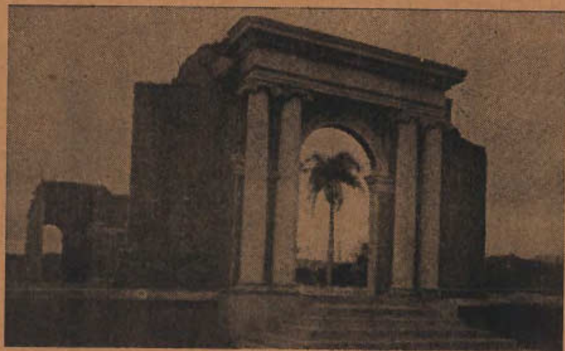
Edificio Degetau después del terremoto
