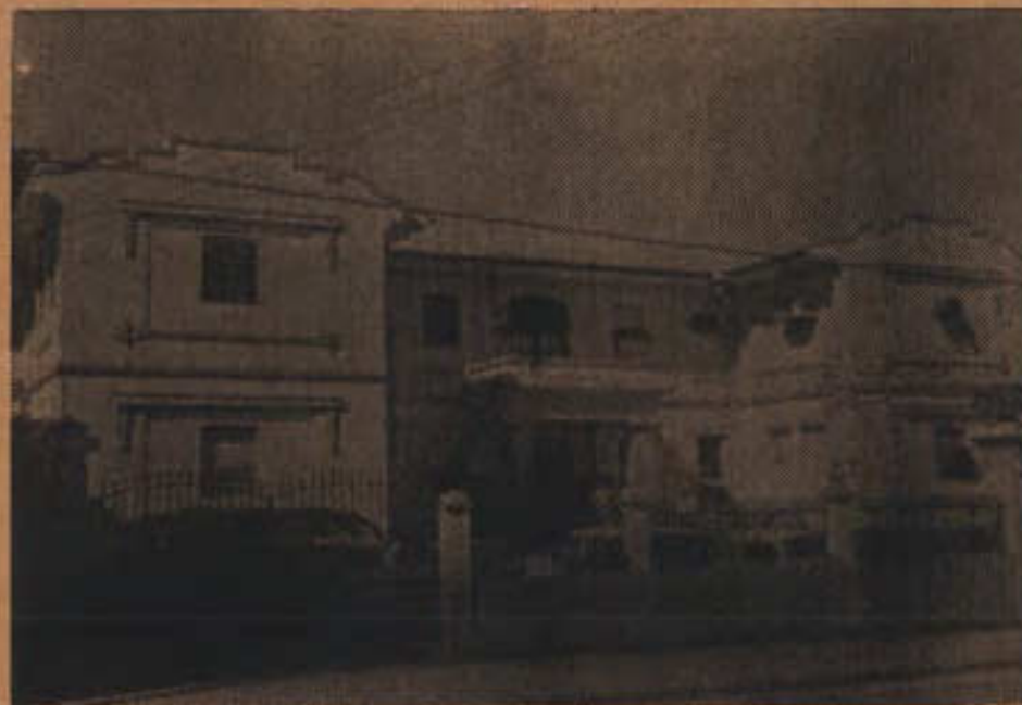
Edificio después del terremoto
