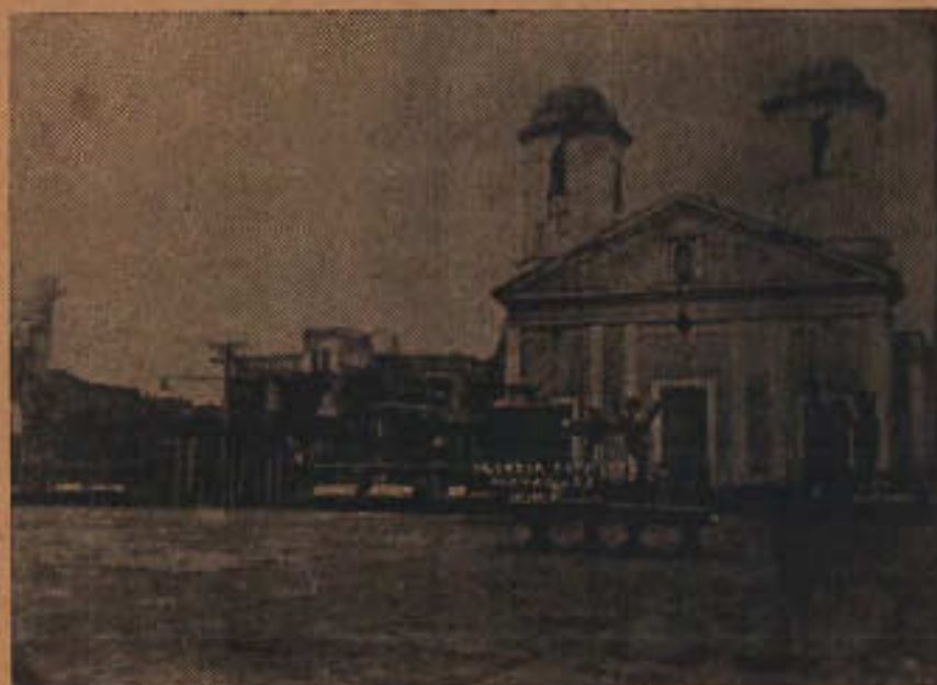
Iglesia de la Candelaria después del terremoto
