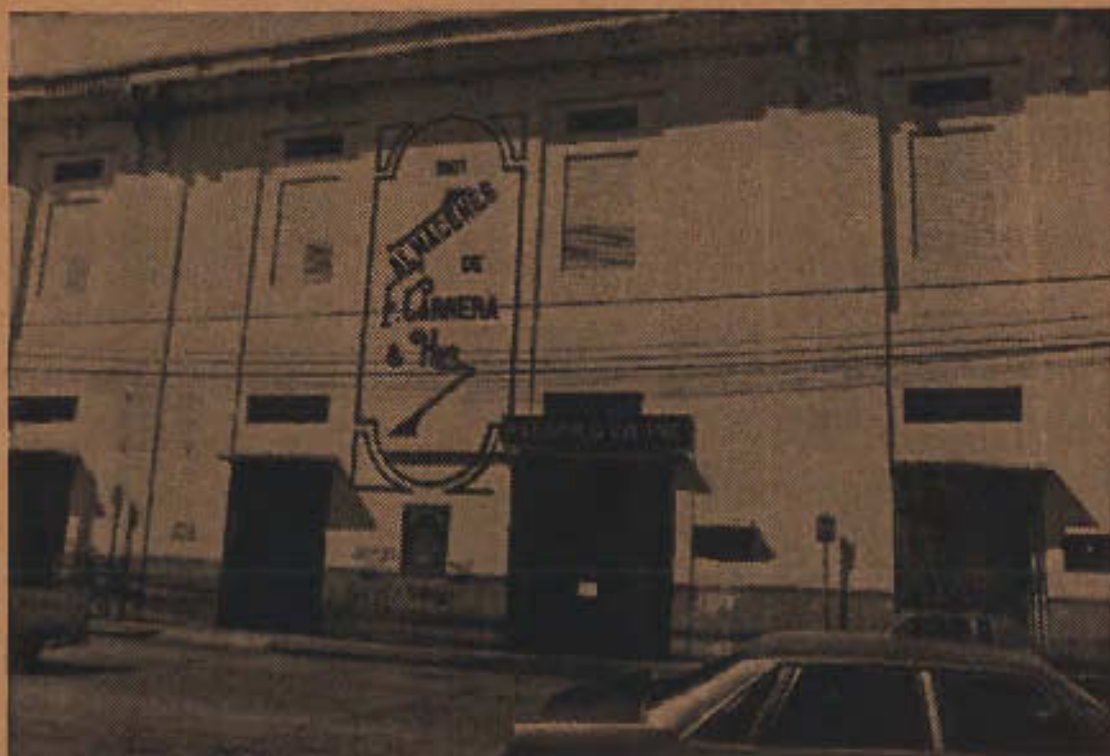
Almacén F. Carrera Hnos.
