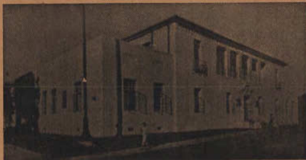
Correo federal recién construido en terrenos ocupados antes del terremoto por el cuartel militar
