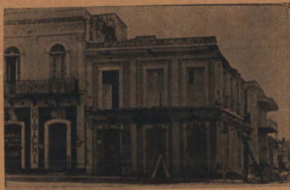
Edificio antes del terremoto
