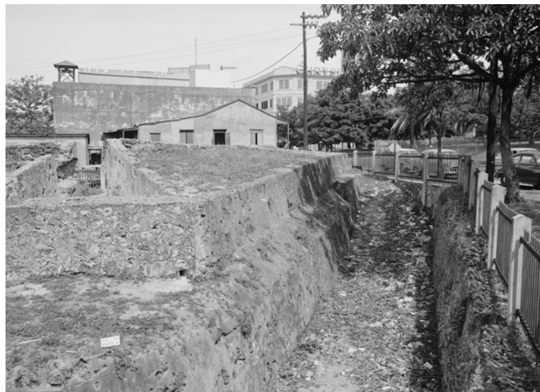
Figuras 41 y 42. Vistas de la batería de la Segunda línea avanzada. La primera a la elevación sureste tomada desde la calle San Agustín, mientras la segunda mira el lado norte mirando hacia el este. Se puede apreciar la profundidad de la escarpa y contraescarpa del foso seco. Castillo San Cristobal, Ravelin, Puerta de Tierra, San Juan. Biblioteca del Congreso. PR-51, HABS. 12 de abril de 1954, foto por Frederik C. Gjessing,
