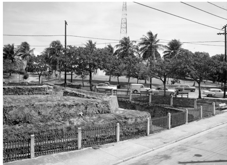
Figuras 41 y 42. Vistas de la batería de la Segunda línea avanzada. La primera a la elevación sureste tomada desde la calle San Agustín, mientras la segunda mira el lado norte mirando hacia el este. Se puede apreciar la profundidad de la escarpa y contraescarpa del foso seco. Castillo San Cristobal, Ravelin, Puerta de Tierra, San Juan. Biblioteca del Congreso. PR-51, HABS. 12 de abril de 1954, foto por Frederik C. Gjessing,
