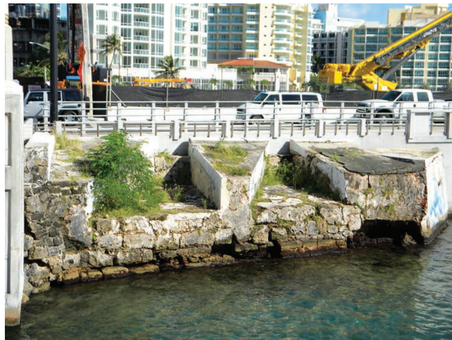
Figuras 57 y 58. Condición deteriorada de la batería baja del Fuerte de San Antonio en el 2005 (izquierda), colección San Juan en Blanco y Negro, y foto tomada luego de remoción de árbol, terreno y una garita como parte del proyecto de estabilización y restauración. OECH. Colección fotográfica, 19 de octubre de 2011.
