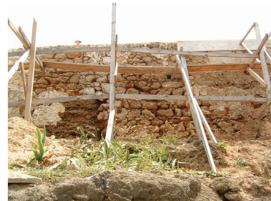
Figuras 55 y 56. Fachada este de la batería (derecha) y de pared apuntalada de la fachada sur. Restauración de la Batería del Escambrón. OECH. Colección fotográfica, 2003.
