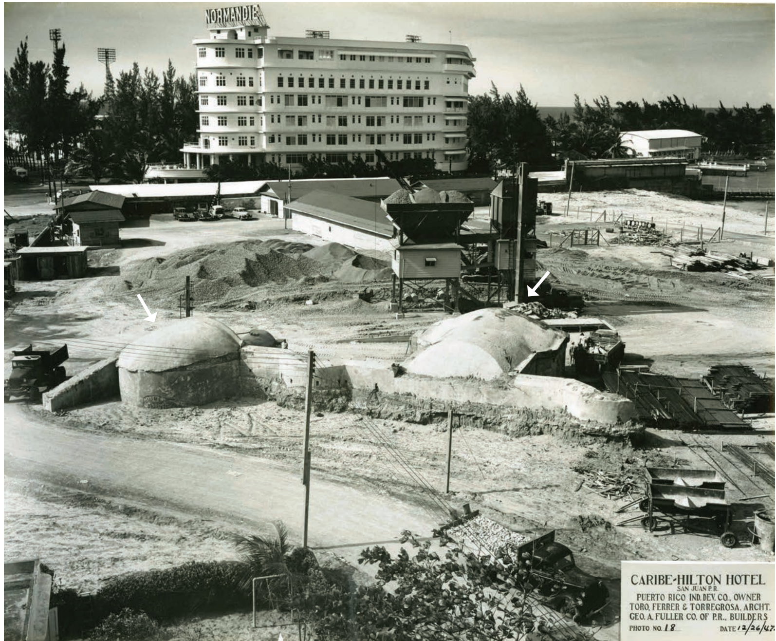
Figura 30. Fotos de la construcción del Hotel Caribe Hilton mirando hacia al noroeste, 26 de diciembre de 1947 donde se puede observar en primer plano la parte las bóvedas (identificadas con flechas) de las casamatas de la Batería de San Ramón y en el plano más lejano se puede ver el Hotel Normandie. AGPR. Compañía de Fomento Industrial de Puerto Rico, Caribe-Hilton Hotel, San Juan, Puerto Rico . Foto #018, 26 de diciembre de 1947.
