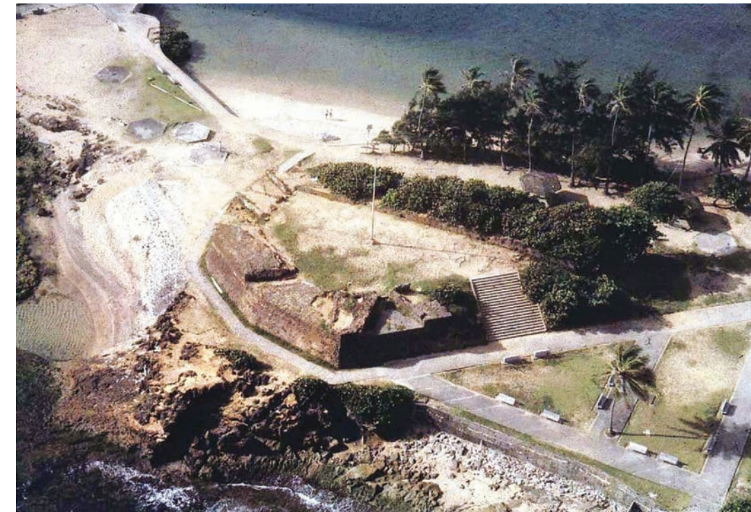
Ese mismo año, como parte del proyecto de Parque del Tercer Milenio; el Departamento de Transportación y Obras Públicas inició la remodelación del balneario del Escambrón. El nuevo proyecto incluyó la demolición de la escalera de concreto existente 96 en la Batería del Escambrón (ver figura 49); siendo reemplazada por un puente de acceso peatonal para llegar a su parte superior (ver figura 50). La piscina olímpica construida en la década del 1960 también fue eliminada.
