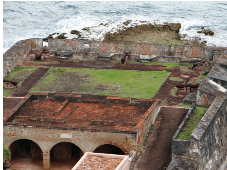
Figuras 63 y 64. Fotos del puente, portón y edificaciones del Fuerte de San Gerónimo (derecha) 2013, foto de la batería alta (izquierda), 2014. Puerto Rico Historic Building Drawing Society. Cortesía de Andy Rivera.
