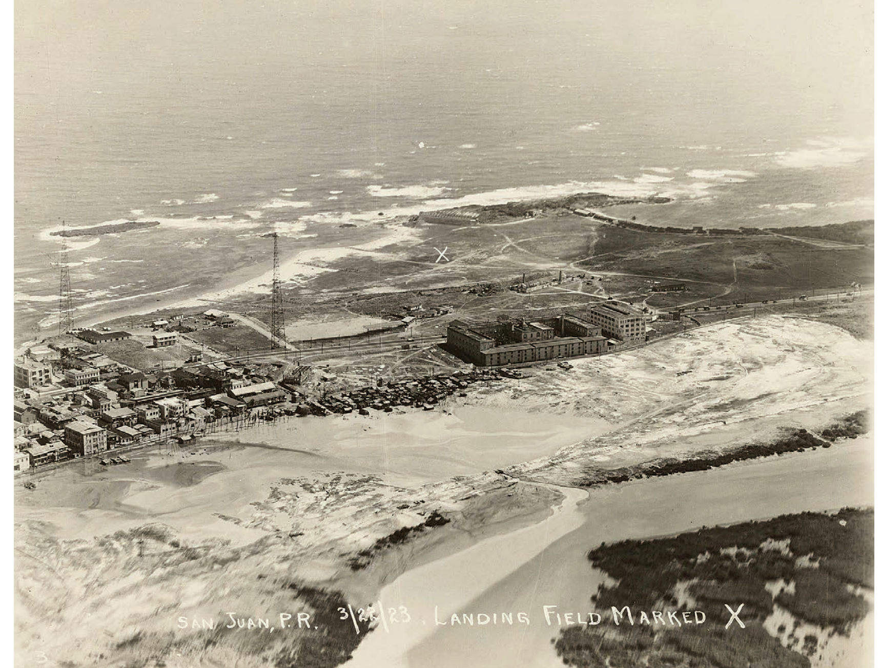
Figura 20. Foto área del 22 de marzo de 1923 donde se puede observar la estación inalámbrica (ver área entre las dos torres), un segmento sur de la Segunda línea (batería y su foso), los rellenos de los mangles (en progreso), el antiguo hospital municipal (hoy Archivo General de Puerto Rico) y la barriada Salsipuedes (a la derecha del antiguo hospital y aledaño al caño de San Antonio). En segundo plano se puede ver parte de la Primera línea (playa Zalemas) y el repuesto de la Batería del Escambrón RG-18-AA-228-31-ac . AGPR. Cortesía de Joseph Harrison, Archivo Digital Nacional de Puerto Rico.
