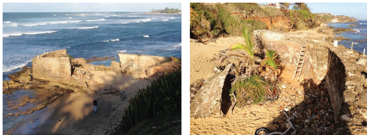
Figuras 76 y 77. Vista de Bajamar visto desde el paseo de Puerta de Tierra (derecha) y acercamiento a muro de la batería mirando al oeste, 2013. Puerto Rico Historic Building Drawing Society. Cortesía de Andy Rivera.
