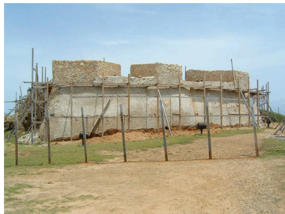
Figuras 55 y 56. Fachada este de la batería (derecha) y de pared apuntalada de la fachada sur. Restauración de la Batería del Escambrón. OECH. Colección fotográfica, 2003.
