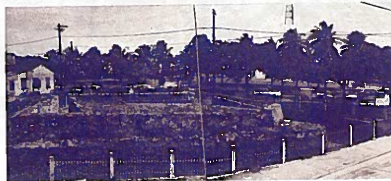
SEGUNDA LINEA DE DEFENSA, 1954 Con el paso del tiempo el sistema defensivo de la Isleta que funcionaba como una unidad se fue mutilando, considerándose sólo la conservación del perímetro inmediato a la ciudad. Nótese el foso rellenado en la actualidad. National Park Service, San Juan.
