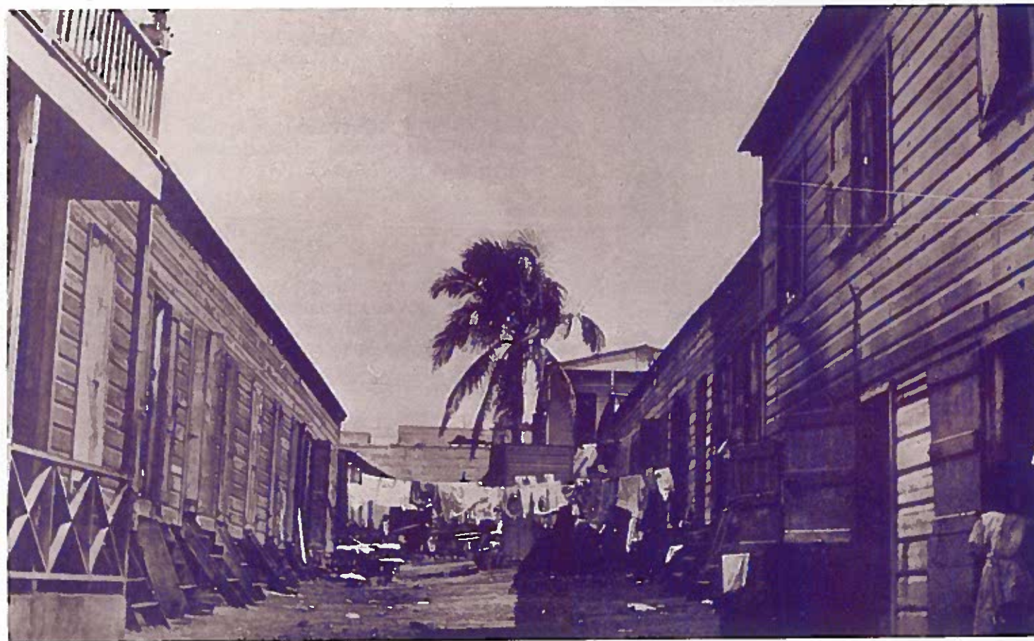
RANCHONES, 1914 Estos apartamentos generalmente tenían una puerta al frente y otra en la parte posterior, sin ventanas. J.C. Bills, Housing Conditions of Laborers in Puerto Rico, 1914 .
