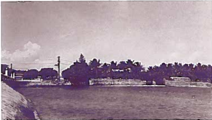
MURALLAS PRIMERA LINEA DE DEFENSA, 1953 Segmentos de las murallas de este sistema defensivo vistas desde el puente de Dos Hermanos. National Park Service, San Juan.
