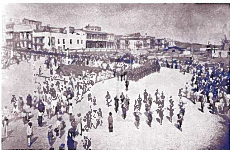
FRENTE PORTUARIO, C.1900 Demolida la muralla sur de la ciudad el espacio abierto de ésta se fue ocupando sin ningún plan de ordenación, negando así el frente marítimo de la ciudad. Al fondo la antigua estación del tranvía, donde hoy se localiza el estacionamiento municipal de "doña Fela". Feliciano Alonso, Archivo General de Puerto Rico, San Juan.
