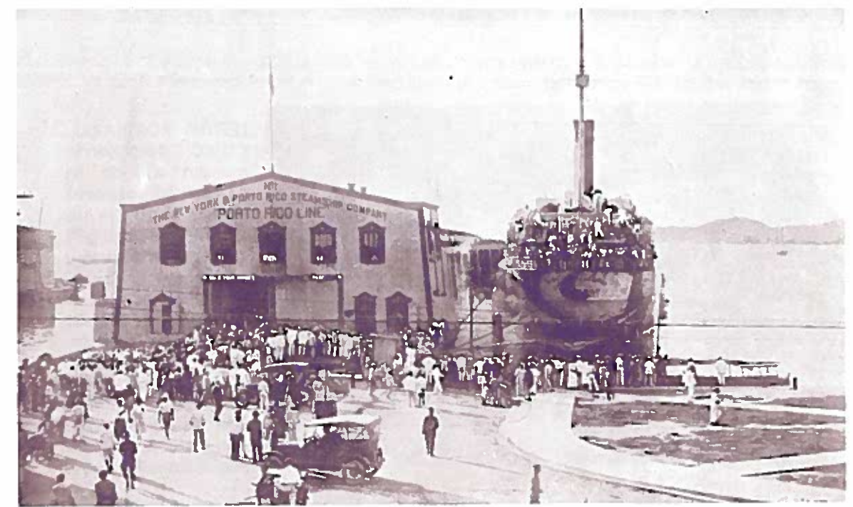
MUELLE 1, 1918 Este muelle sirvió de en- trada y salida a la mayoría del tráfico de pasajeros y de carga en las primeras décadas del siglo. Puerto Rico Ilustrado , 1918.
