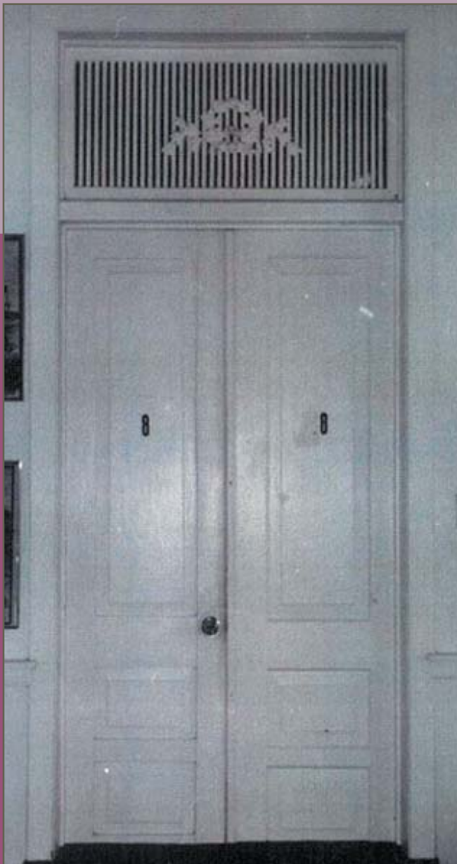
puerta con montante o travesaño
