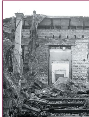
Detalles de la fachada de la Casa del Francés luego del fuego en agosto de 2005
