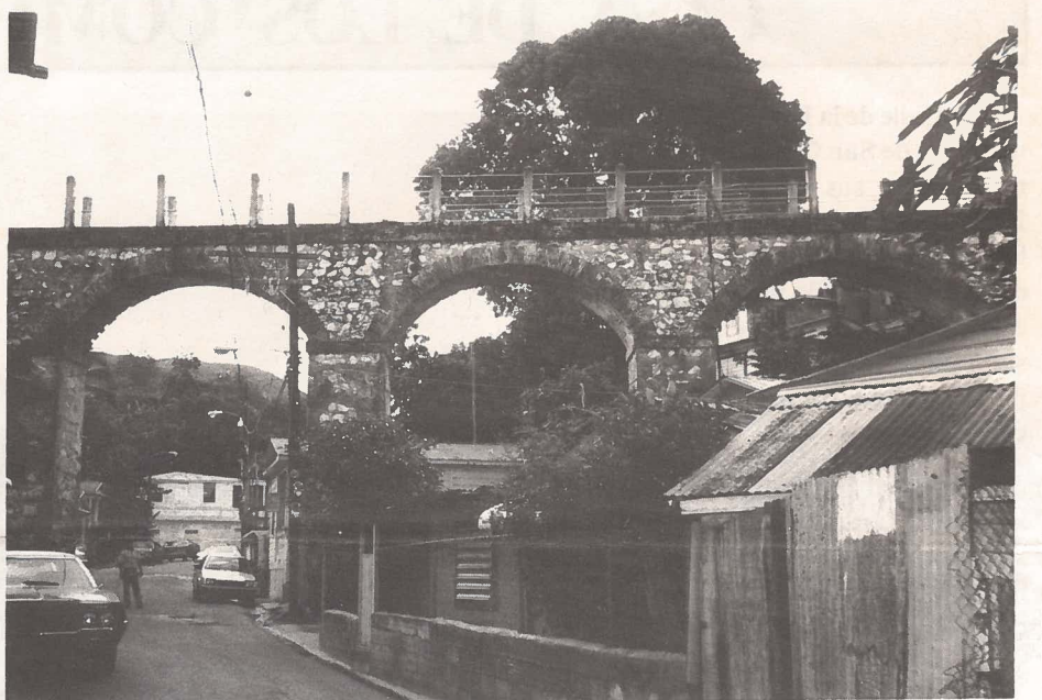
Arcada de ladrillos sobre la cual descansa el Canal principal.
