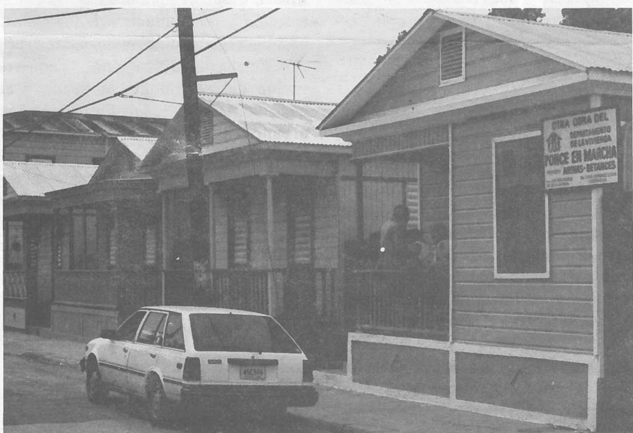
Callejón El Jobito, demolido para dar paso a un Centro Comunal. Cuartel de Policía y 16 estructuras nuevas.
