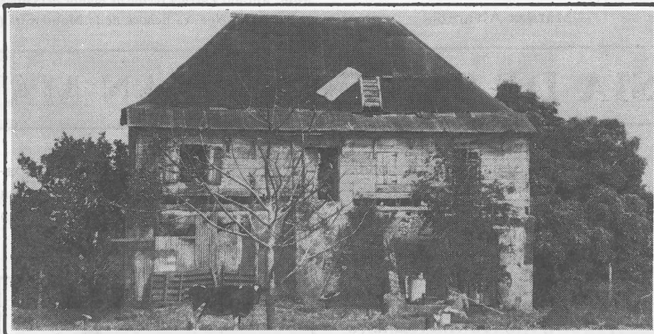
Hacienda La Sabana. Debido a la falta de mantenimiento no existe ya esta estructura bicentenaria de madera. (foto Víctor López, Camuy, 1983).
