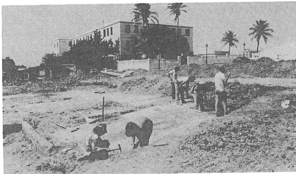
Tarea inicial de remover escombros, dejando al descubierto pisos, cimientos y otros elementos arquitectónicos del siglo 19 y 20, en el antiguo barrio.
