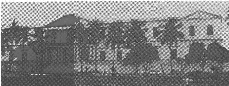
Fachada Principal, Casa de Beneficencia
