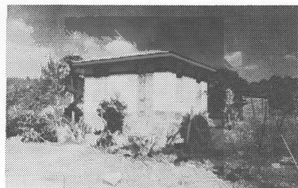
Ubicada en la carretera 149, km. 62.928, entre Villalba y Juana Díaz.
