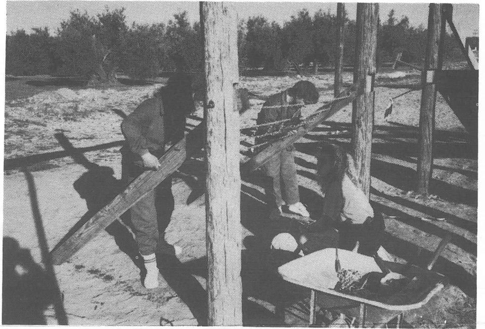
Varios jóvenes participantes de la Escuela-Taller de Ubeda, en la provincia de Jaén, España realizan labores de construcción de facilidades recreativas en un parque pasivo. Este proyecto fue planificado, diseñado y realizado en su totalidad por el personal profesional, técnico de esta Escuela-Taller.
