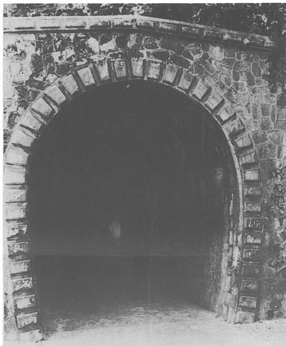
Entrada al túnel en el sector de la playa de Guajataca.
