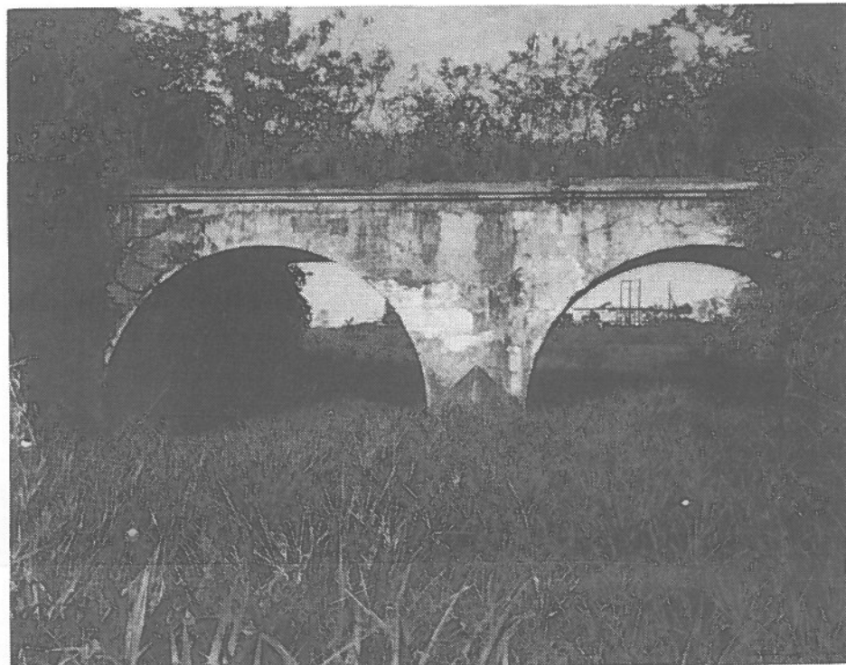
Puente de Añasco Arriba, construido a base de arcos en mampostería.
