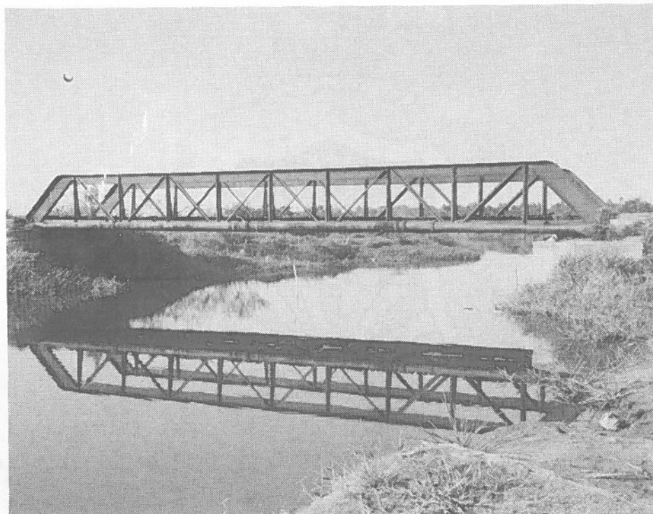
Puente ferroviario hecho en armazón de acero. Tramo transitable de Añasco.
