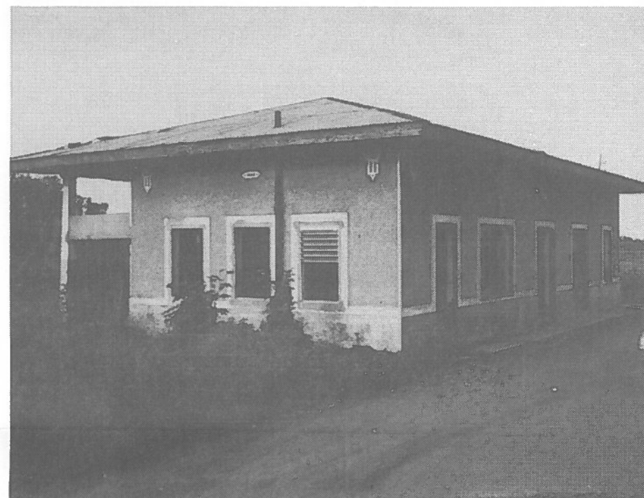
Estación de pasajeros de Añasco construida en concreto techado a cuatro aguas en zinc.
