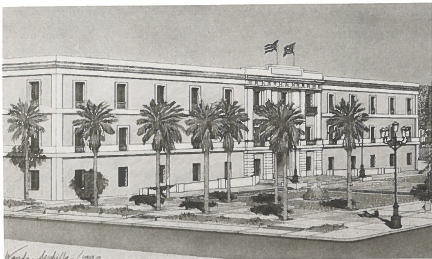
Fachada del Cuartel de Ballajá, sede del Centro Ballajá y ubicación del Museo de las Américas.
