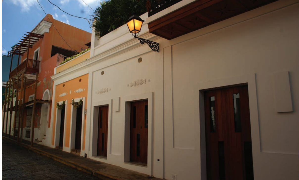
Vista de casas en la Caleta de las Monjas.
