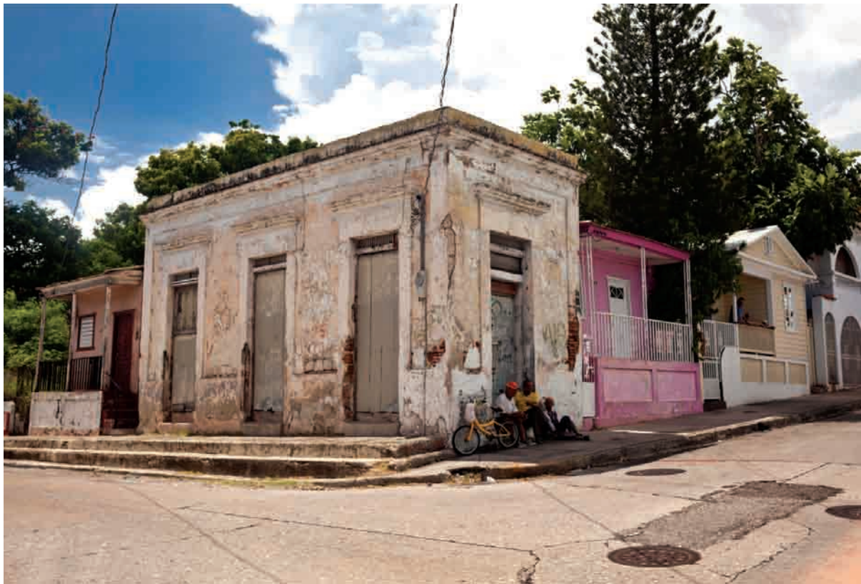
Estructura en la intersección de las calles Arenal y Bértoli. Fotografía por Alberto Rigau, 2010.
