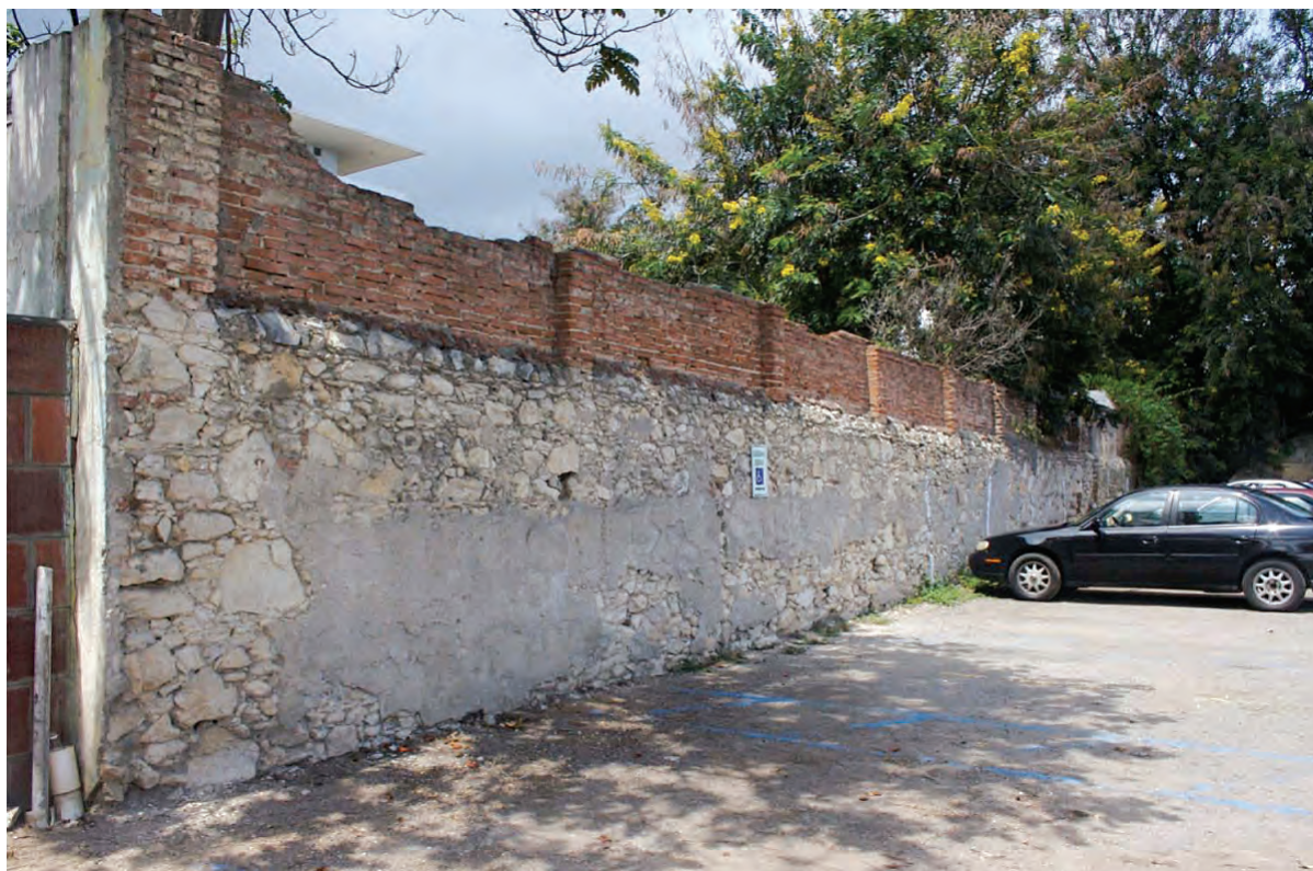
Arriba: Muro divisorio en pie en la calle Isabel de Ponce.
