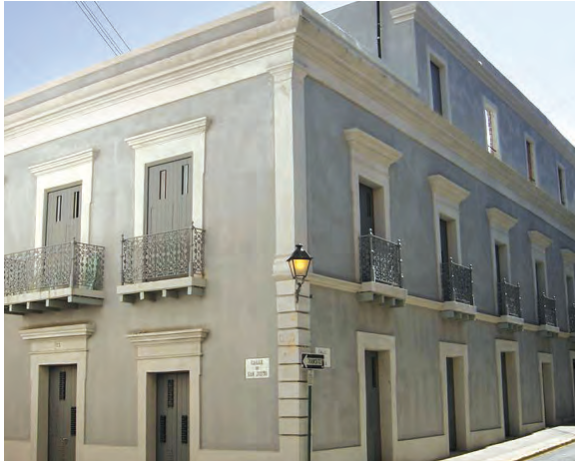
Luna 208 esq. San Justo. Edificio luego de concluidos los trabajos de rehabilitación. Fotografía del autor con el consentimiento de los dueños de la propiedad, Familia Lloveras-Marxuach.
