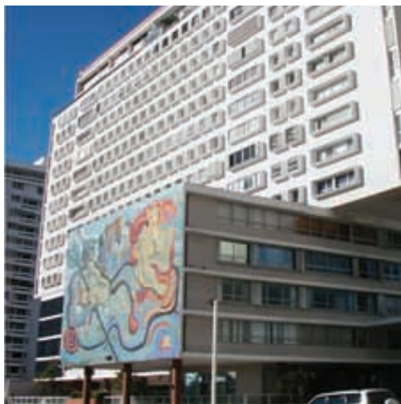
Edificio Surfside , Isla Verde, Puerto Rico. Fotografía por Arq. Benjamín Vargas.
