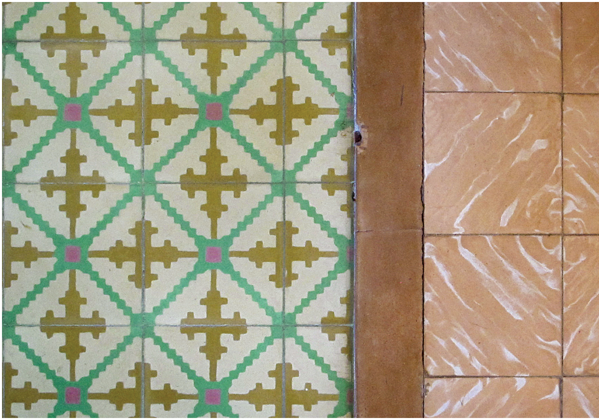
Detalle de losa del balcón y sala, residencia en la urbanización Baldrich, calle Pintor Campeche, San Juan. Fotografía por Manuel Olmo Rodríguez.
