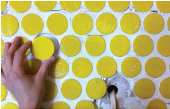
Secuencia fotográfica que ilustra el proceso de restauración de unidades amarillas en la cartería del vestíbulo 180. A la izquierda, el retoque de la lechada original e instalación de réplicas. Fotografías por el autor. A la derecha una perspectiva de las paredes de azulejo ya terminada la obra. Fotografía por Marisol Gómez Mouakad.
