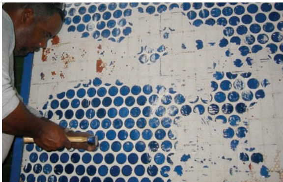
Secuencia fotográfica que ilustra el proceso de restauración de unidades azules en la Cartería del vestíbulo 190. Arriba el progreso de la obra desde julio hasta diciembre de 2011. Abajo, los pasos a seguir: demolición de losetas posteriores, remoción cuidadosa de la pega y limpieza química de las superficies. Fotografías por el autor.
