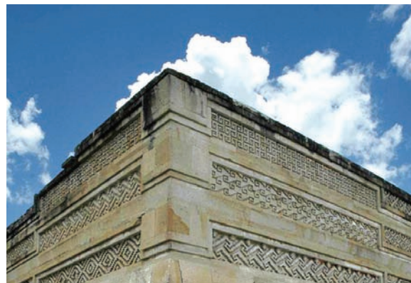
Detalle en estructura precolombina en la Zona Arqueológica de Mitla, Oaxaca, México.
