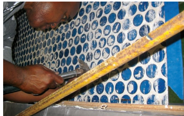
Secuencia fotográfica que ilustra el proceso de restauración de unidades azules en la Cartería del vestíbulo 190. Arriba el progreso de la obra desde julio hasta diciembre de 2011. Abajo, los pasos a seguir: demolición de losetas posteriores, remoción cuidadosa de la pega y limpieza química de las superficies. Fotografías por el autor.
