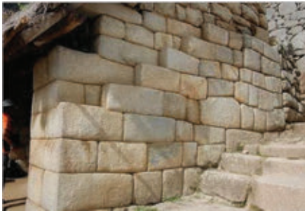
Véase los tipos de muro de la Llaqta Inka de Machupicchu, desde el más fino hasta el más rústico.
