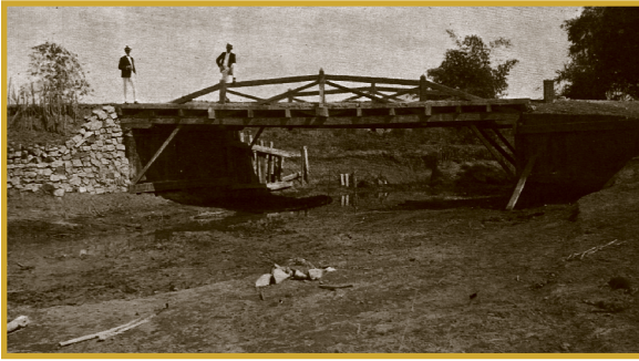
Arriba: Puente provisional de madera de 11 metros de luz, carretera de Mayagüez a San Germán. Informe del Comisionado del Interior, 1918.
