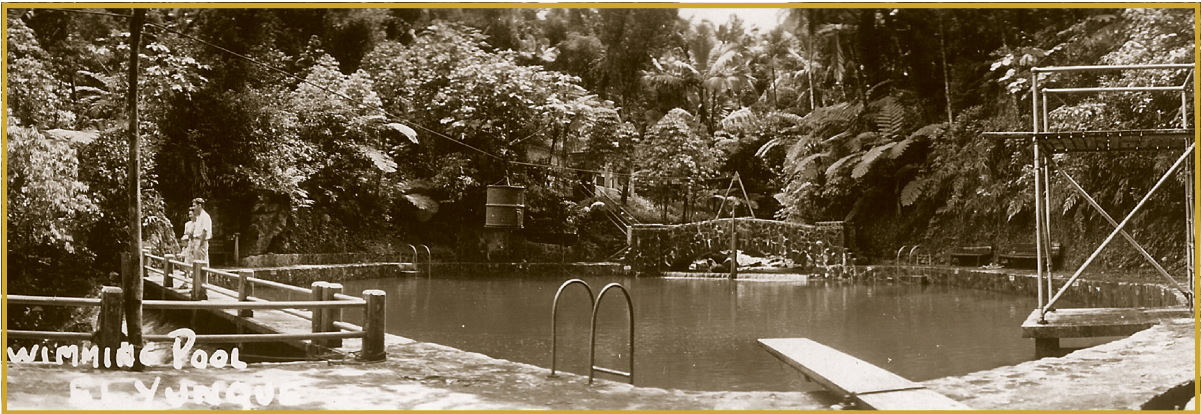
Piscina Baño de Oro, construida en 1936 por los CCC en El Yunque.
