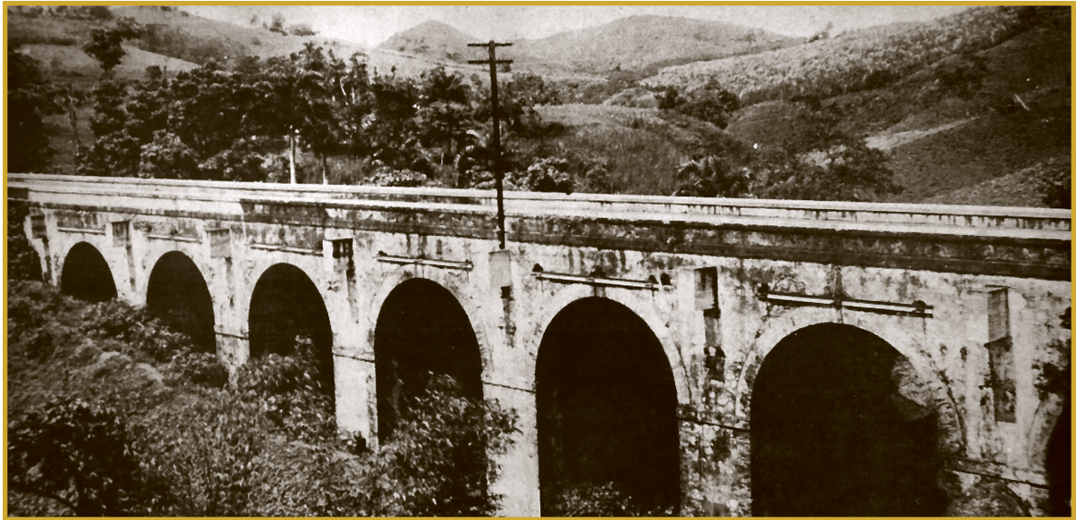
Puente de arcos en ladrillo sobre Quebrada Los Frailes en San Juan, c. 1928, Informe del Comisionado del Interior, Año Fiscal 1928-1929.
