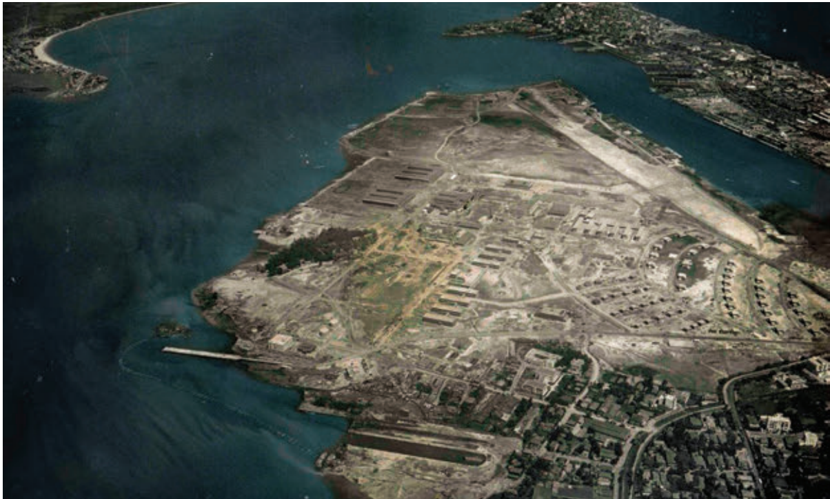
Vista aérea de la construcción de la Base Naval en Isla Grande, San Juan, P.R., 1940 (Archivo General de Puerto Rico).
