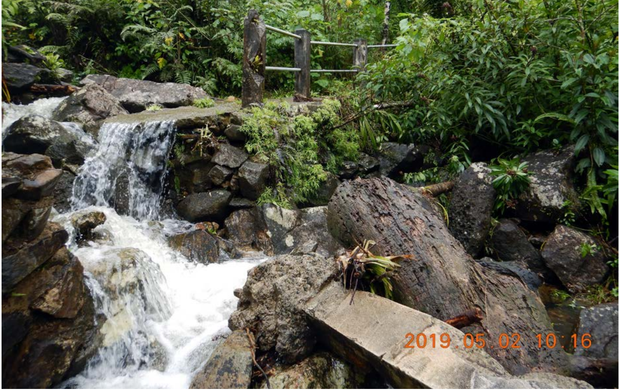
Daños al cruce de aguas bajas de la vereda de Baño de Oro. (Fuente: Raymond Feliciano, Servicio Forestal)
