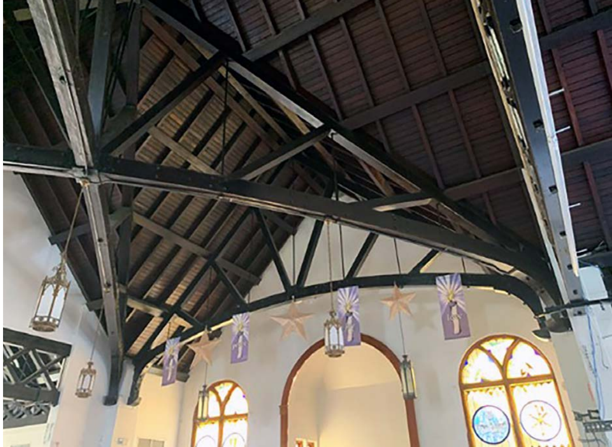
Vista interior de la armadura en madera del techo de la iglesia. (Foto: José R. Gayá Gil)
