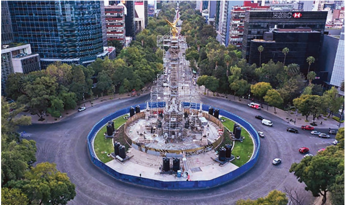
Reforzamiento de la Columna de Independencia. (Fuente: SOBSE 18 )
