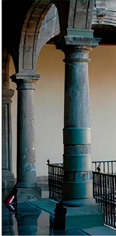
Refuerzo de columnas y recimentación de columnas en la antigua Escuela de Medicina. 17 (Imagen: Roberto Sánchez y Roberto Meli)
