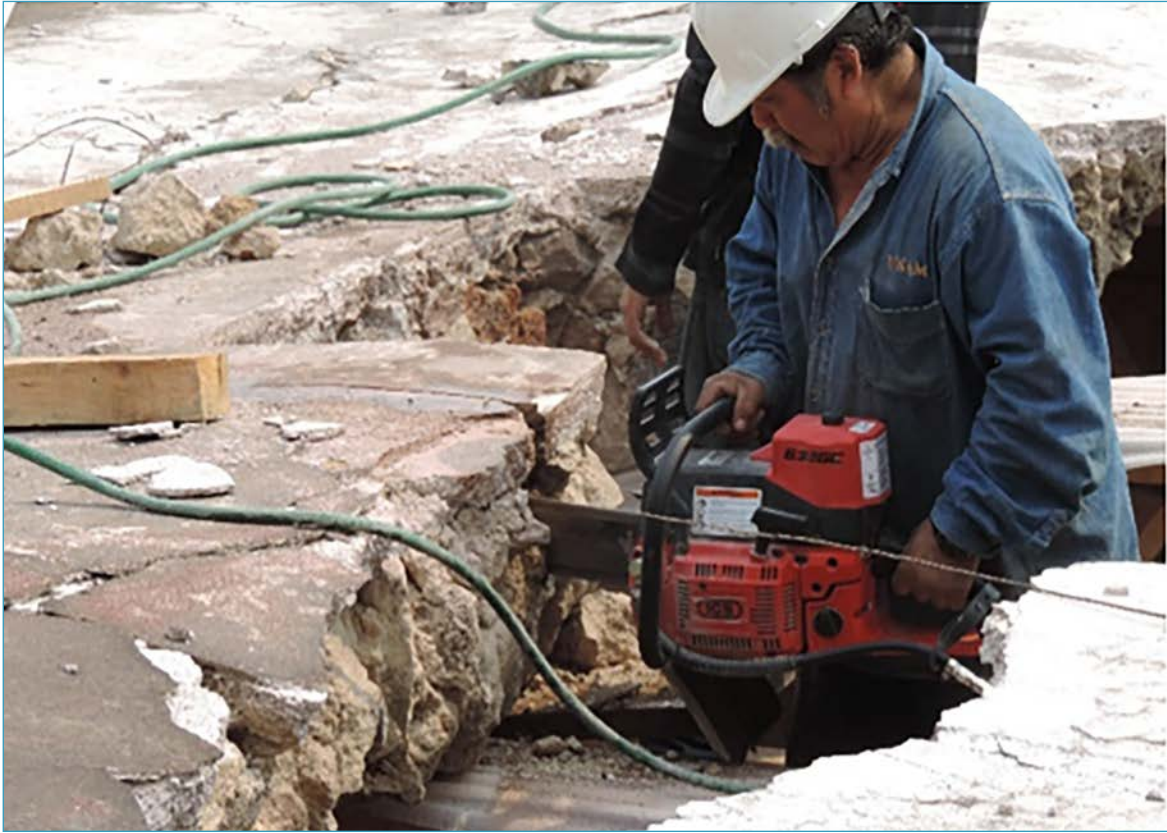
Extracción y ensayo de muestras de mampostería. (Fotos: Marcos M. Chávez Cano)
