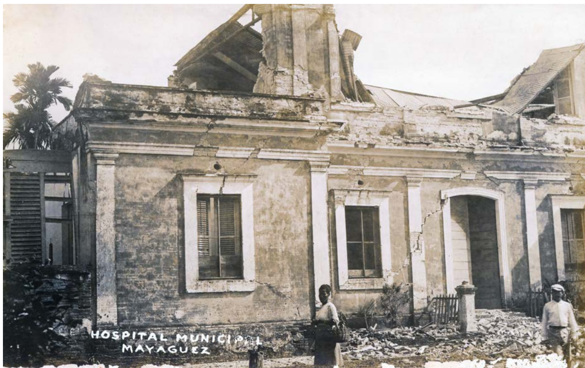
El Hospital Municipal de Mayagüez en ruinas. (Fuente: Archivo General de Puerto Rico, Archivo Fotográfico, Colección Belén Bosch de Díaz, núm. 51)
