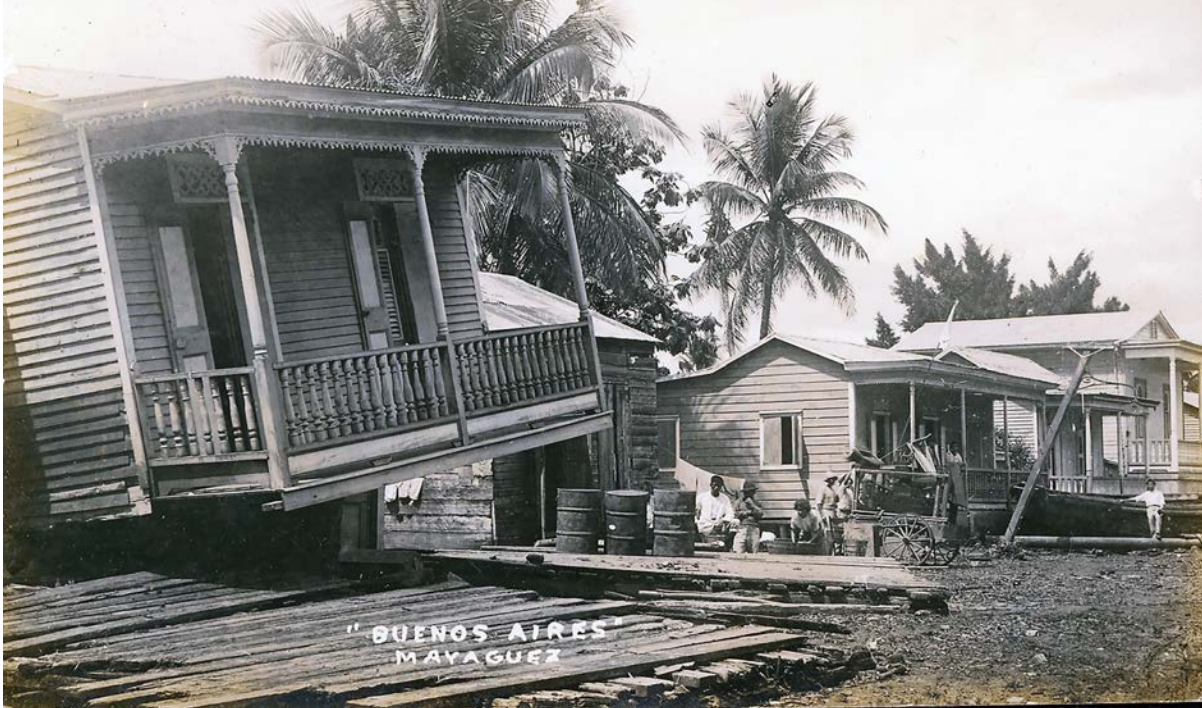
Destrucción causada por el sismo en el área residencial con viviendas en madera, en Mayagüez. (Fuente: Archivo General de Puerto Rico, Archivo Fotográfico, Colección Belén Bosch de Díaz, núm. 36)
