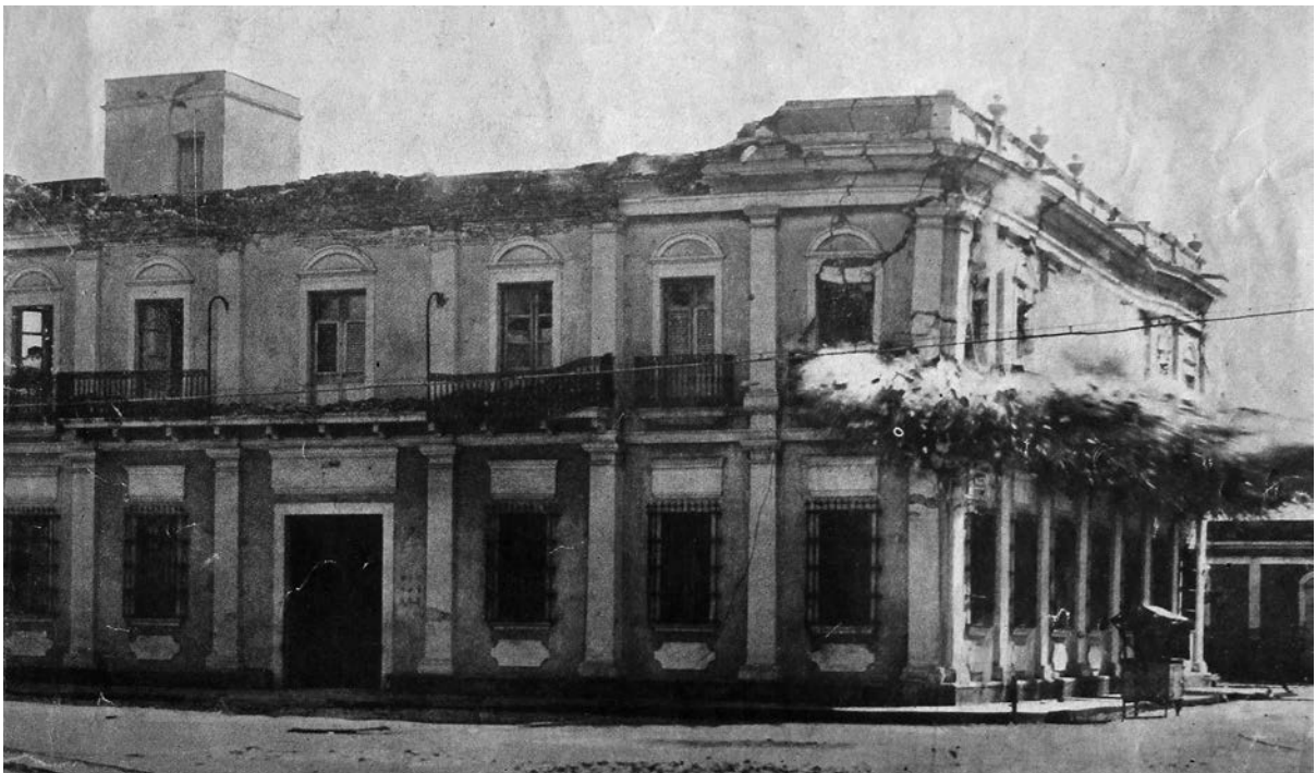
Demolición de una parte de la aduana de Mayagüez luego de resultar gravemente agrietada por el sismo. (Foto: Puerto Rico Ilustrado , 26 de octubre de 1918)
