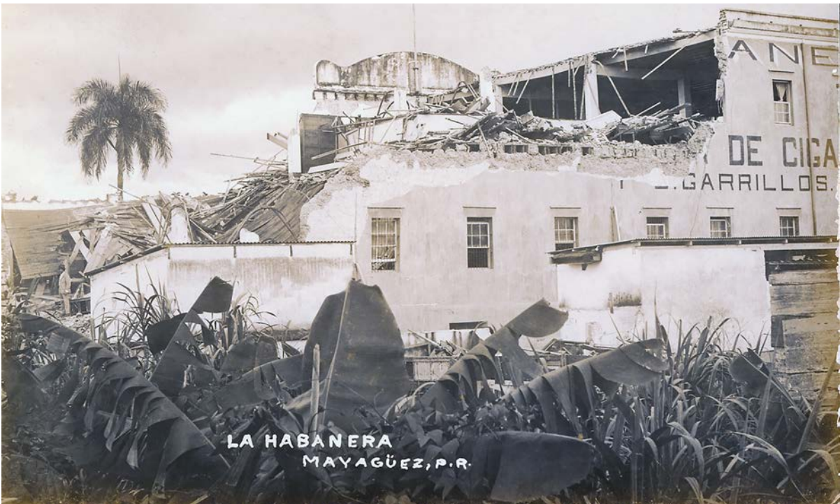
El edificio industrial La Habanera (en Mayagüez), hecho en hormigón, colapsó provocando la muerte de varios trabajadores. (Fuente: Archivo General de Puerto Rico, Archivo Fotográfico, Colección Belén Bosch de Díaz, núm. 27)
