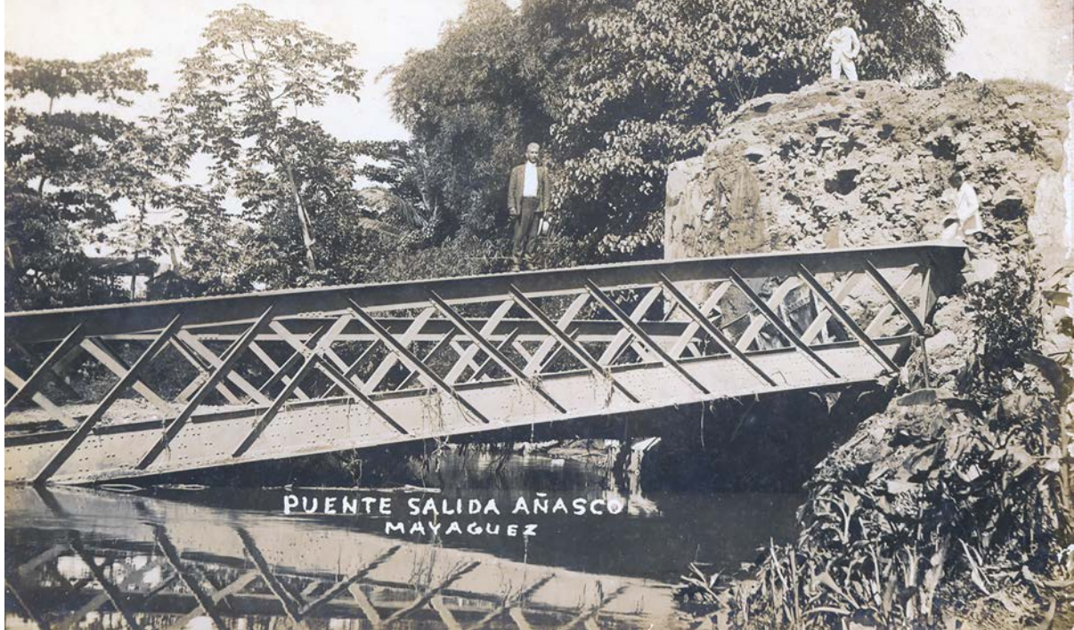
Puente colapsado en la carretera entre Añasco y Mayagüez. (Fuente: Archivo General de Puerto Rico, Archivo Fotográfico, Colección Belén Bosch de Díaz, núm. 22)
