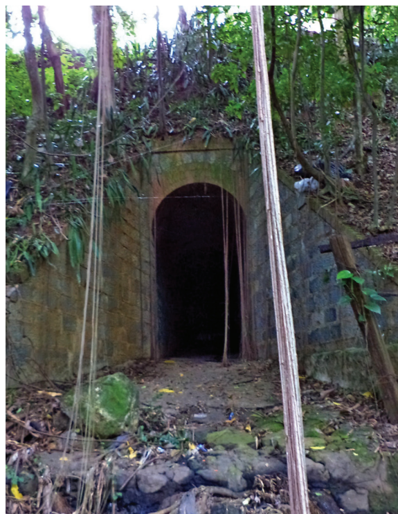
Alcantarilla ferroviaria en la salida de San Germán hacia Lajas. Esta estructura de 1893 permite que el agua de lluvia que baja de la gran montaña contigua atraviese por debajo del terraplén que sostenía las vías férreas. Mide casi tres metros de altura y uno y medio de ancho. Hoy le sirve a la avenida construida sobre el paso de la vía.
