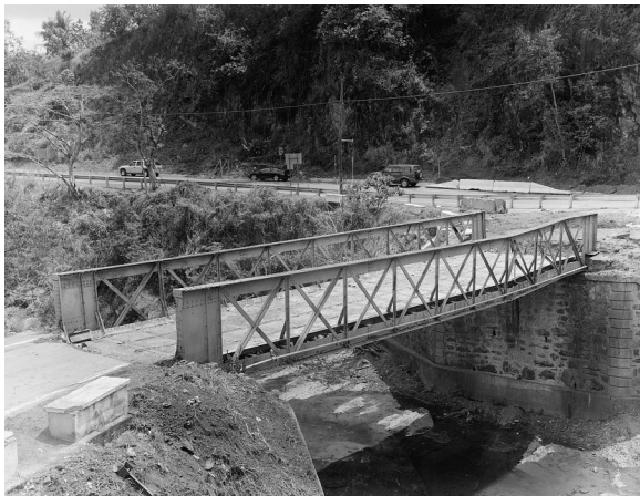
Puente Río Hondo, incluido en el National Register. El puente, listo para ser trasladado, aparece sin pavimento sobre su tablero metálico. Fotografiado para el National Register por Héctor Méndez Caratini en una acción de mitigación.
