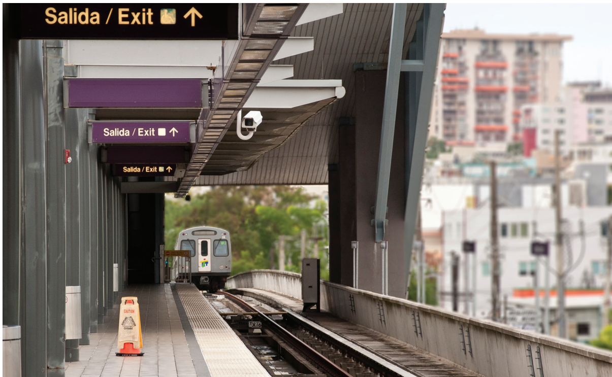
Tren Urbano. Foto suministrada por la autora.
