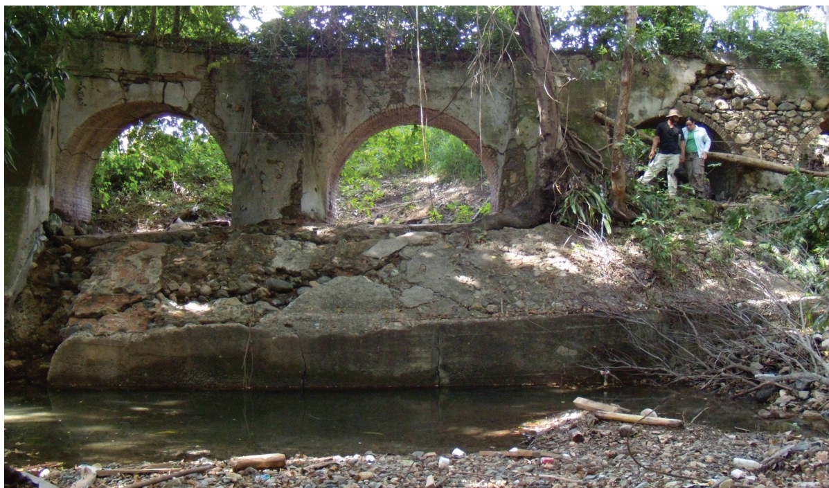
Canal Barrancas. Tramo elevado sobre cruce de la quebrada Ausubo. Foto por Marisol J. Meléndez Maíz.
