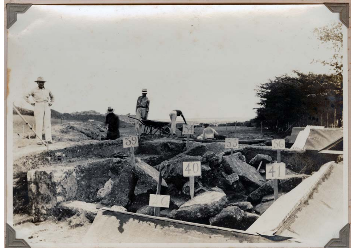
Remanentes estructurales correspondientes a la Cámara B de la "Casa de Tapias" (Imagen del Archivo General de Puerto Rico, Fondo Fortaleza, Tarea 96-20, Expediente Excavación en Caparra 1937, Caja 265).
