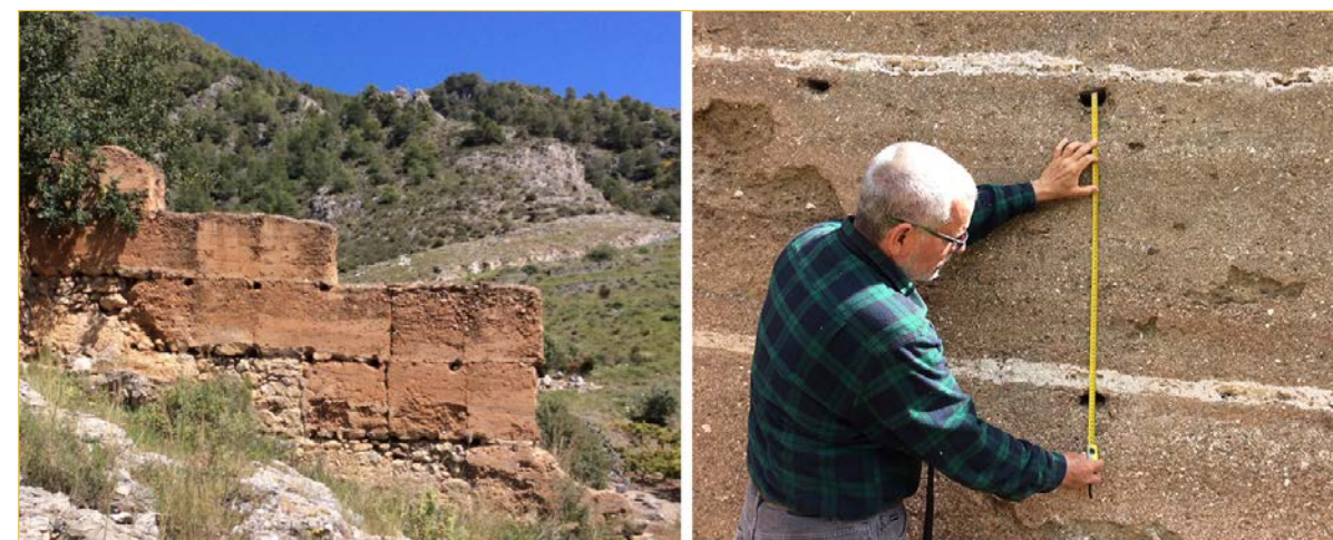
Tapias en Andalucía: Antiguo tapial para una cuadra de cabras. Tapias musulmanas del castillo de Bentomiz en la provincia de Málaga, siglo 11. En el empalme entre tapias se colocaba una capa de cal para endurecer al unión y a la vez impermeabilizarlas. En ambos casos, con muchos siglos de diferencia, la altura es de aproximadamente 80 cm.
