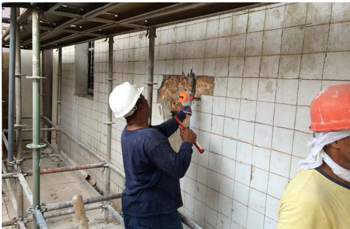
Removiendo el empañetado de cemento con formón y a mano. (Foto: Jorge Rigau)
