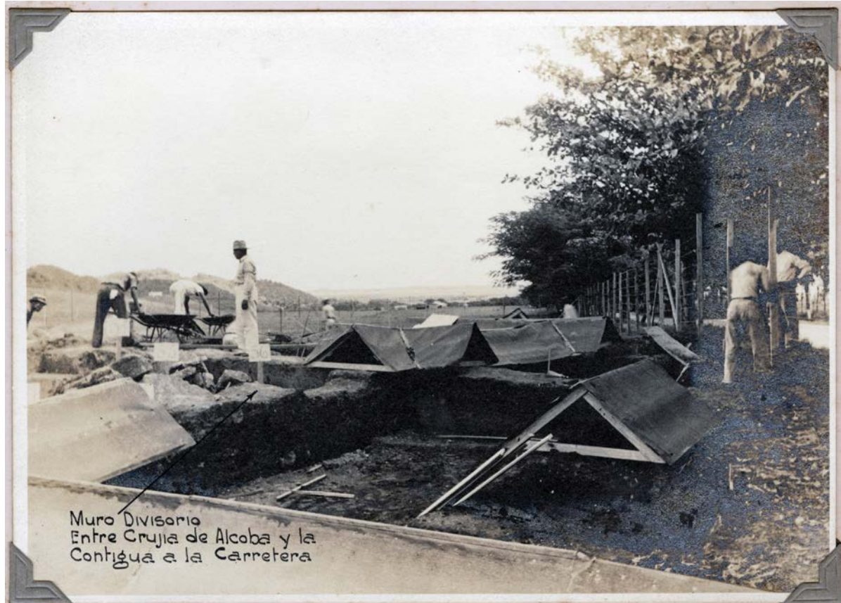
Trabajo de campo en el área donde se expuso la Cámara C de la "Casa de Tapias" (Imagen del Archivo General de Puerto Rico, Fondo Fortaleza, Tarea 96-20, Expediente Excavación en Caparra 1937, Caja 265).
