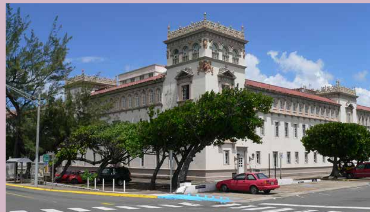
Vista de la Escuela de Medicina Tropical. Fuente: Archivo fotográfico de la OECH. Foto reciente de la Escuela de Medicina Tropical, tomada por Antonio Vallés Haddock del proyecto de "Actualización de documentación fotográfica del Registro Nacional de Lugares Históricos" (2008).
