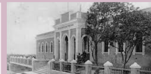
Asilo de ciegos, Ponce, antiguo Hospital Militar de Ponce. Fuente: https://www.facebook.com/photo/?fbid=271096354722649&set=a.108239031008383&locale=es_LA .
