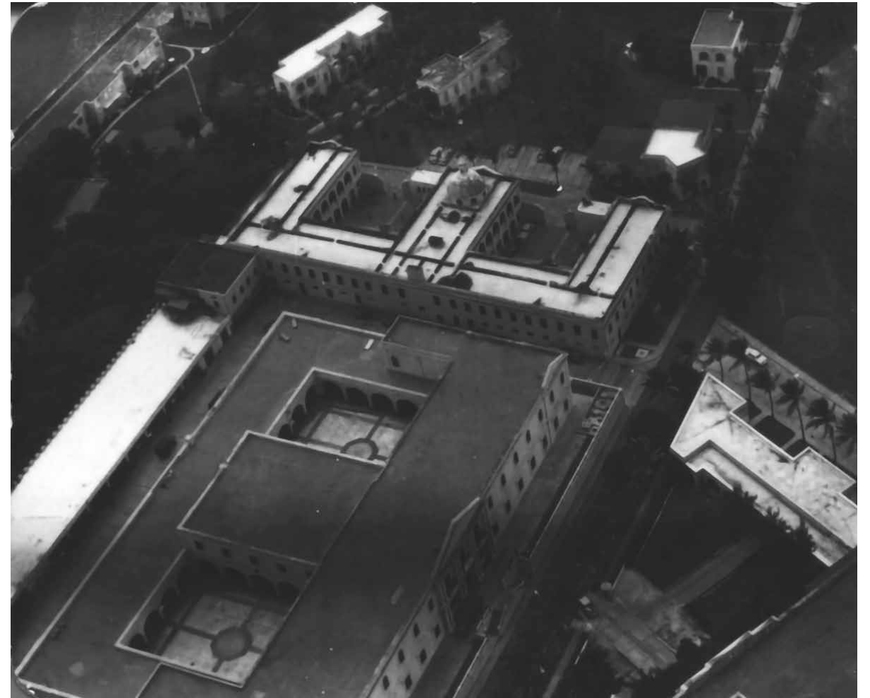
Fotografía de la vista área del Asilo de Beneficencia y Manicomio de Puerto Rico. “Fort Brooke aerial view” 1952. Fuente: Servicio Nacional de Parques Nacionales. Sitio Histórico Nacional de San Juan, División de Recursos Culturales, NPS 425.
