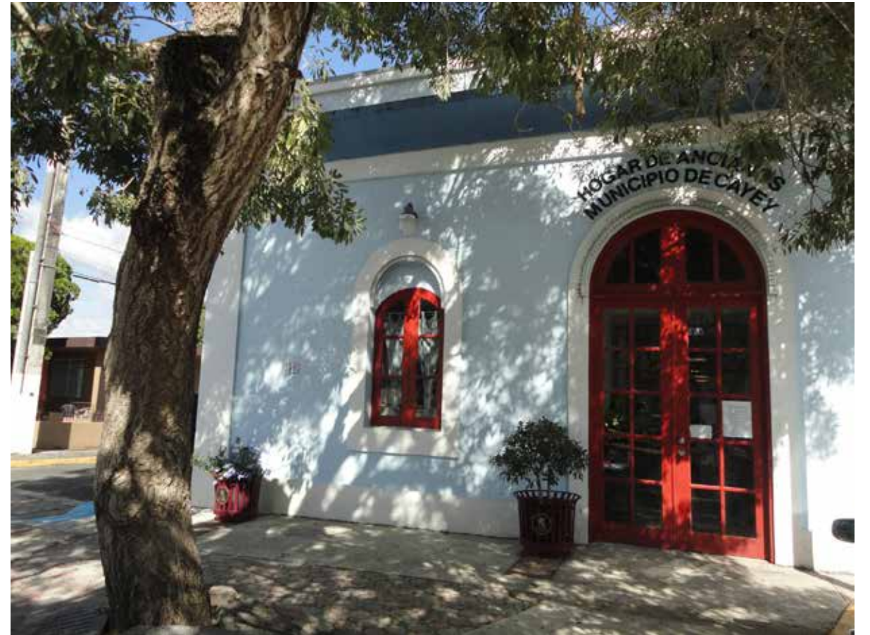
Hogar de Ancianos, Municipio de Cayey, Antiguo Asilo Santa Lucía. Fuente: Fotografía por el autor.
