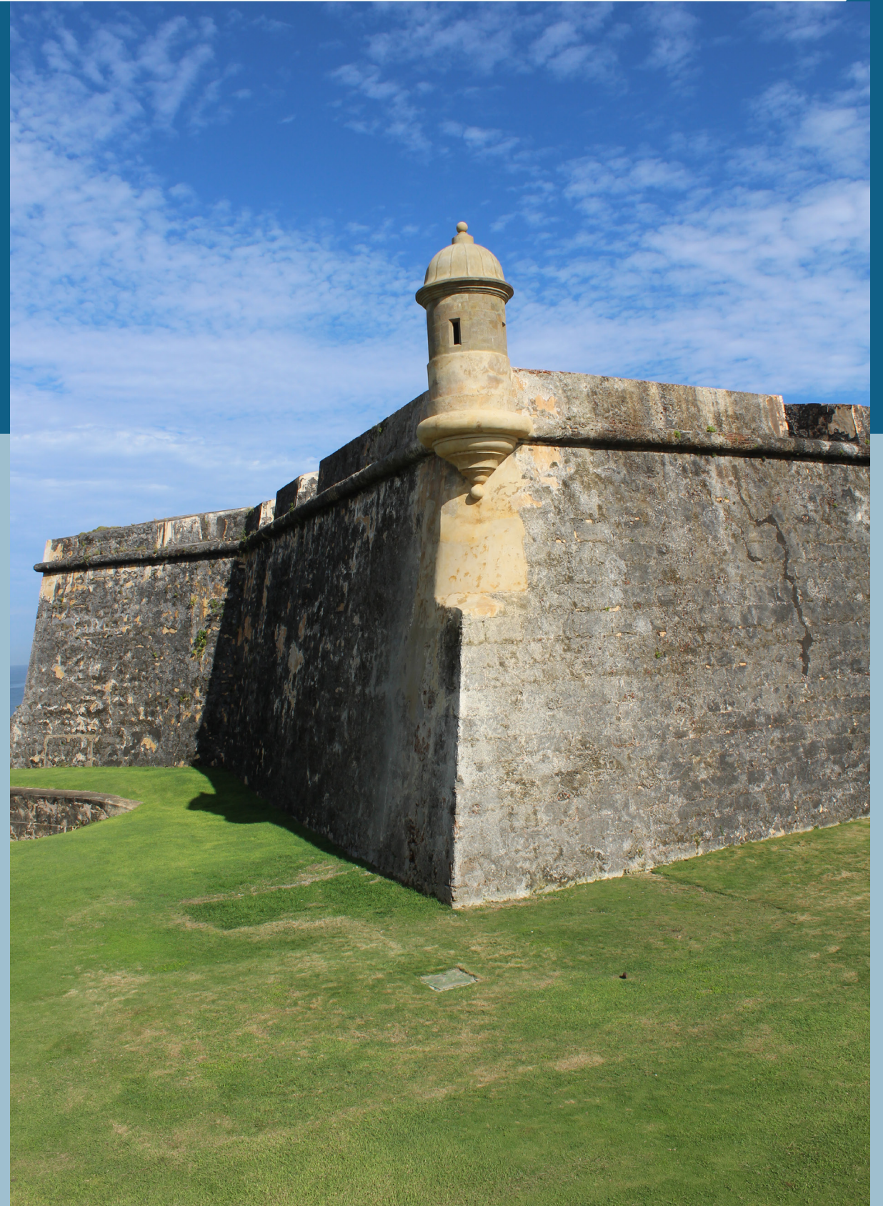
Garita del Bastión de Austria en el Castillo San Felipe del Morro luego de su restauración, 2025. Fuente: NPS.
