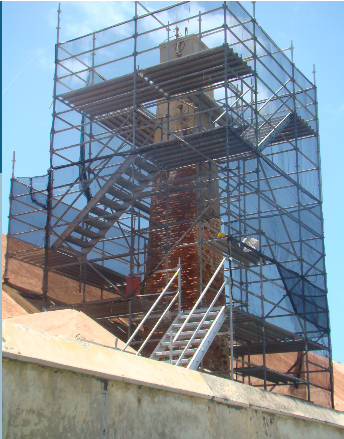
Andamio utilizado en el proyecto de restauración de la torre de ventilación y pararrayos del Polvorín de Santa Elena, 2018. Fuente: NPS.
