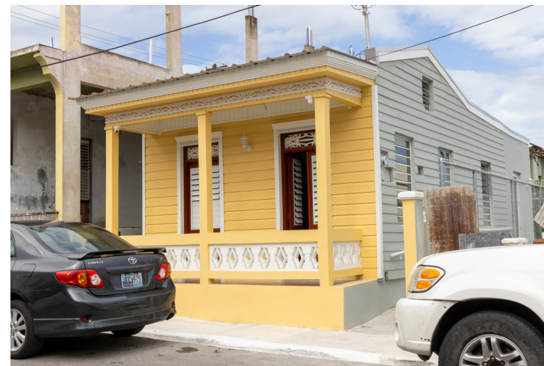
Elementos que definen el carácter arquitectónico de la estructura en su estado previo a la reconstrucción y luego de ser completados los trabajos. Fuente: Jesús E. Vega, "Section 106 NHPA Effect Determination".
