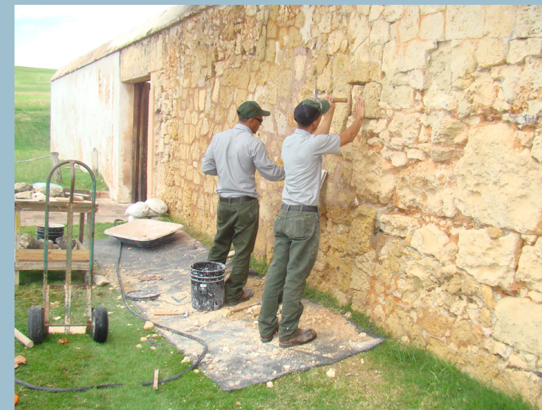
Personal del Servicio de Parques Nacionales aplicando mortero y removiendo cemento como parte del proyecto de restauración de la fachada del Polvorín de Santa Elena, 2018. Fuente: NPS.
