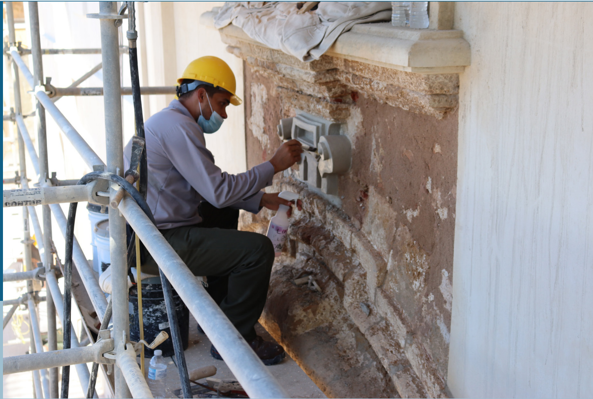
Albañil tradicional del Servicio de Parques Nacionales trabajando en los ornamentos de la fachada como parte del proyecto de restauración de los cuarteles de tropa del Castillo San Cristóbal, 2021. Fuente: NPS.
