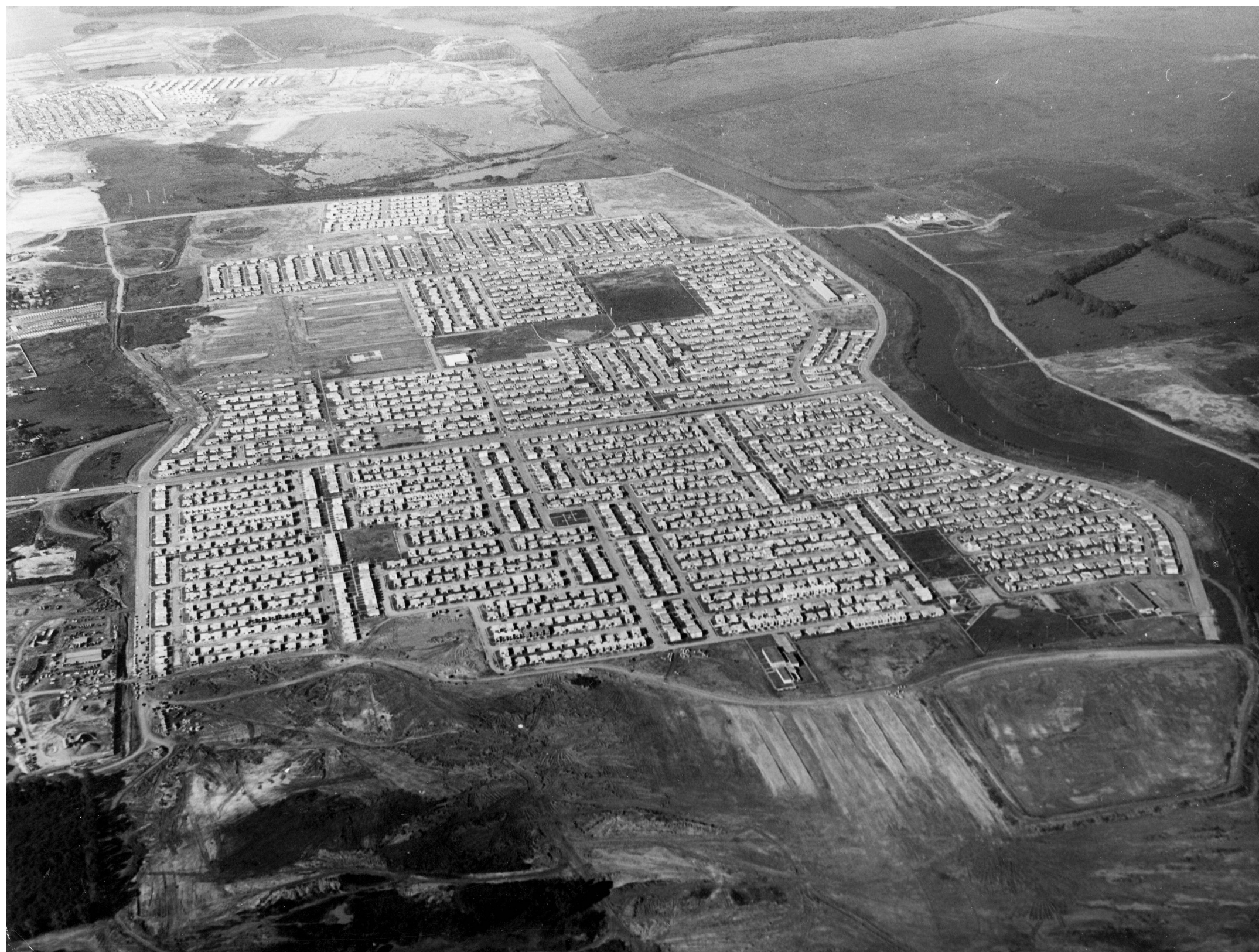
"Vista aérea de la urbanización Villa Fontana en Carolina", 1967. Fuente: Colección de Fotos del Periódico El Mundo , Biblioteca Digital Puertorriqueña.
