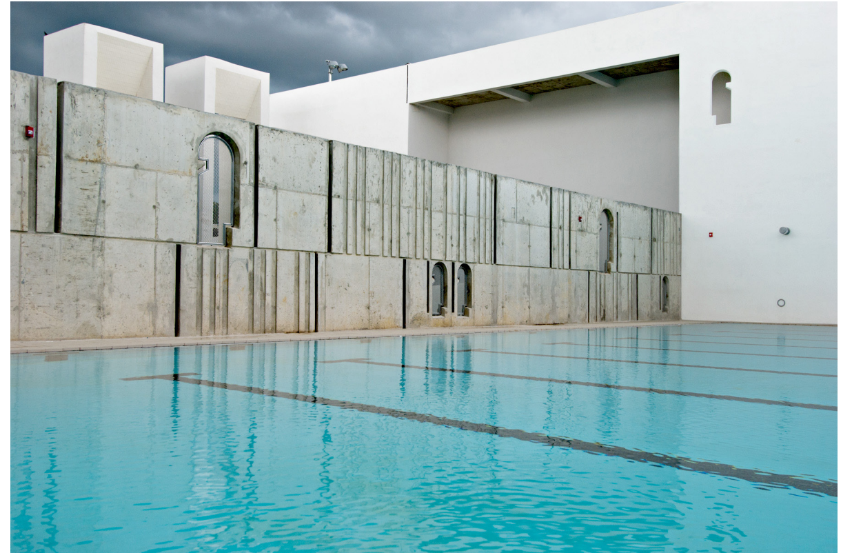
Vista interior del Natatorio de Mayagüez, diseñado por Fúster + Architects. Fuente: IMMV.
