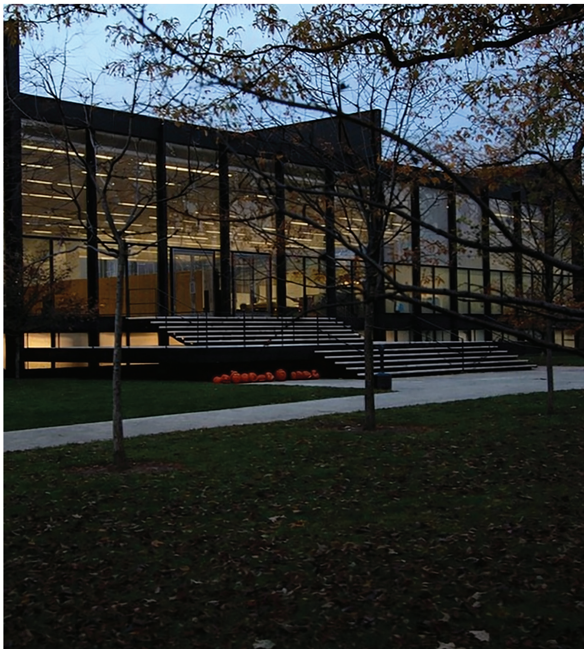
Edificio del S. R. Crown Hall en el campus del Illinois Institute of Technology (IIT), en Chicago, Illinois, completado en 1956 por Ludwig Mies van der Rohe. Fuente: IMMV.
