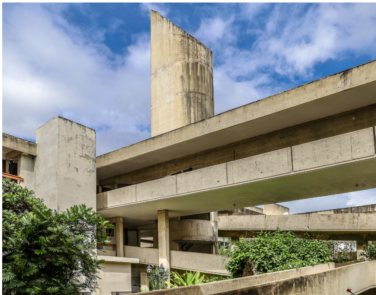
Fotografía del patio interior del claustro, tomada en 2019, donde se destaca el pasillo superior que separa el claustro de las habitaciones de las novicias y de las monjas, así como una de las rampas de hormigón armado que conectan los distintos niveles del monasterio. Fuente: Diana G. Serrano/MARVEL.
