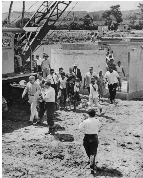
"Muñoz Marín (izquierda) coincidió ayer en Humacao con la construcción relámpago de una de las casas de la IBEC (derecha)", 1960. Fuente: Colección de Fotos del Periódico El Mundo , Biblioteca Digital Puertorriqueña.
