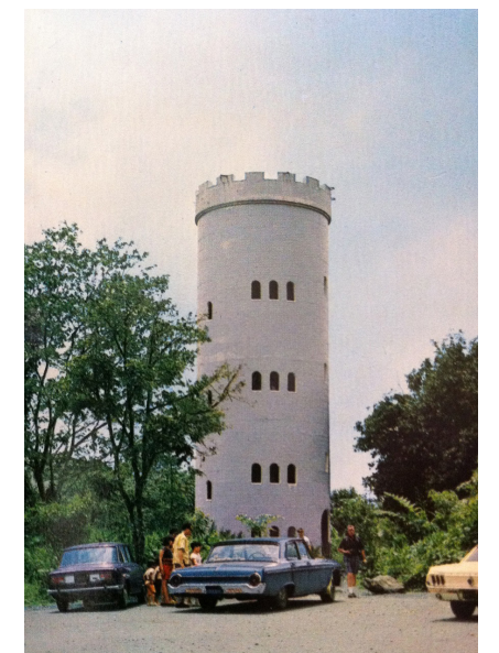
Vista de la Torre Yokahú, ca. 1965. Fuente: Servicio Forestal.
