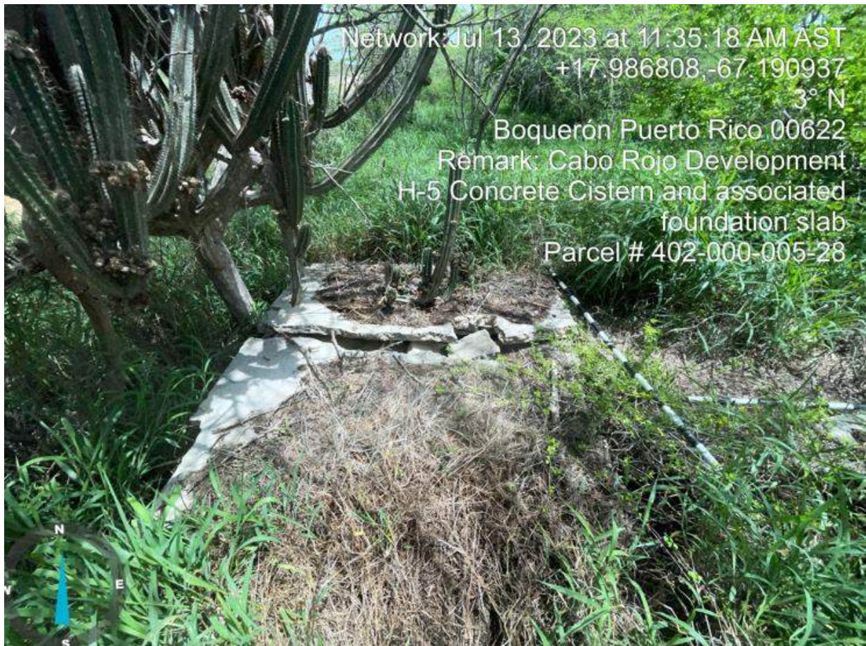
Foto 13. Base o zapata de concreto a nivel de la superficie
