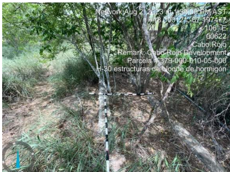
Foto 80. Elemento H-30, estructuras de hormigón.
