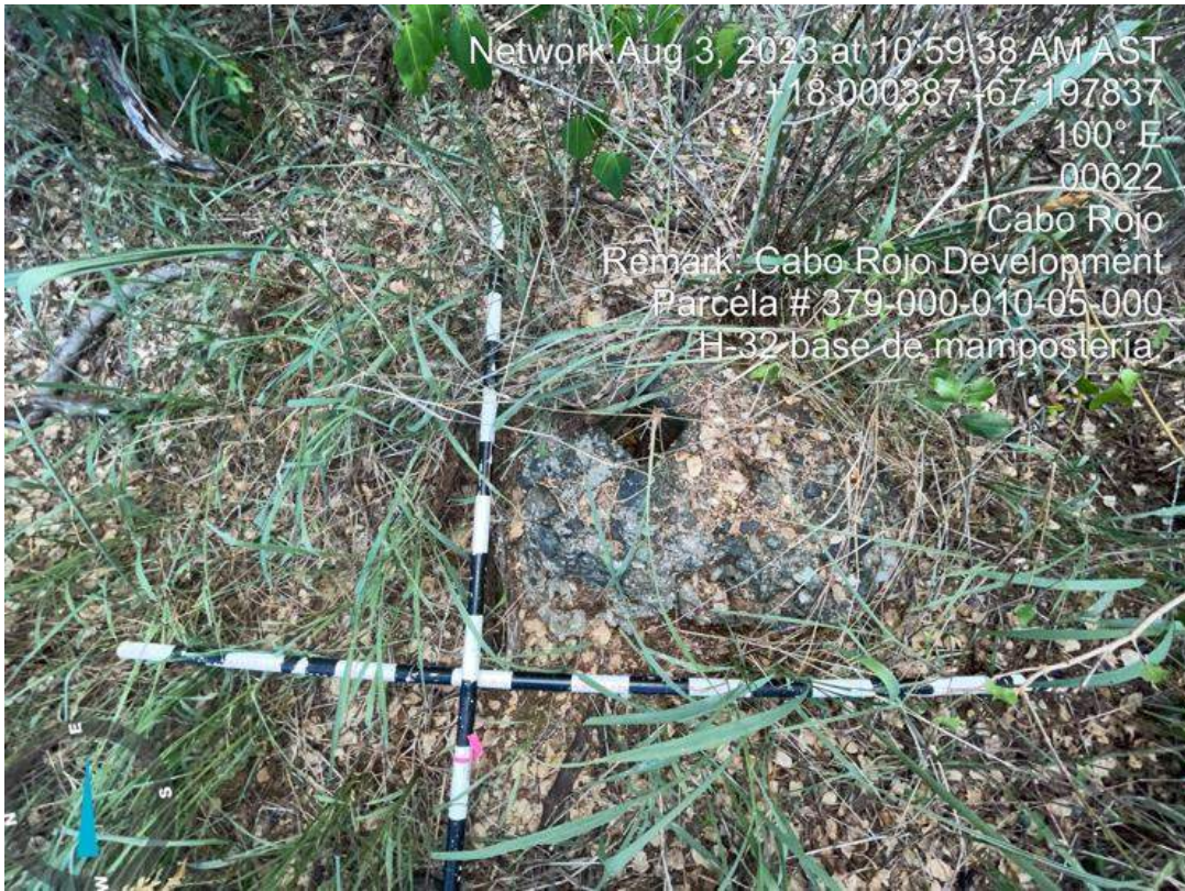
Foto 84. Elemento H-32, base de concreto armado 1.
