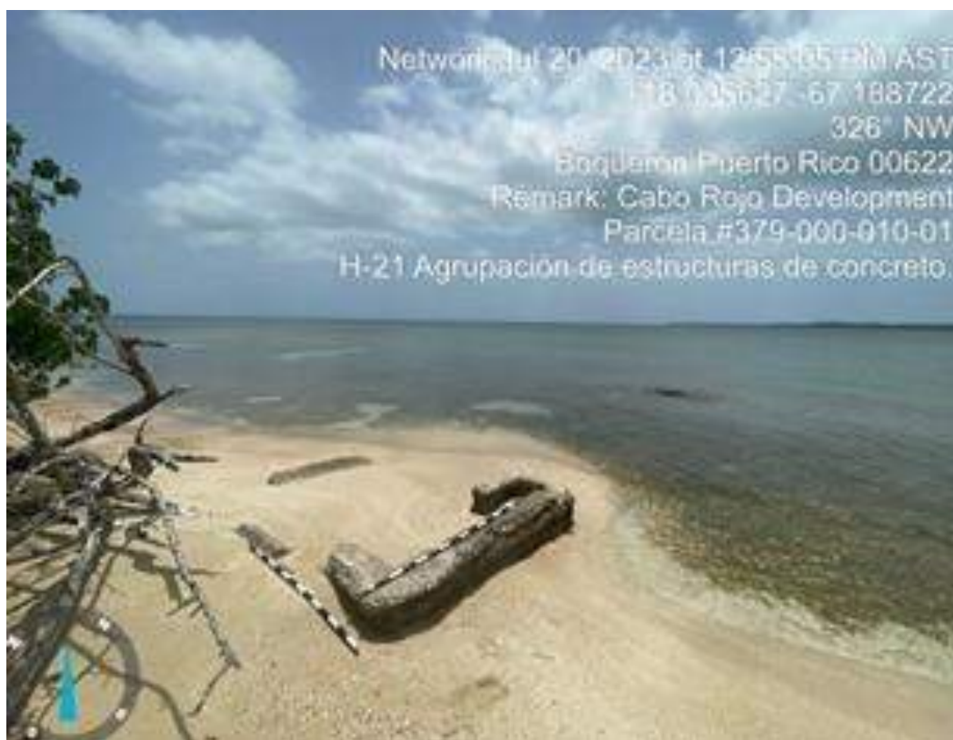
Foto 54. Elemento H-21, estructuras de concreto en playa, muelle.
