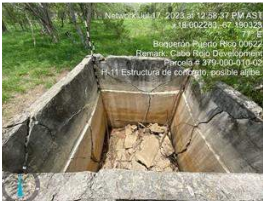
Foto 24. Elemento H-11, estructura de concreto.
