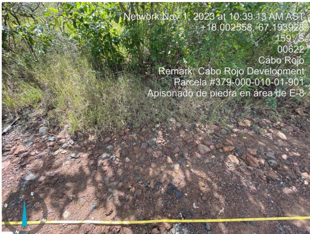
Foto 150. Apisonado de piedra en H-65.
