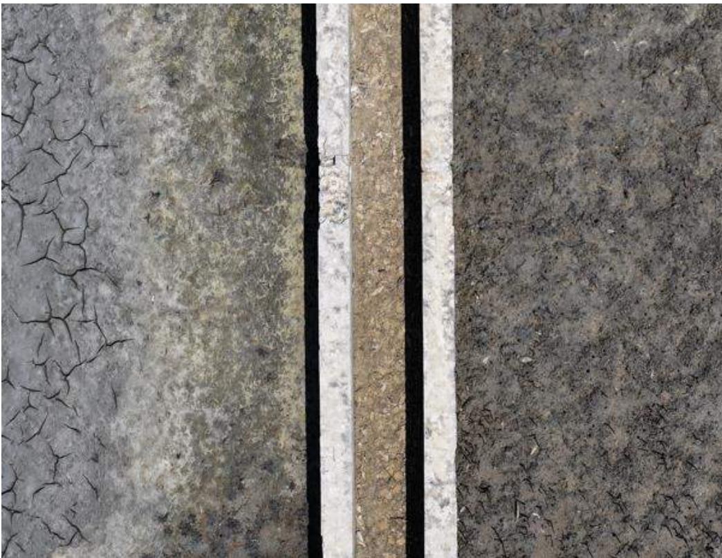
Foto 61. Elemento de concreto antiguas salinas, acercamiento.
