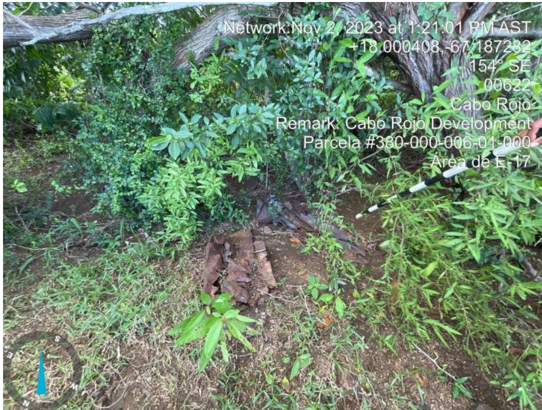
Foto 153. Materiales de construcción deteriorados.
