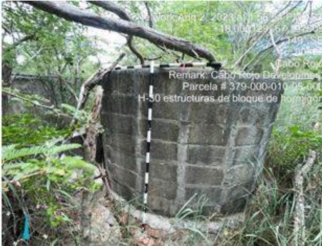
Foto 77. Elemento H-30, pozo histórico construcción mixta.
