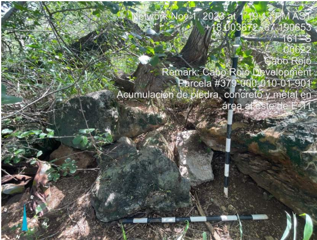
Foto 151. Escombros de concreto armado.
