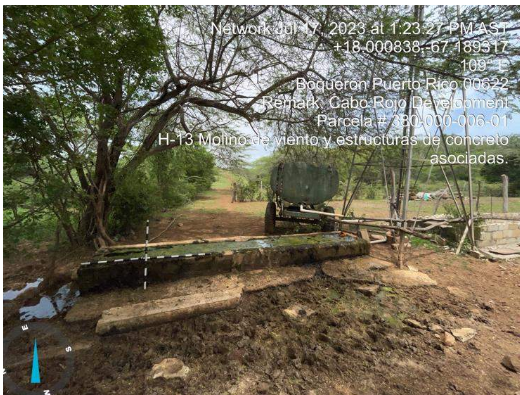
Foto 28. Elemento H-13, Molino de viento y estructuras de concreto asociadas.
