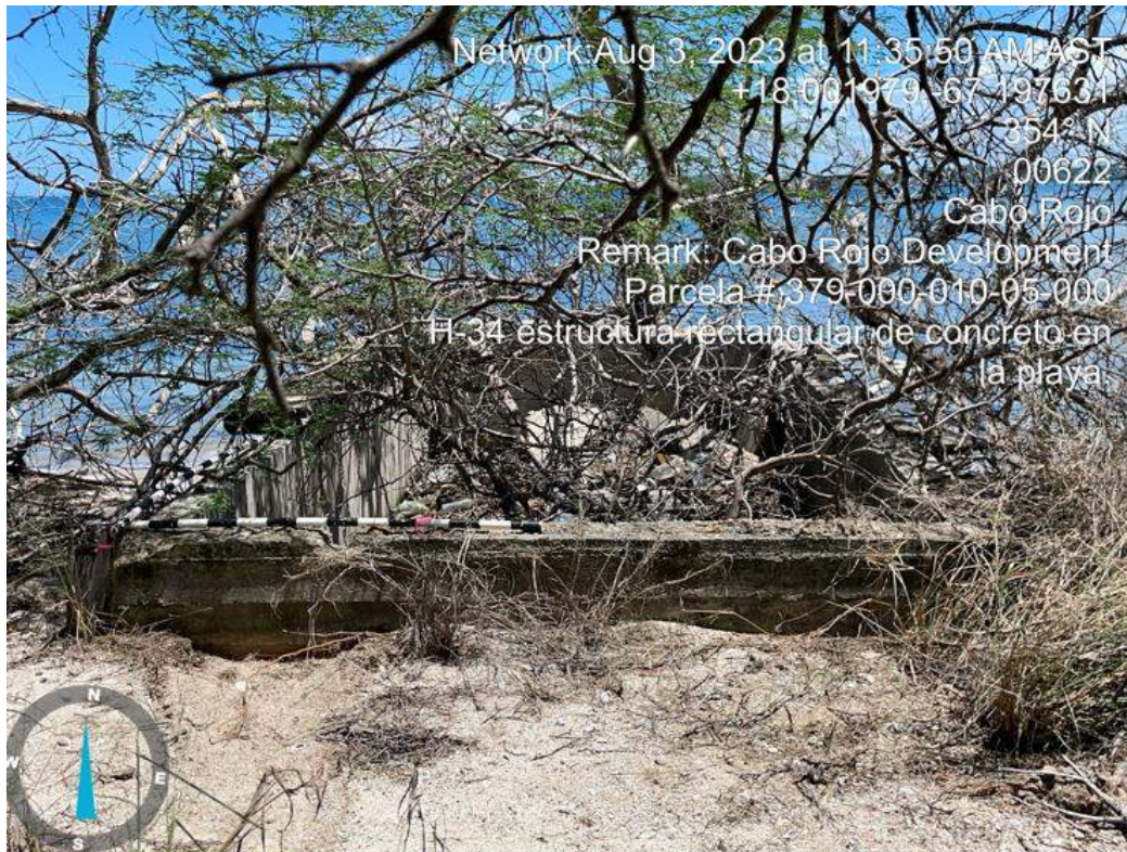
Foto 89. Elemento H-34, estructura de concreto.
