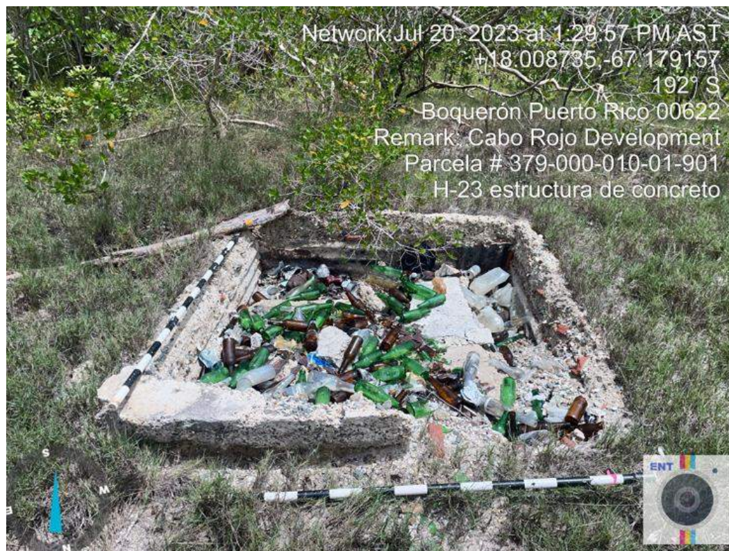
Foto 56. Elemento H-23, estructura de concreto.
