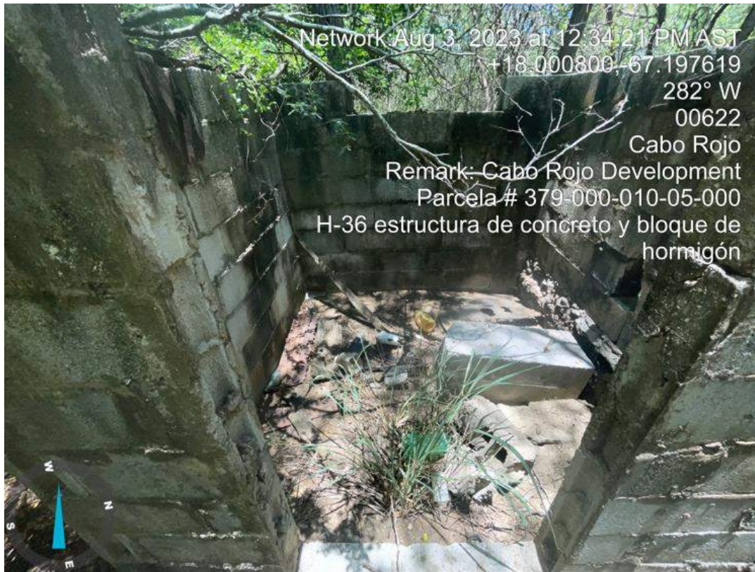
Foto 94. Elemento H-36, estructura de concreto.
