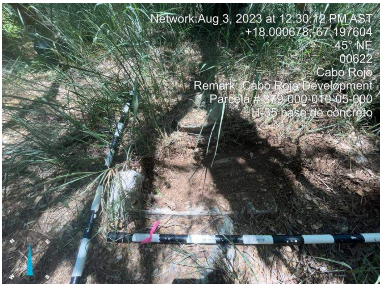
Foto 92. Elemento H-35, base de concreto.
