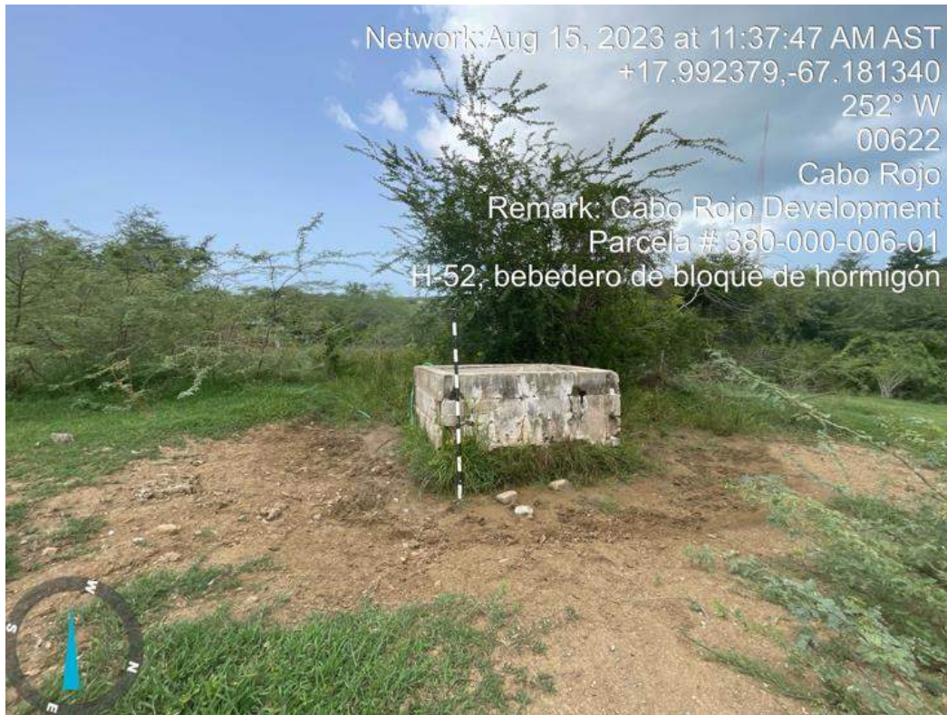
Foto 124. Elemento H-52, abrevadero de hormigón.
