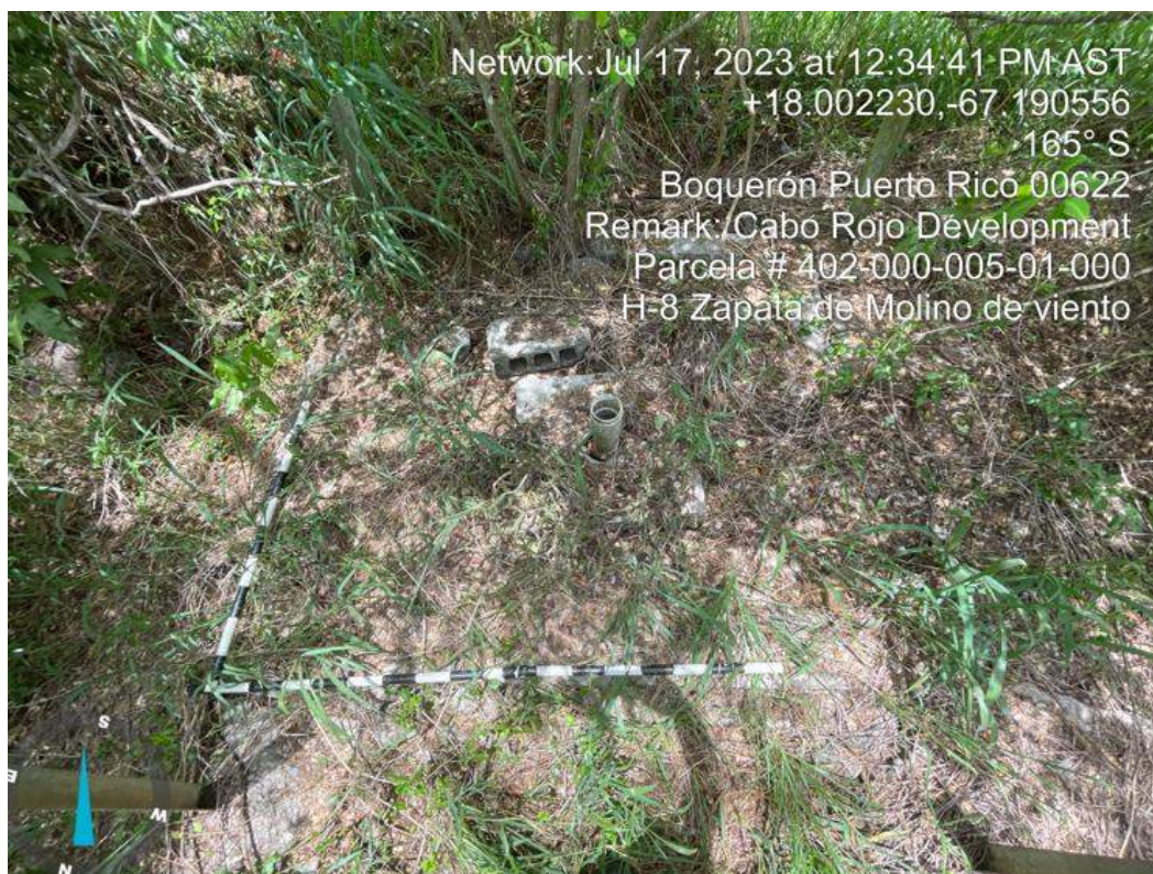
Foto 18. Elemento H-8, zapata de molino de viento.
