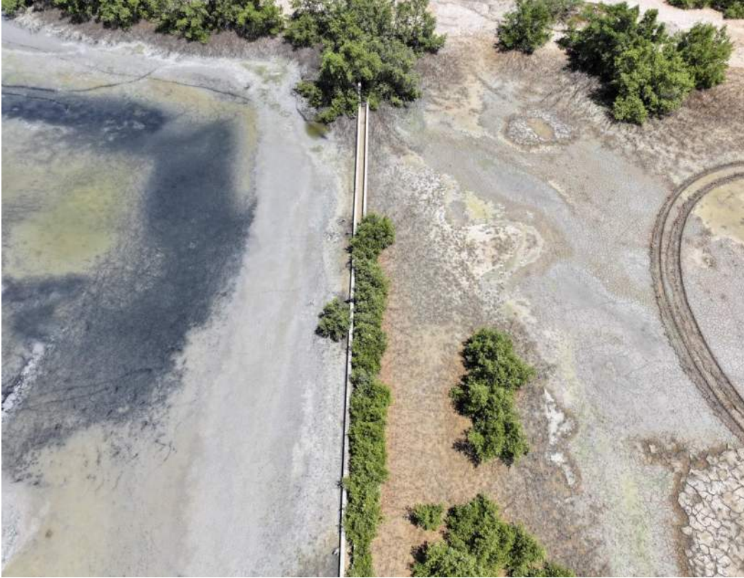
Foto 60. Elemento de concreto atravesando antiguas salinas.
