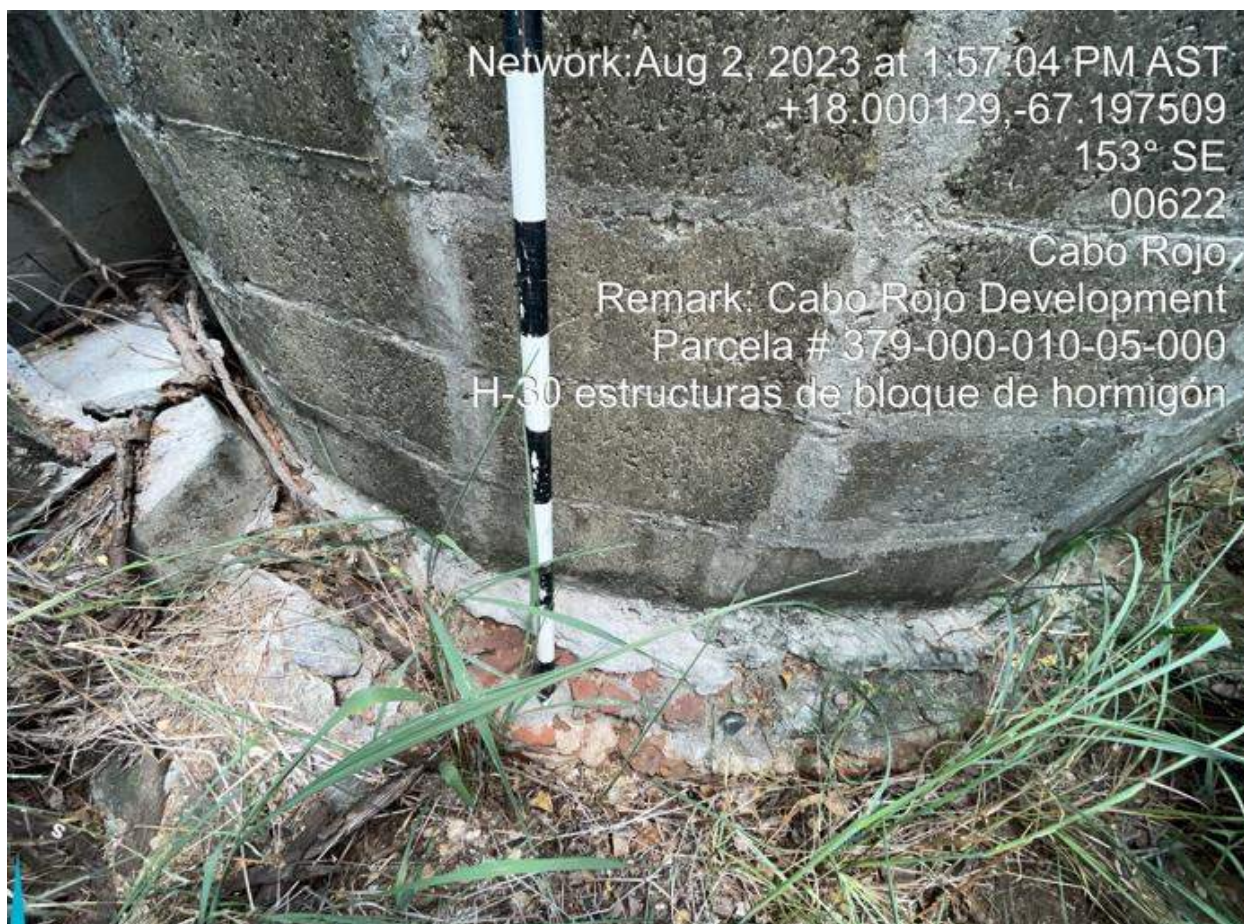
Foto 79. Elemento H-30, pozo histórico construcción mixta, ladrillos y argamasa en desde la superficie del suelo hacia abajo.
