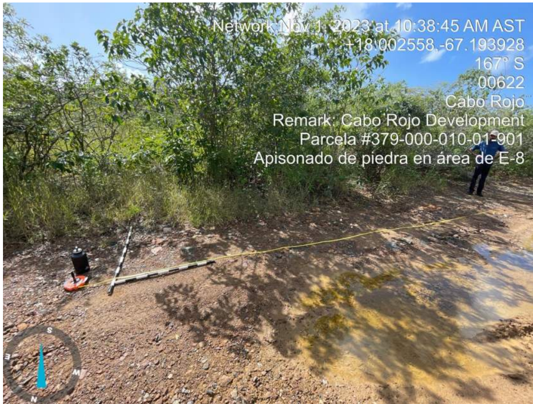
Foto 149. Apisonado de piedra en H-65.
