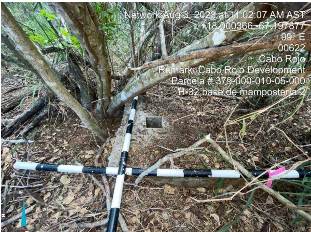
Foto 85. Elemento H-32, base de concreto armado 2.
