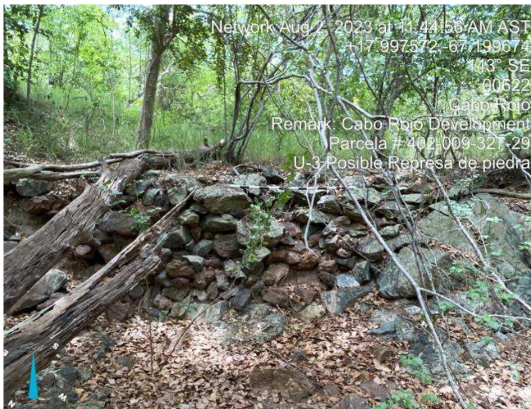
Foto 162. Dique o muro de piedra.
