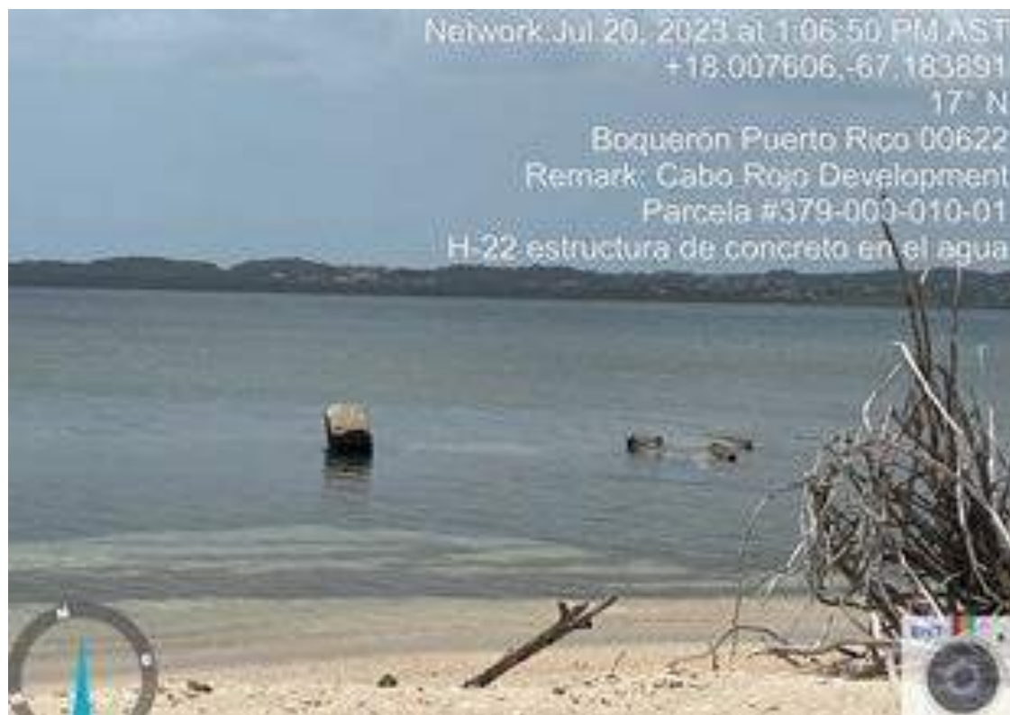
Foto 55. Elemento H-22, remanentes de posible muelle.
