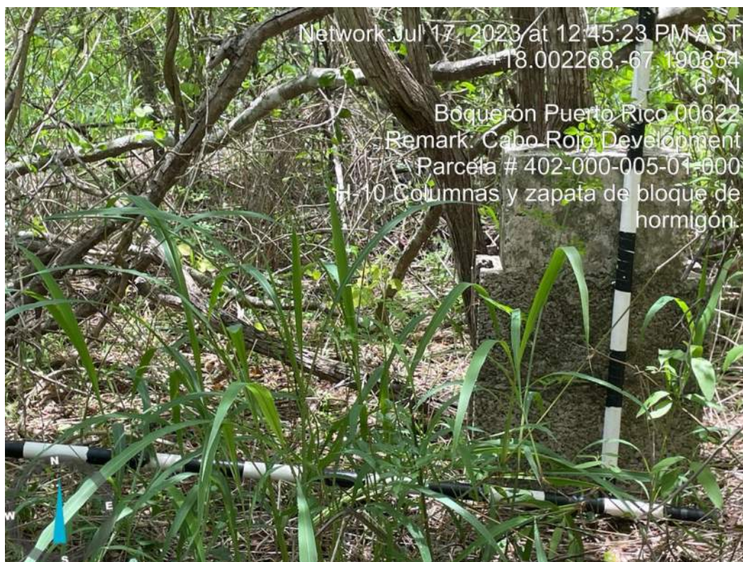
Foto 21. Elemento H-10, columnas y zapata de hormigón.
