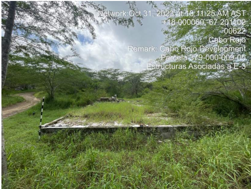
Foto 147. Zapata de estructura demolida
