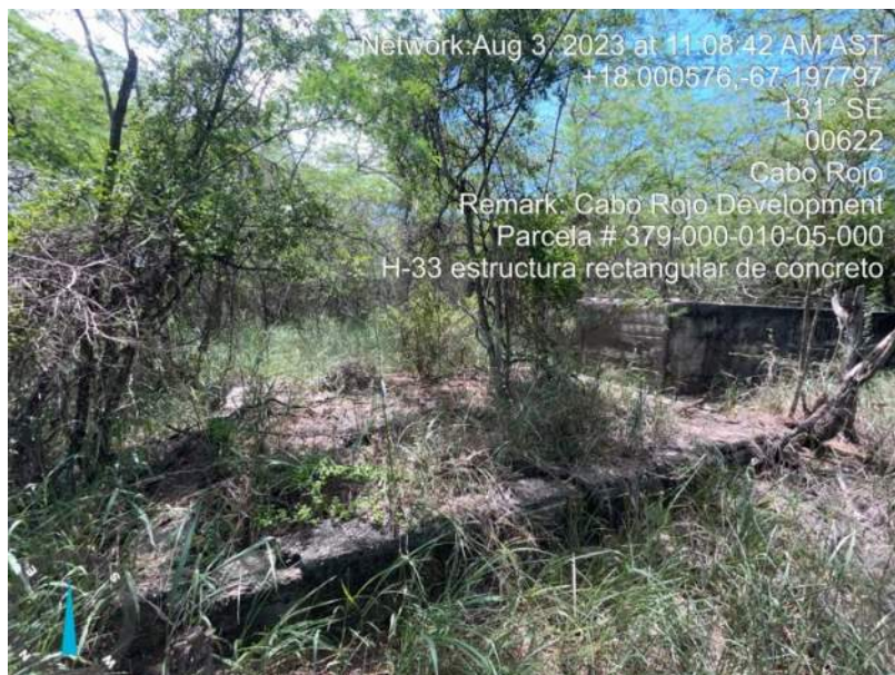
Foto 88. Elemento H-33, estructura rectangular de concreto.
