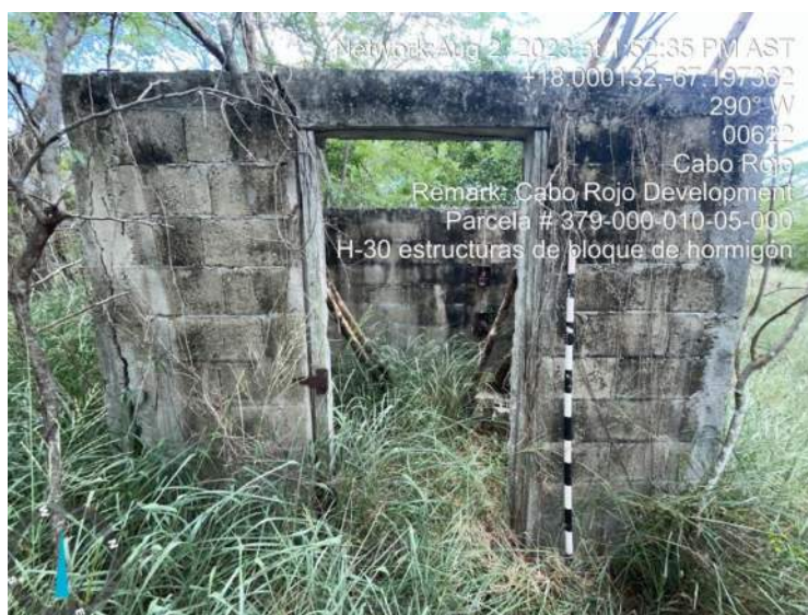
Foto 81. Elemento H-30, estructuras de bloque.
