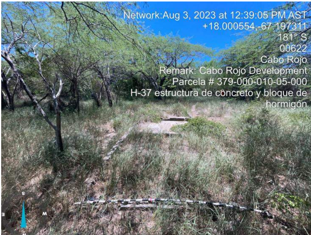
Foto 96. Elemento H-37, estructura en concreto.
