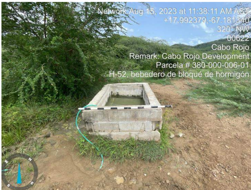
Foto 125. Elemento H-52, abrevadero de hormigón.
