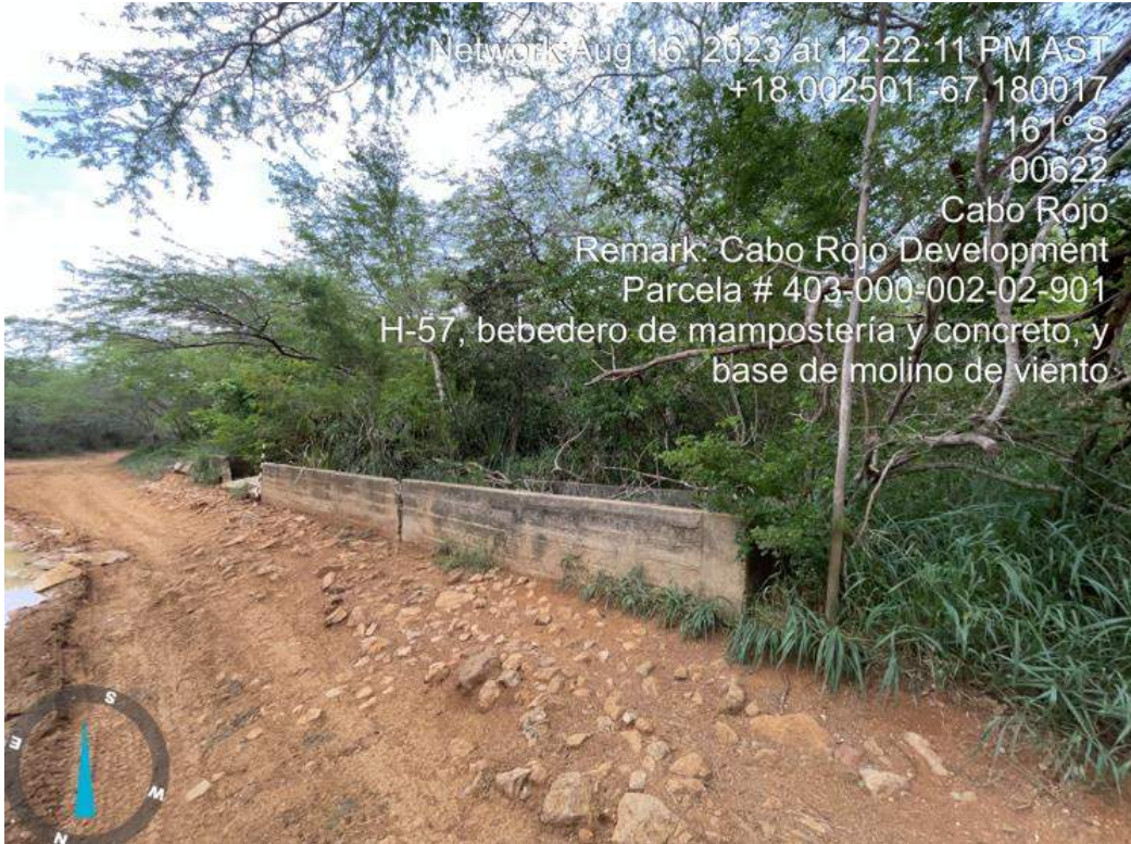
Foto. 134. Elemento H-57, bebedero de concreto armado.
