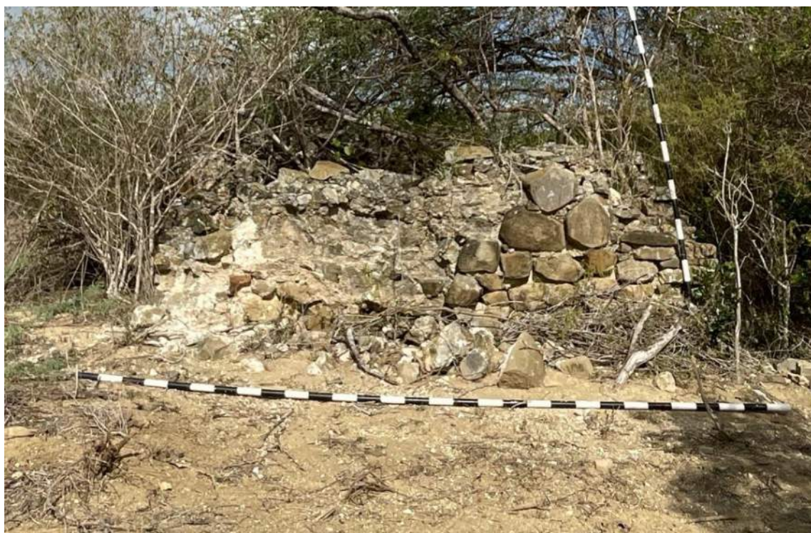
Foto 63. Elemento H-25, pozo de piedra con mampostería y ladrillos.
