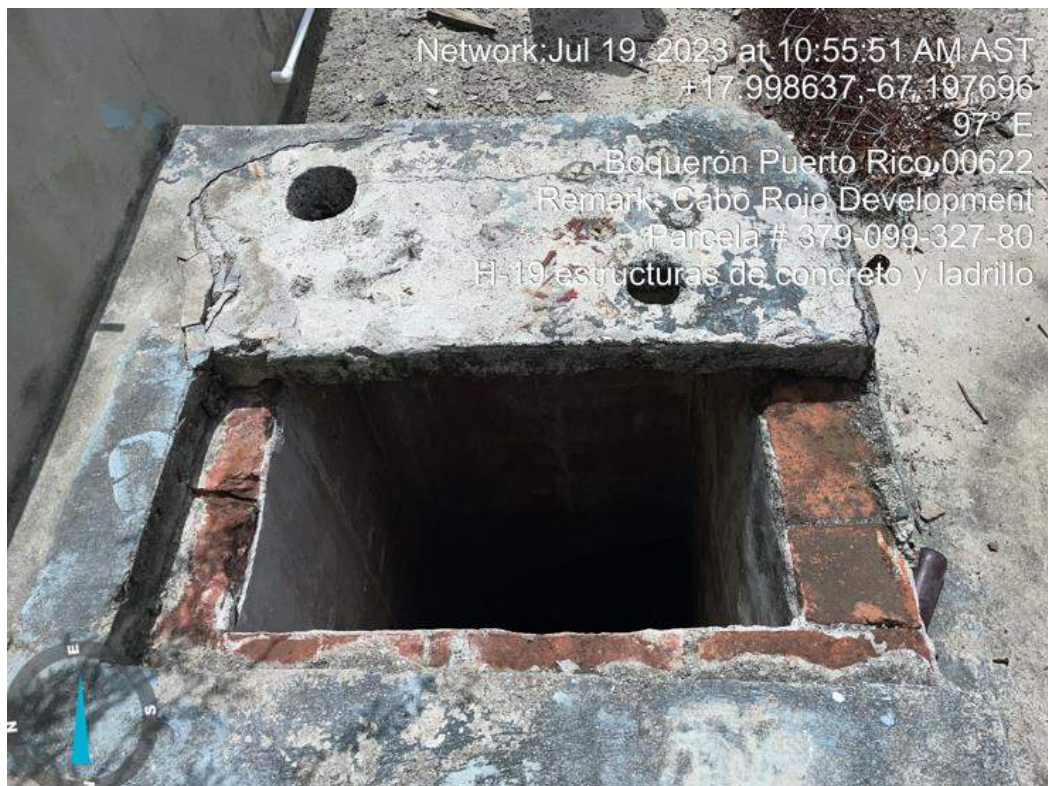
Foto 44. H-19, estructura de concreto y ladrillo, boca del aljibe.
