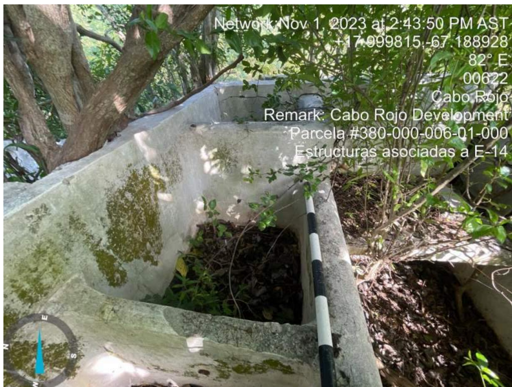
Foto 32. Estructura de concreto asociada al elemento H-14.
