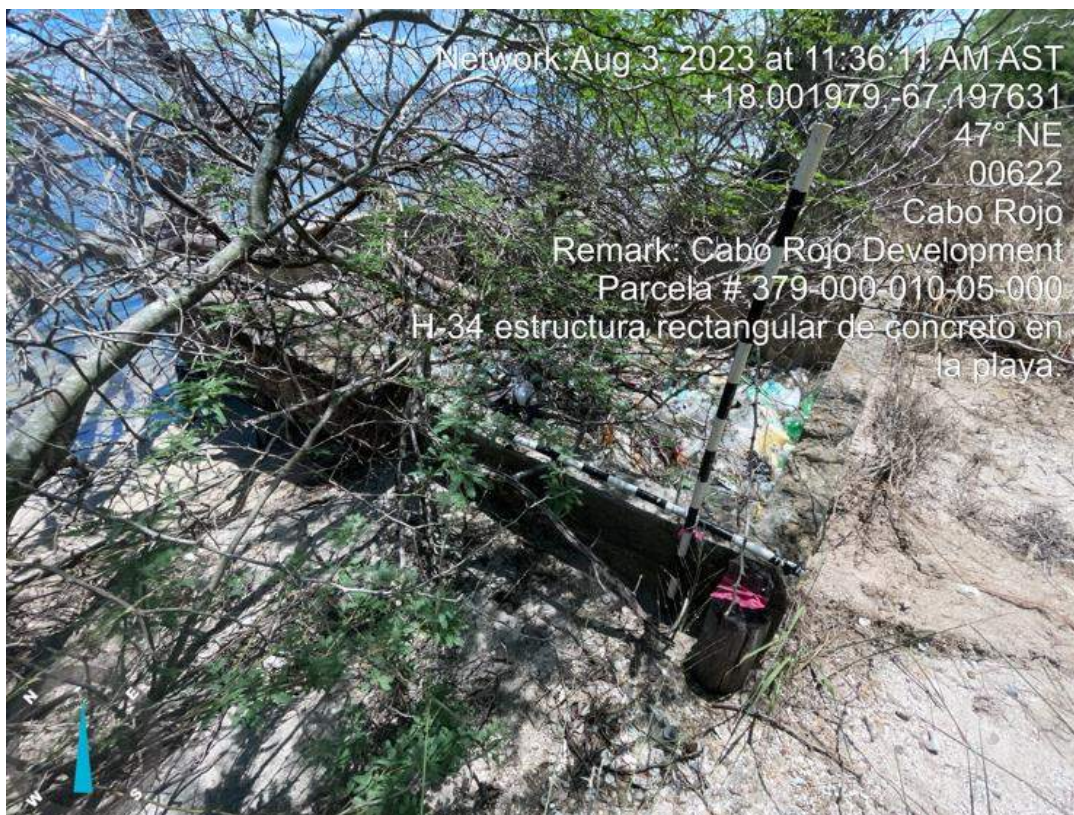
Foto 91. Elemento H-34, estructura de concreto.
