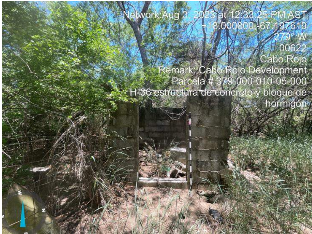
Foto 93. Elemento H-36, estructura de concreto.
