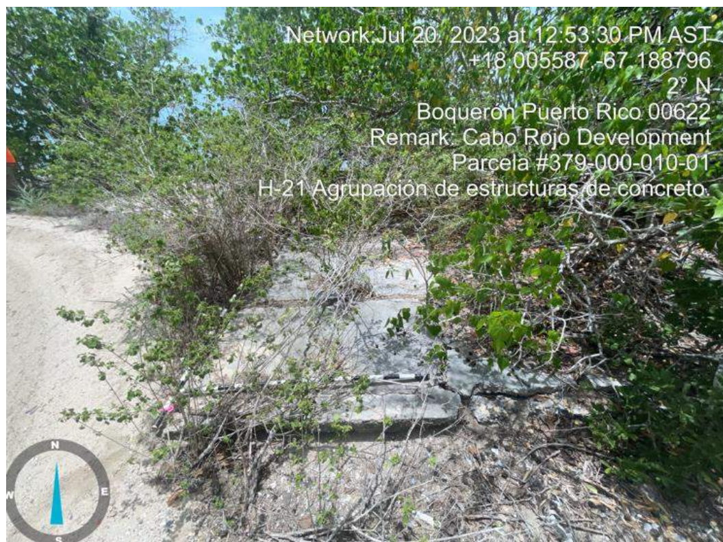
Foto 52. Elemento H-21, estructuras de concreto.
