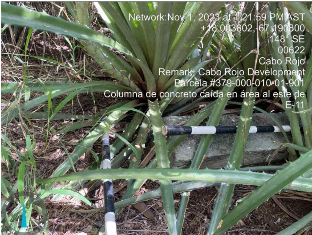
Foto 152. Escombros de concreto armado.
