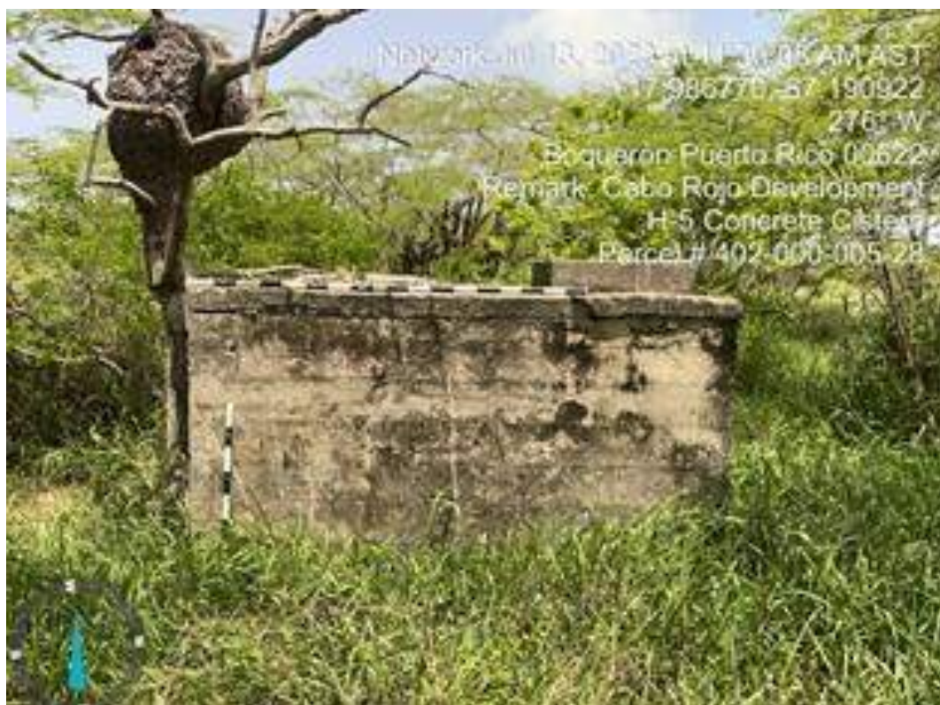
Foto 11. Elemento H-5, cisterna de concreto.
