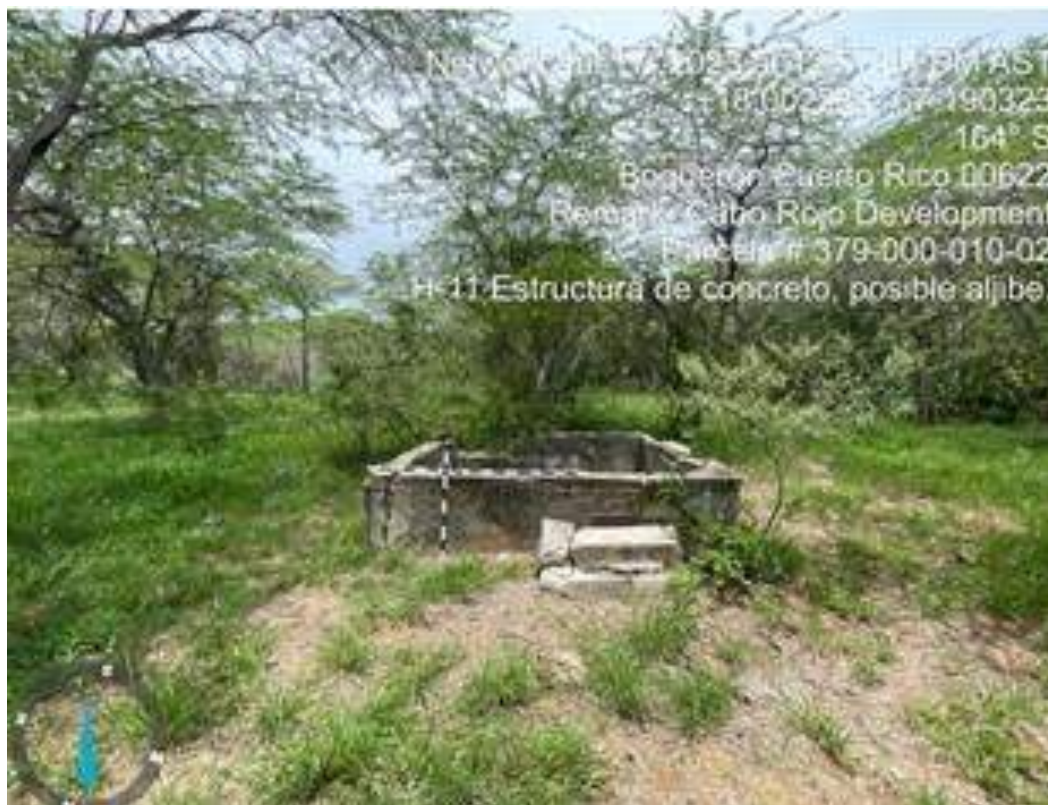
Foto 23. Elemento H-11, estructura de concreto.
