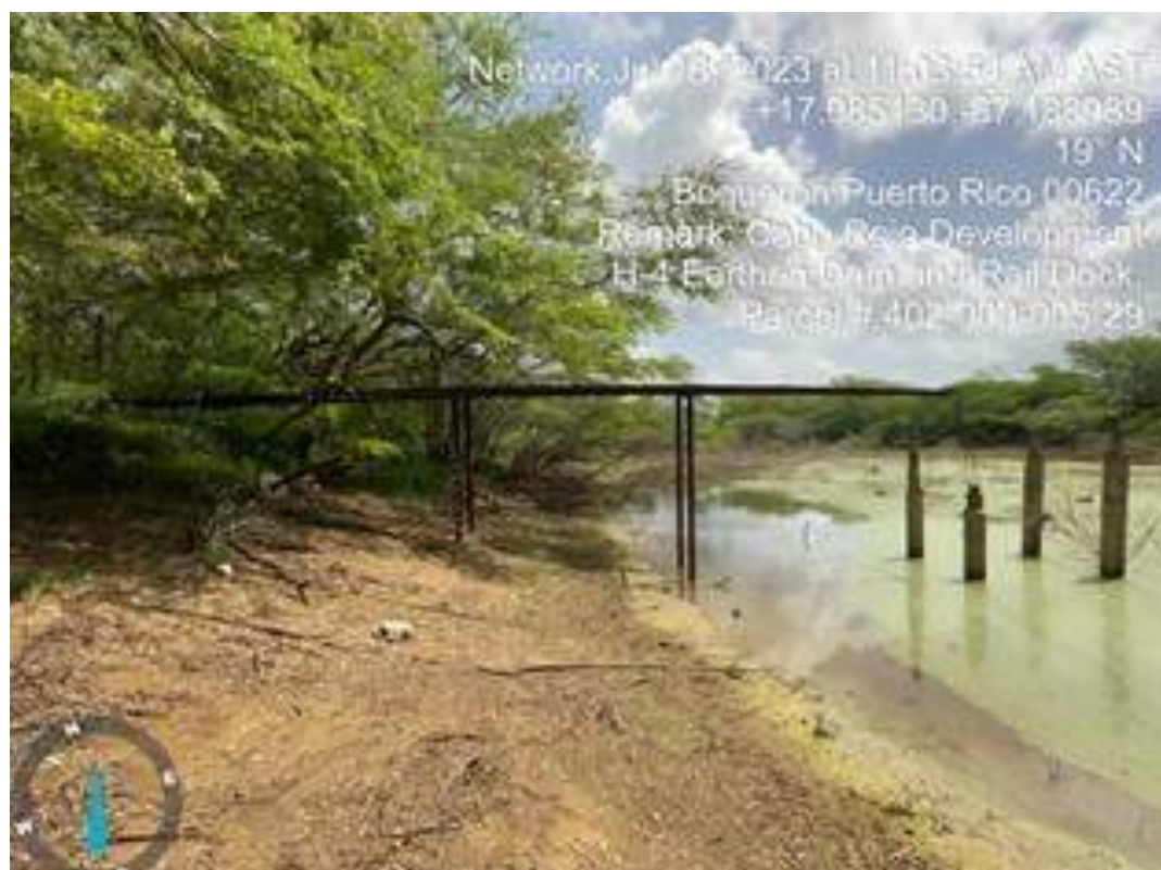
Foto 10. Elemento H-4, muelle construido con rieles históricos de tren.
