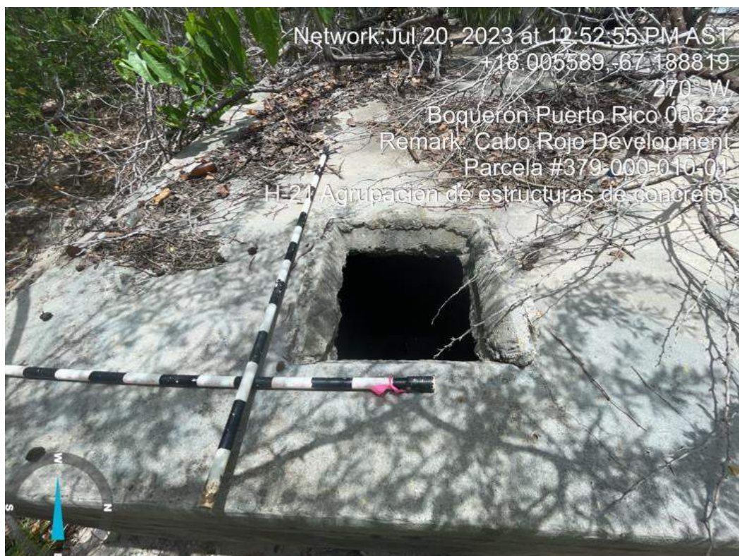
Foto 53. Estructura de concreto.
