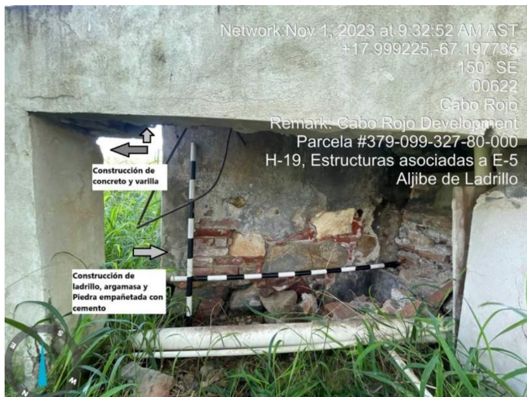
Foto 46. Elemento H-19, estructura de concreto y ladrillo, empañetado y columnas en adición de concreto.
