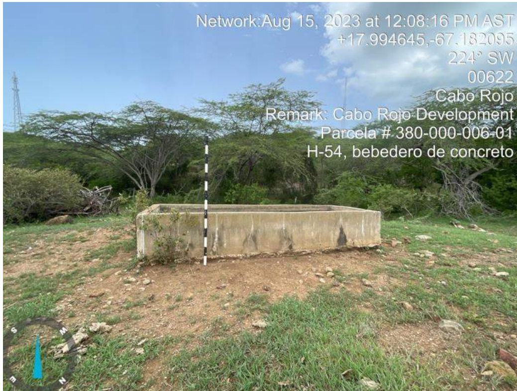
Foto 128. Elemento H-54, bebedero de concreto.
