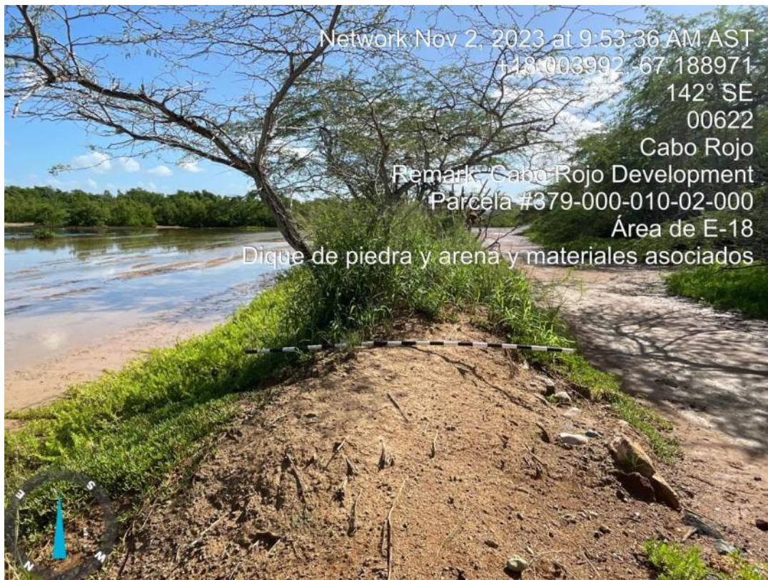
Foto 156. Dique de piedra y arena.
