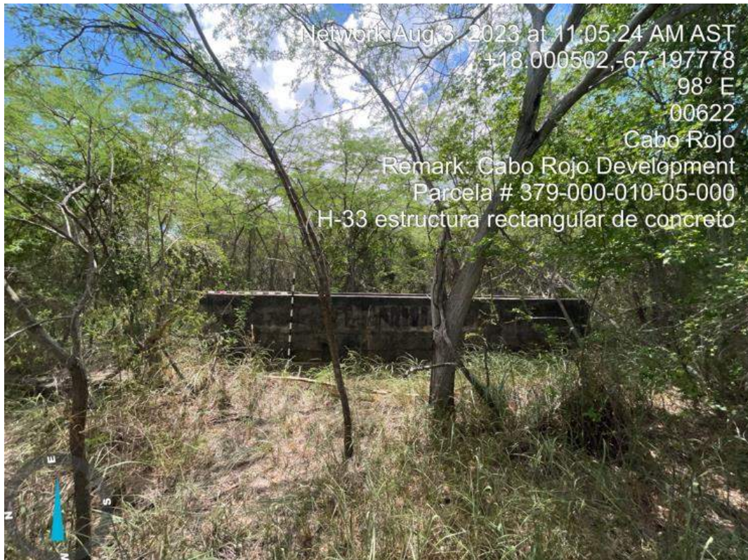
Foto 86. Elemento H-33, tina en concreto para ganado.
