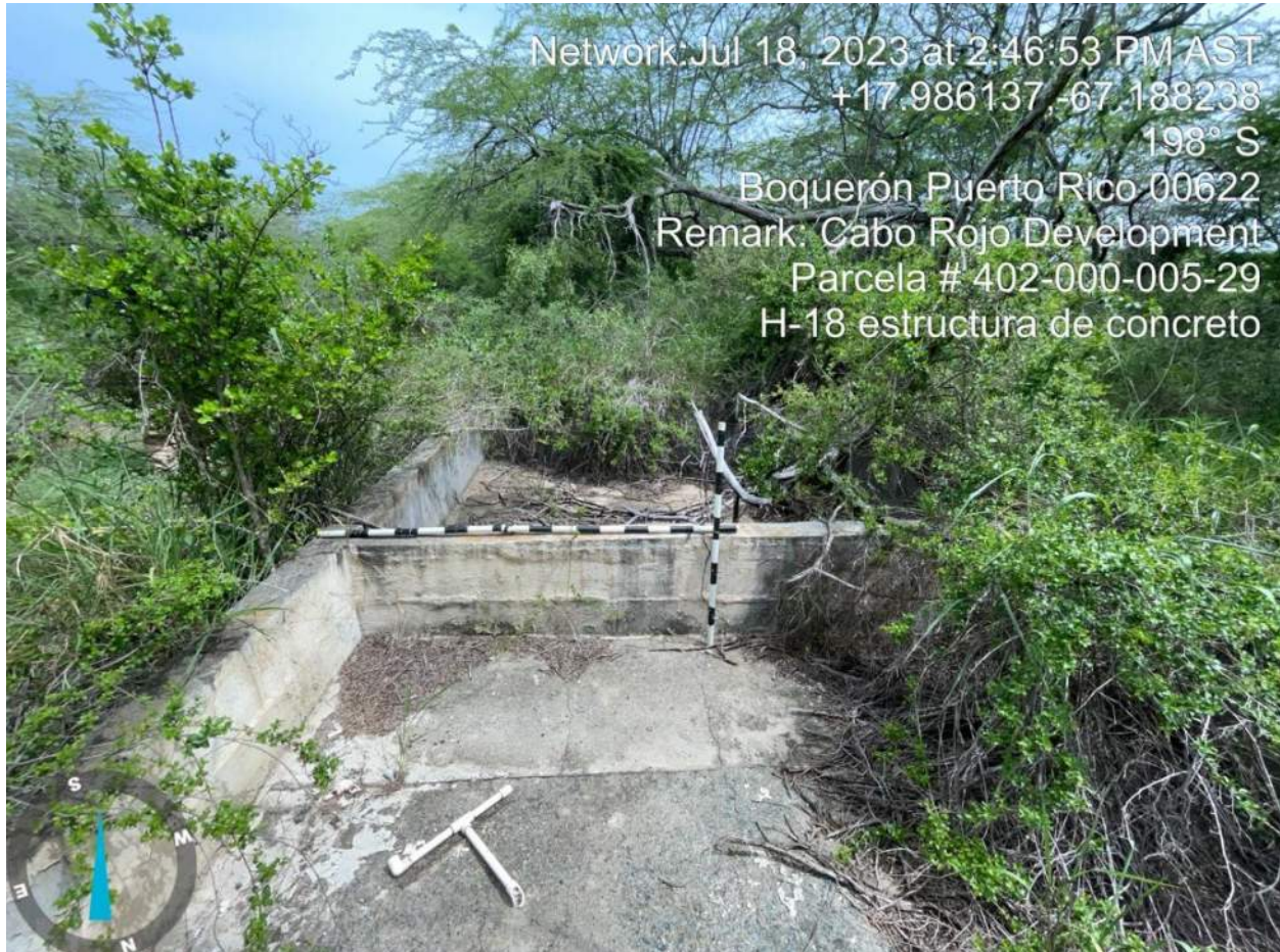
Foto 38. Elemento H-18, estructura de concreto.
