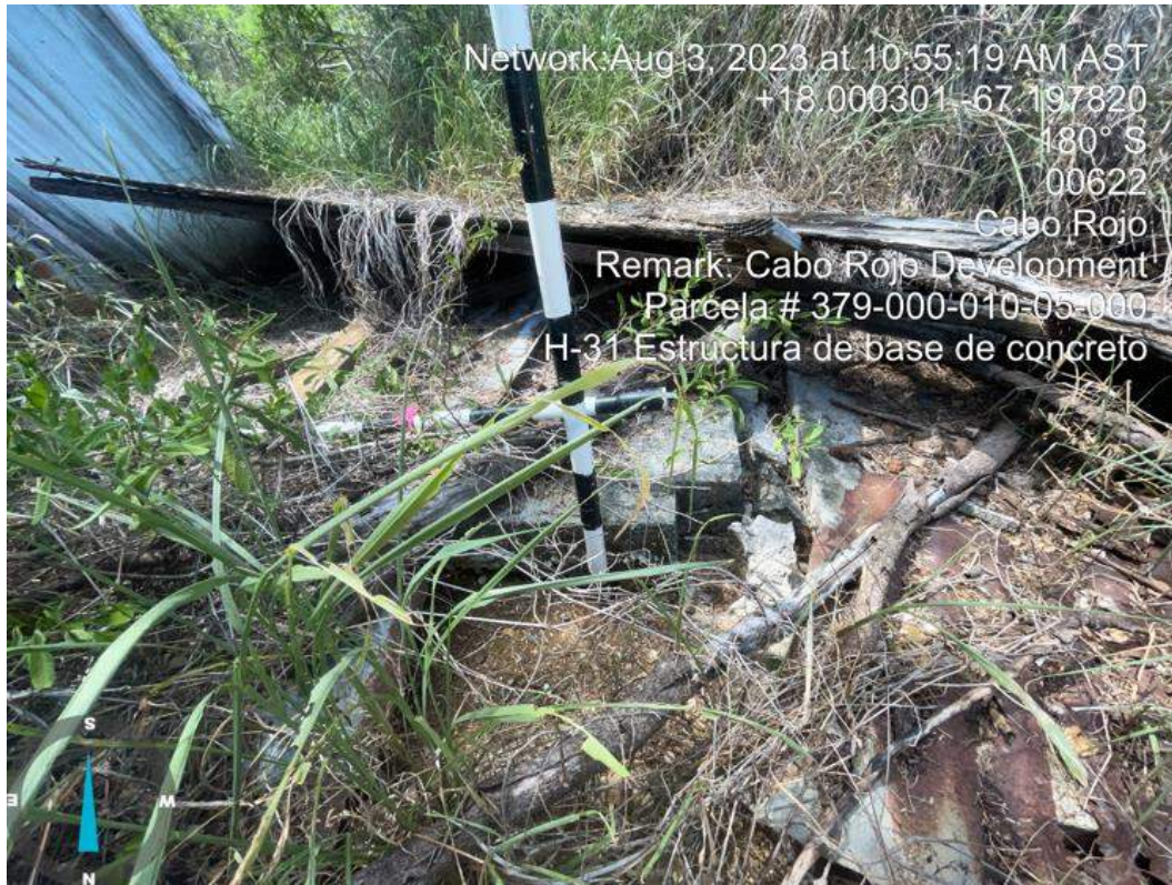
Foto 82. Elemento H-31, estructura de concreto.
