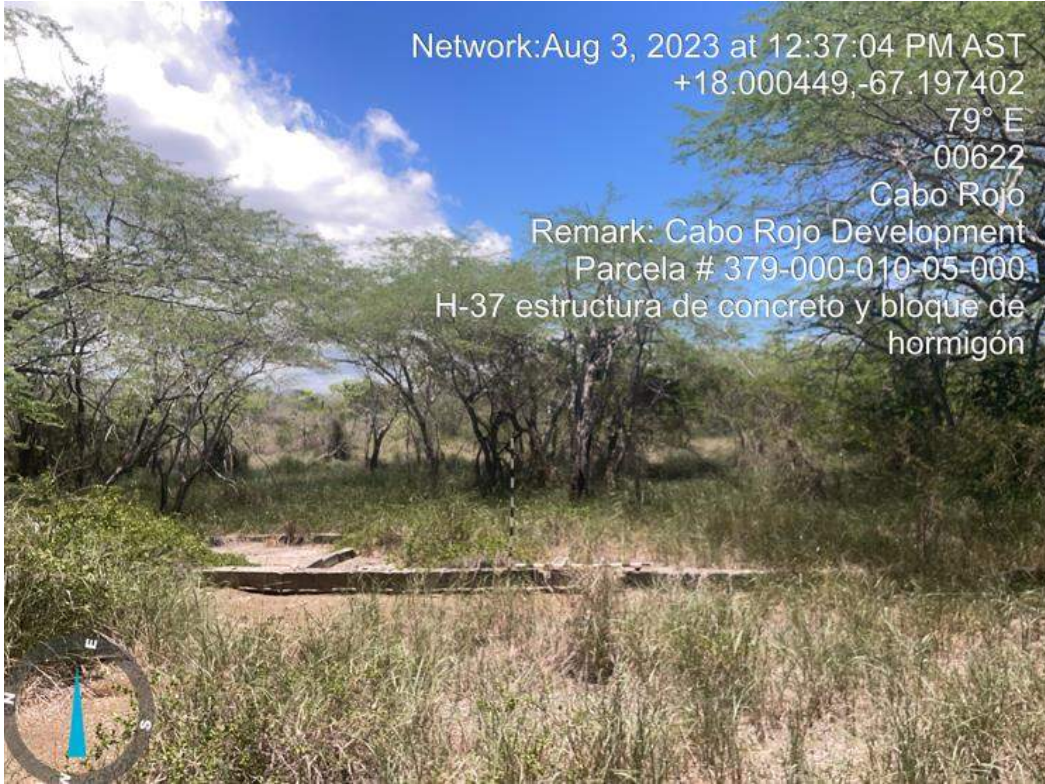
Foto 95. Elemento H-37, estructura en concreto.
