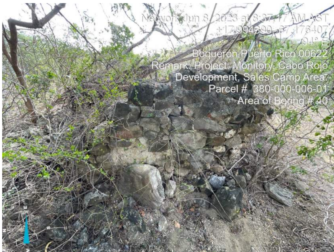
Foto 64. Elemento H-25, pozo de piedra con mampostería y ladrillos.
