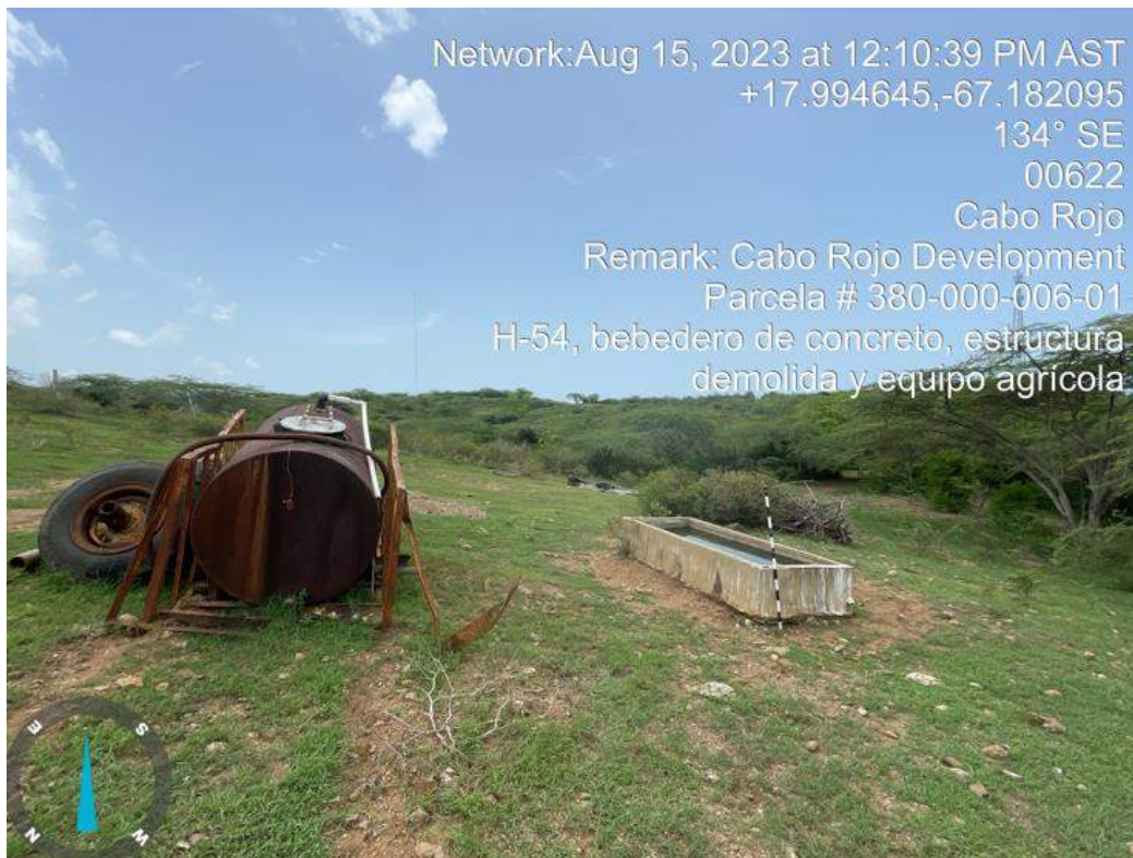
Foto 129. Elemento H-54, bebedero de concreto y maquinaria agrícola.
