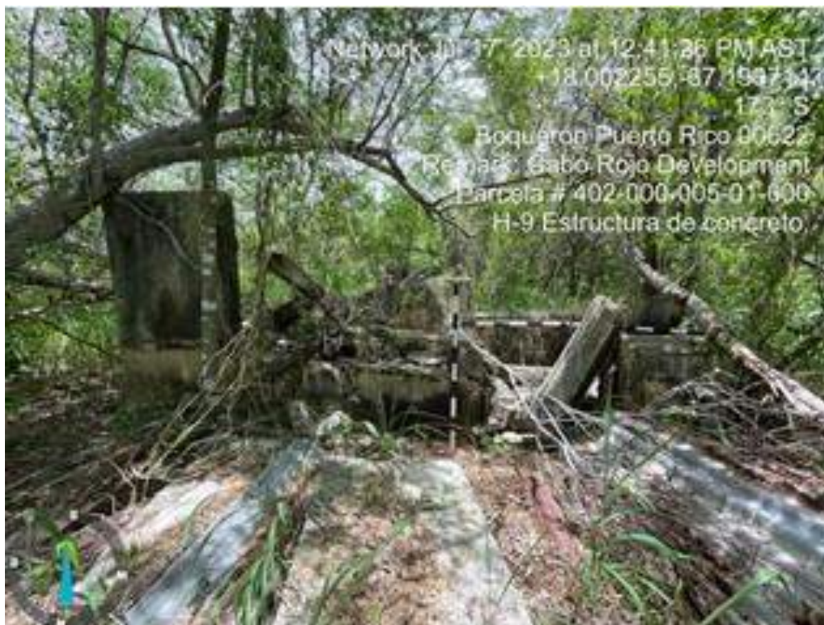
Foto 20. Estructura de concreto.
