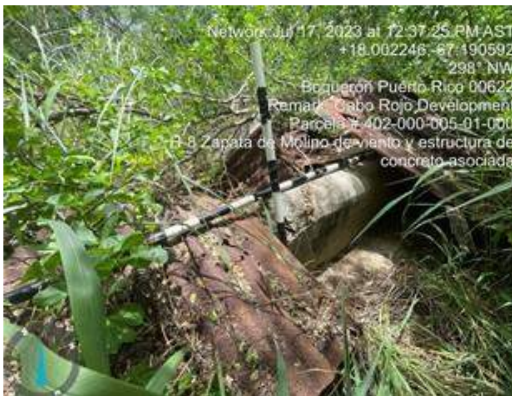
Foto 19. Elemento H-8, estructura asociada a zapata de molino de viento.
