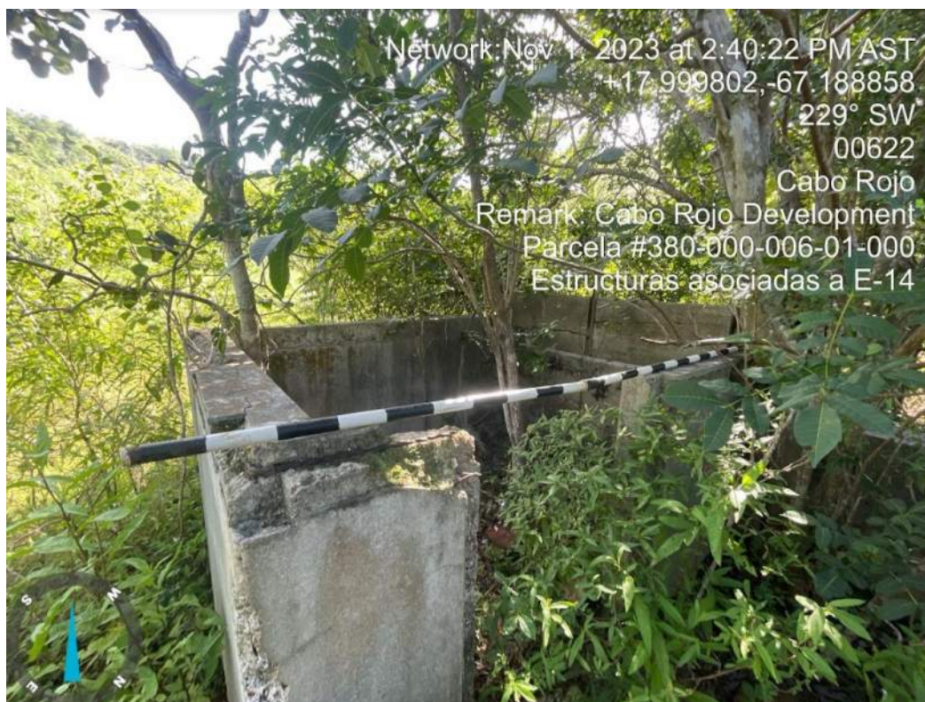
Foto 30. Estructura de concreto asociada al elemento H-14.
