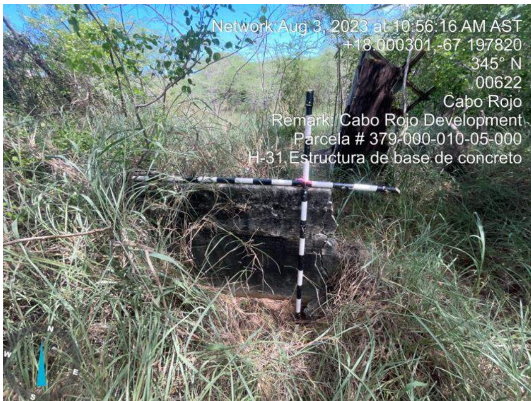
Foto 83. Elemento H-31, estructura de concreto.
