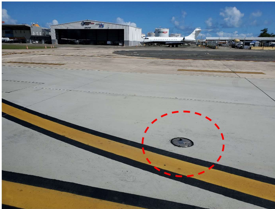
Ilustración 6: Luminaria sobre la superficie del Taxiway "N".
