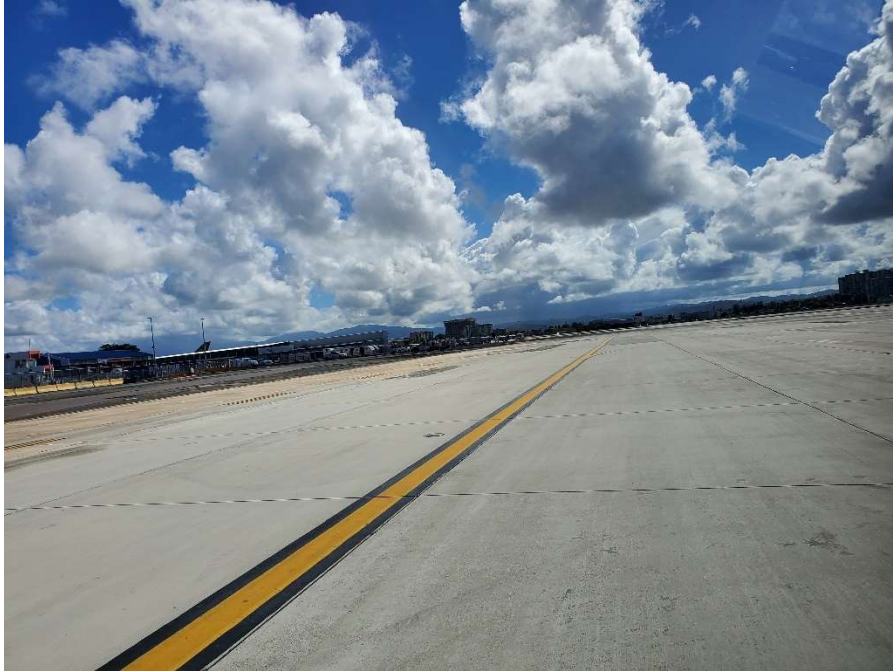
Ilustración 5: Sobre el Taxiway "N".
