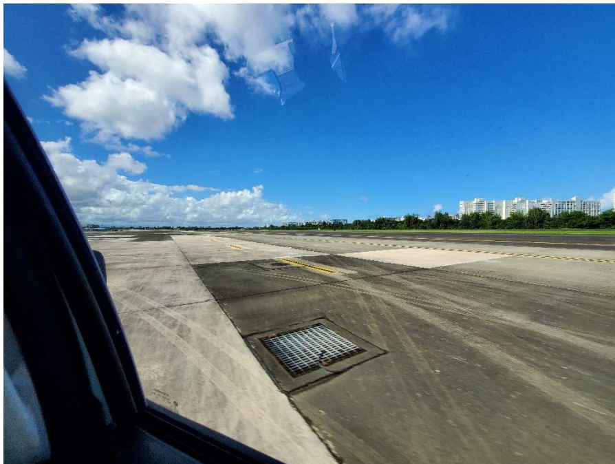
Ilustración 17: Taxiway "S" – reparación de superficie en concreto
