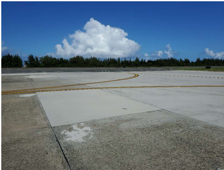
Ilustración 14: Taxiway "N" – reparación de superficie en concreto
