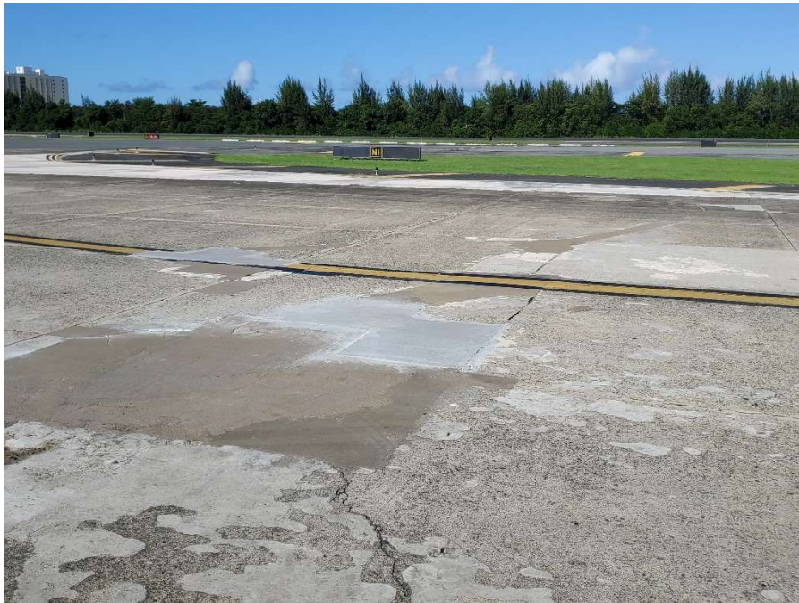
Intersección entre Taxiway "N" y Taxiway "S" – reparación de superficie en concreto
