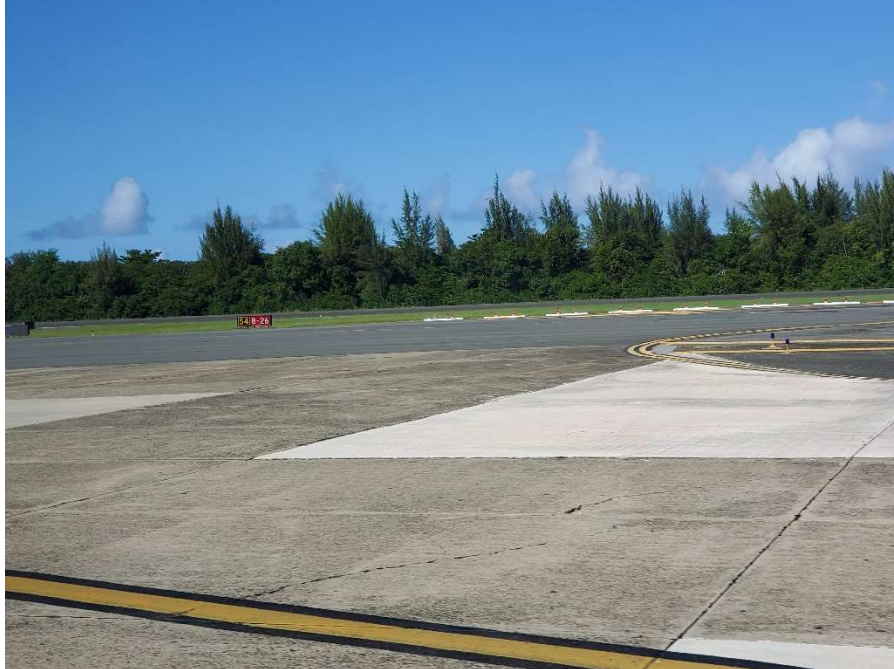
Ilustración 16: Taxiway "S" – reparación de superficie en concreto
