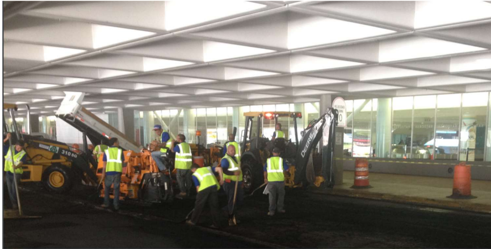
Ilustración 2: Reparación de vía de rodaje, 2 de 2
