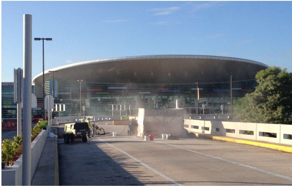
Ilustración 1: Reparación de vía de rodaje, 1 de 2
