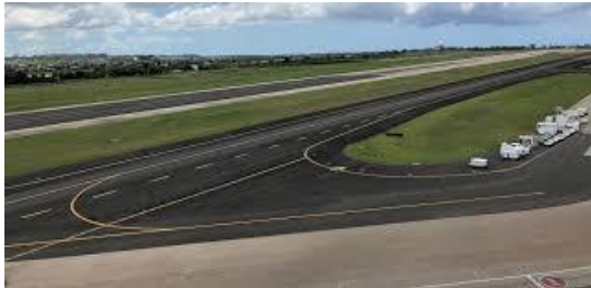
Vista parcial de la Pista 8-26 del aeropuerto de Aguadilla
