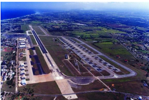
Vista aérea del aeropuerto de Aguadilla
