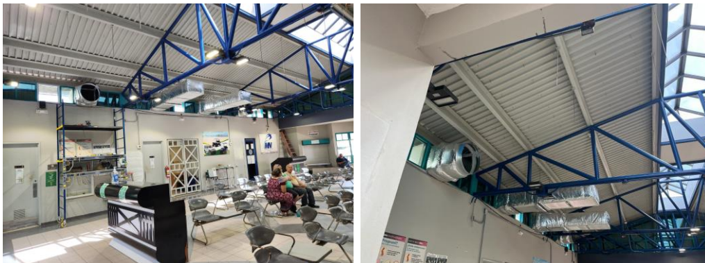
Vista parte de los trabajos para la instalación del nuevo sistema de acondicionador de aire.
